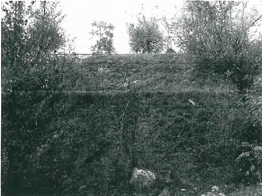
FOTO 3 - Sistemazione scarpata laterale strada "Buco del frate" con distribuzione terreno vegetale e relativa semina.
