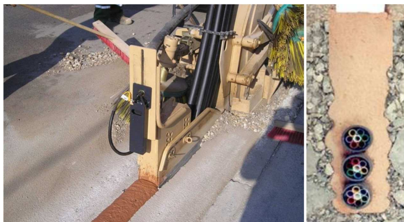
Esempio riempimento con conglomerato cementizio e sua colorazione (immagini da Norma UNI/PdR 7:2014)
