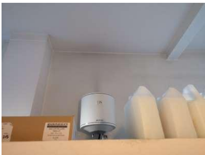
Figura 2 – Scaldacqua elettrico
