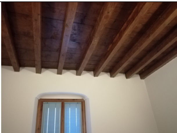
Figura 17 – solaio in legno: vista dall'intradosso
