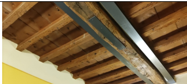
Figura 26 – particolare del rinforzo della trave lignea del solaio a copertura dell'ufficio polizia locale al piano terra
