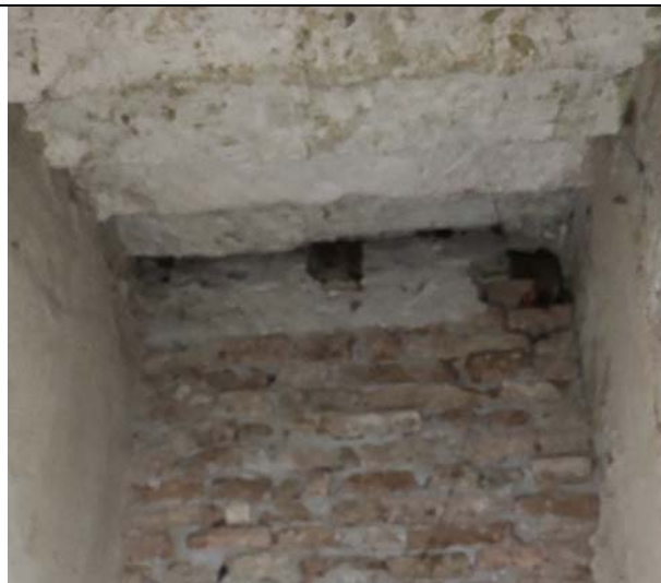
Figura 16 – muratura: particolare della tessitura muraria (locale sottoscala)
