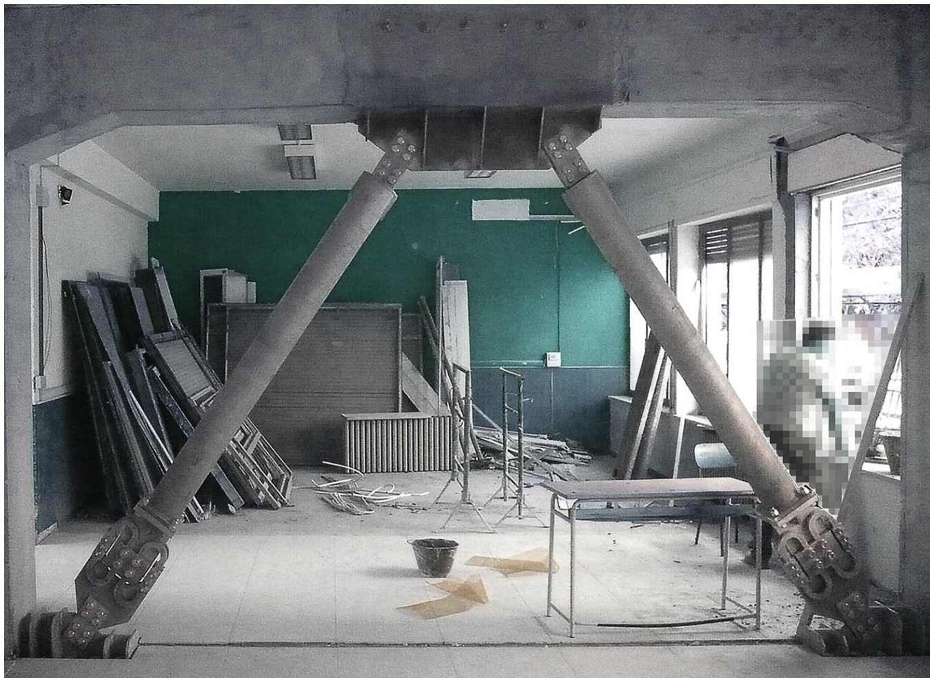
Installazione di controventi dissipativi
