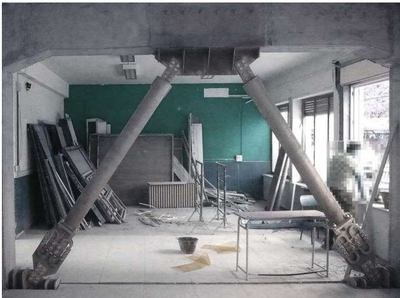
Installazione di controventi dissipativi
