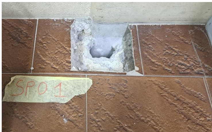
Saggio SP01: solaio di calpestio piano interrato
