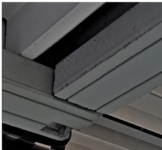
Trave a T rovescia in copertura (a sinistra) e in palestra (a destra)
