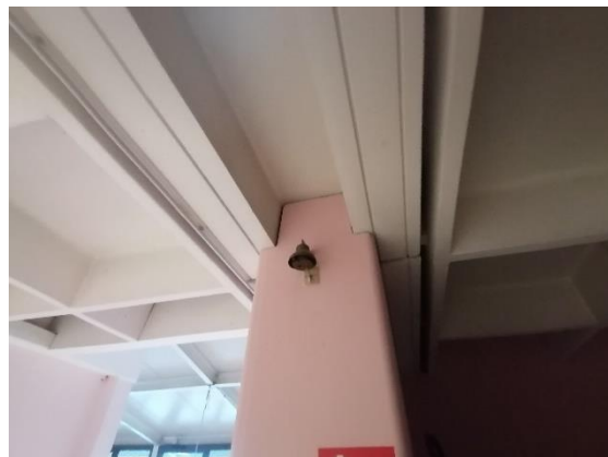
Particolari nodi travi-pilastri (piano interrato con sella e piano primo senza sella)
