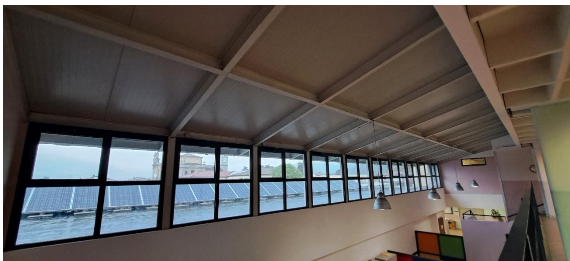
Copertura metallica di raccordo
