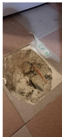
Saggio SP02: solaio di calpestio piano rialzato
