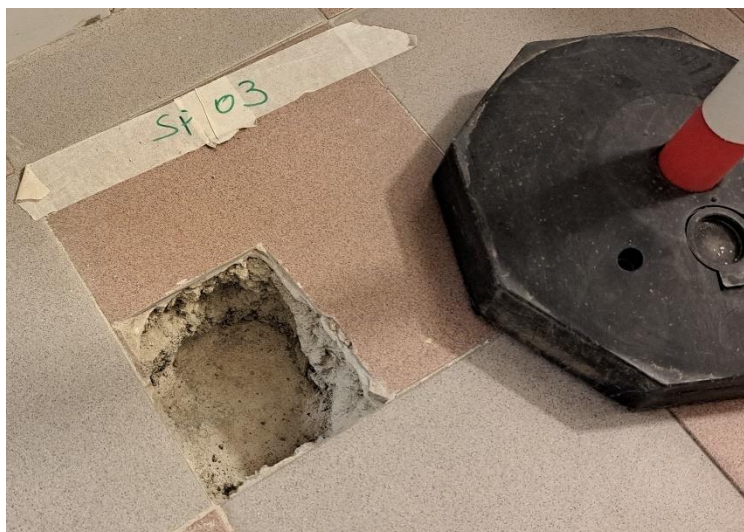
Saggio SP03: solaio di calpestio piano rialzato
