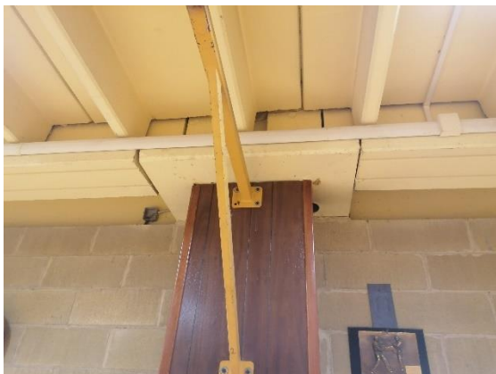
Particolari nodi travi-pilastri (piano interrato con sella e piano primo senza sella)
