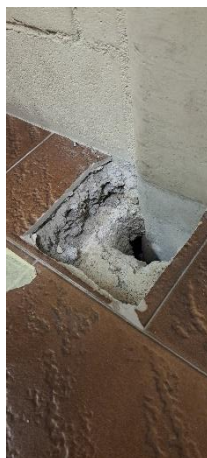
Saggio SP01: solaio di calpestio piano interrato
