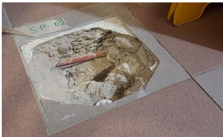
Saggio SP02: solaio di calpestio piano rialzato
