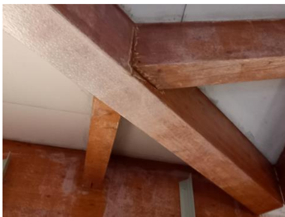
Infiltrazioni sul solaio di copertura dell'edificio storico e stato di conservazione della guaina estradossale
