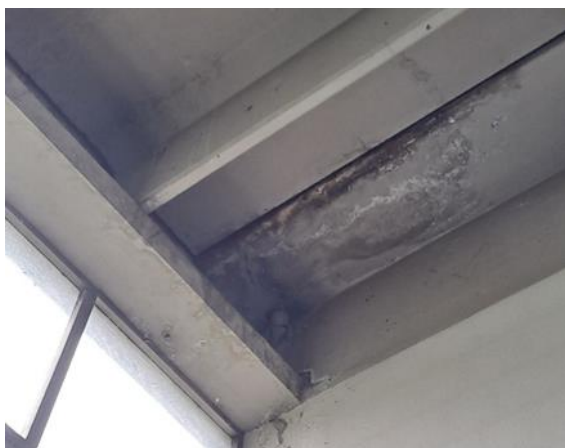
Infiltrazioni sul solaio di copertura della palestra e stato di conservazione della guaina estradossale
