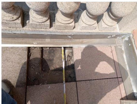
Infiltrazioni su solaio del portico d'ingresso e stato di conservazione della guaina estradossale
