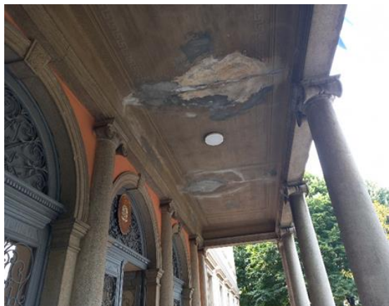
Infiltrazioni su solaio del portico d'ingresso e stato di conservazione della guaina estradossale
