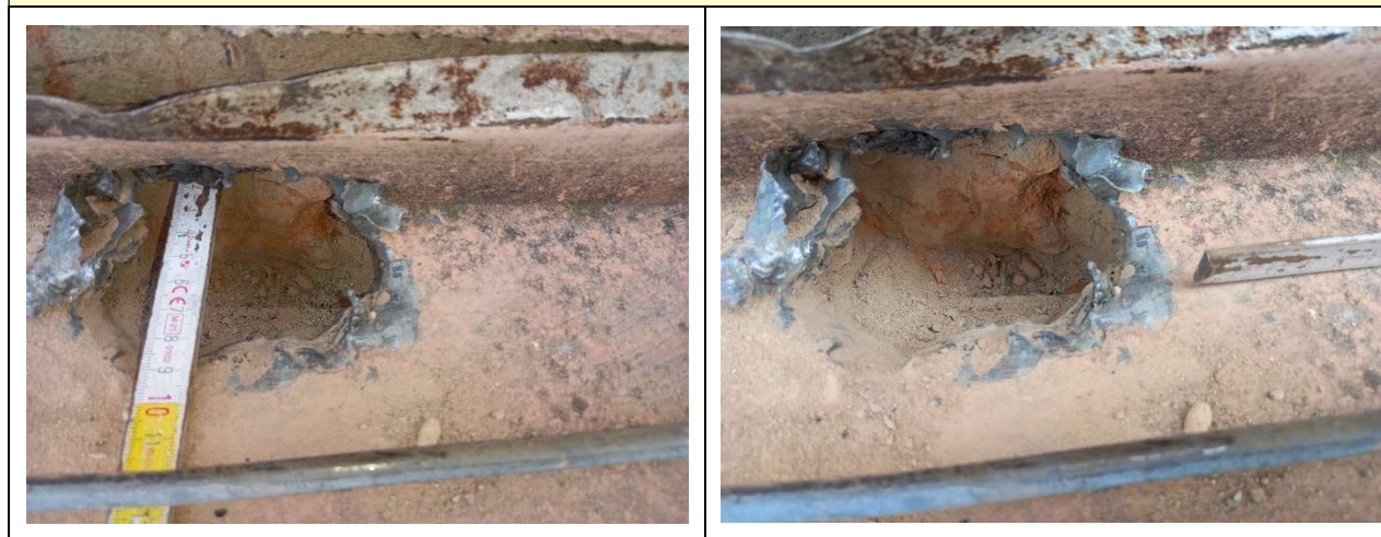
RIL-X-4 Scasso e rilievo del giunto - Piano copertura palestra
