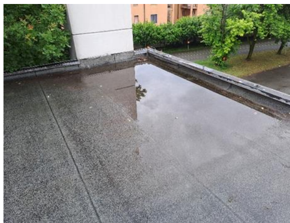
Infiltrazioni sul solaio di copertura della palestra e stato di conservazione della guaina estradossale
