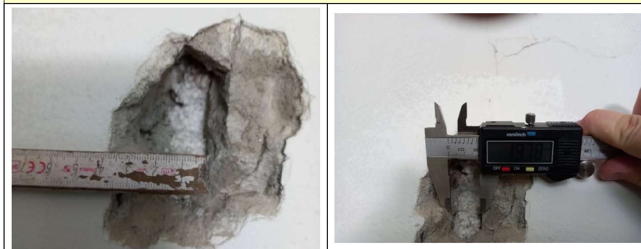
RIL-G-13 Scasso e rilievo del giunto - Piano Terra palestra
