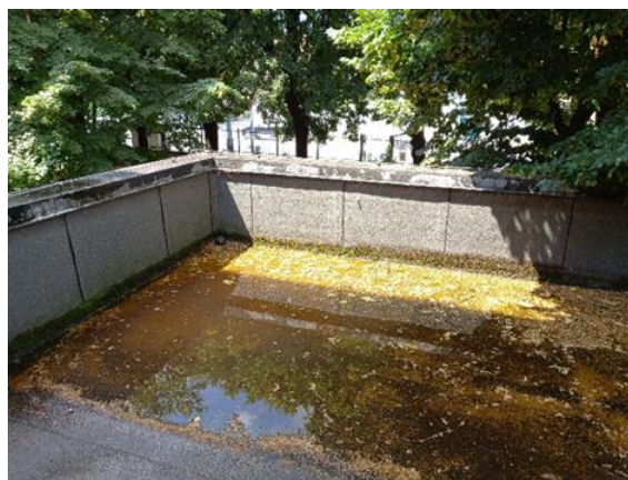
Infiltrazioni sul solaio di copertura dell'edificio storico e stato di conservazione della guaina estradossale
