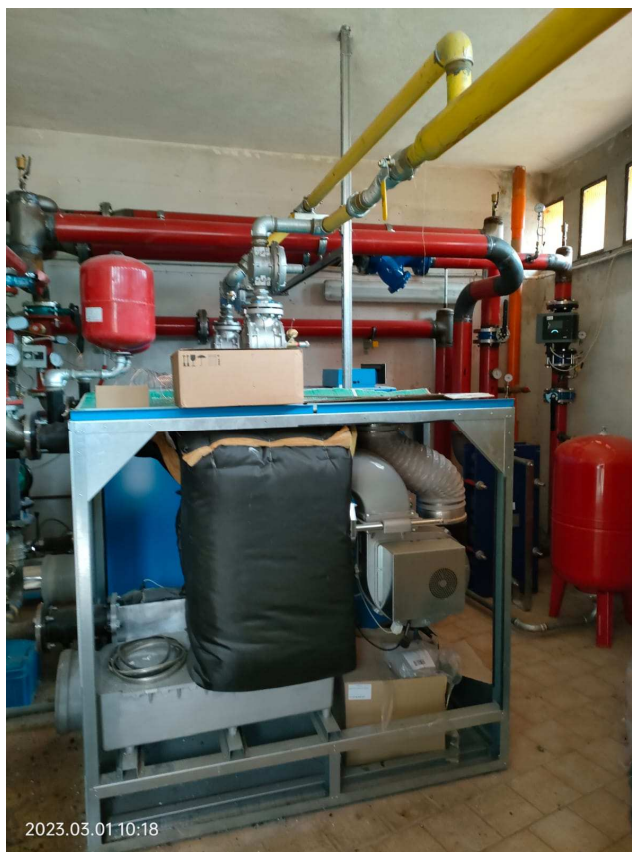
Figura 11 - Generatore 1 Potenza utile 367.4 kW
