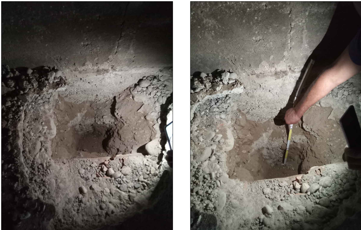
PUNTO 2FI: FONDAZIONE MURO PERIMETRALE IN CLS NON ARMATO
