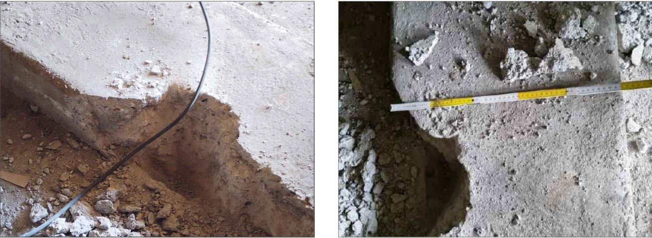
PUNTO 4FI: FONDAZIONE SETTI INTERMEDI 60 X20 ARMATA
