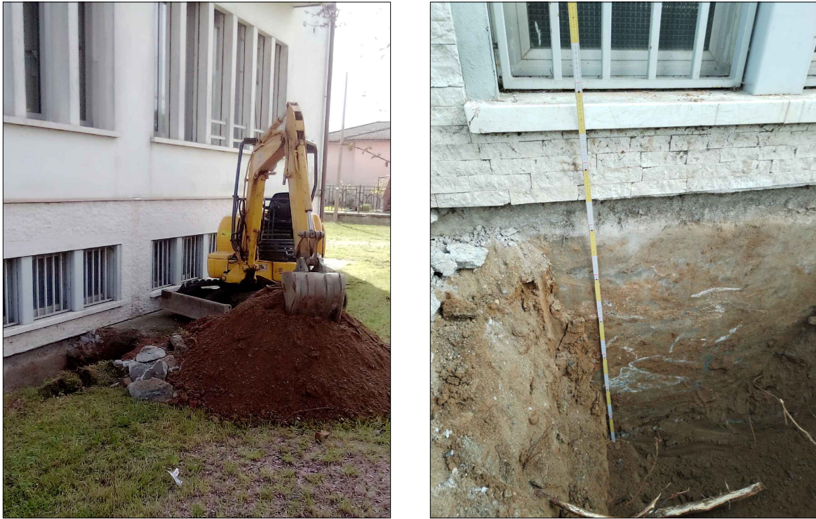
PUNTO 1FI: FONDAZIONE MURO PERIMETRALE IN CLS NON ARMATO
