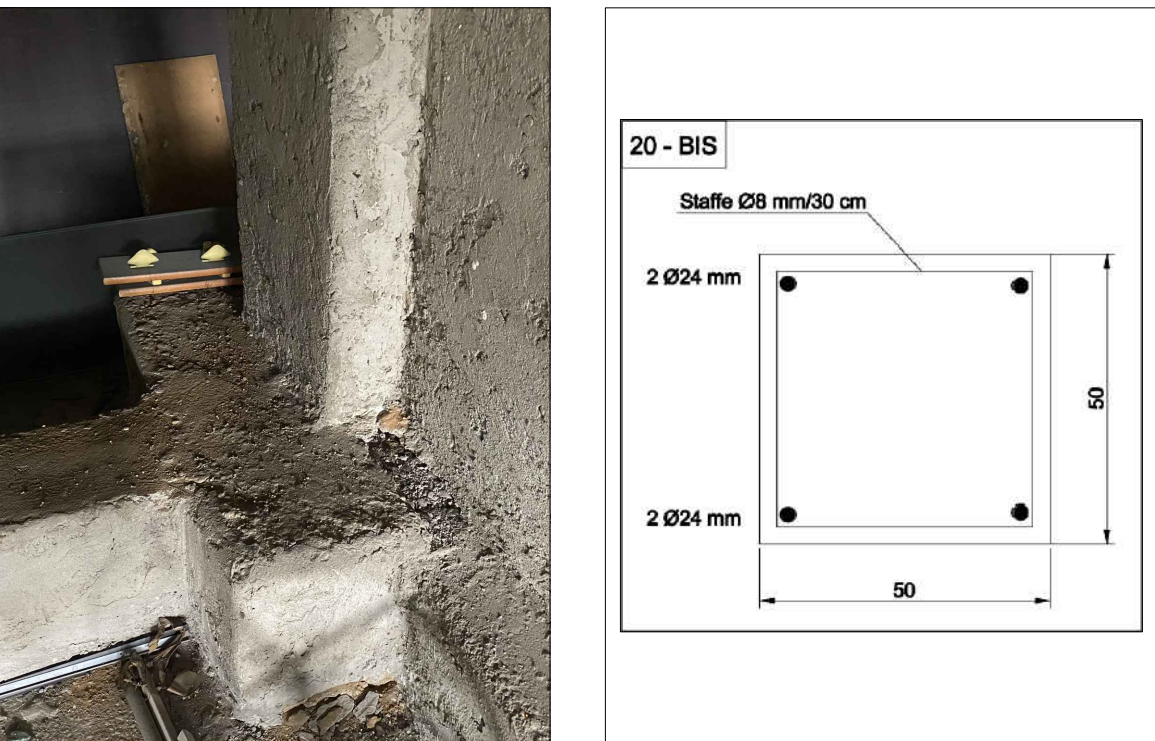
PUNTO 2P: PILASTRO ARMATO 45X30
