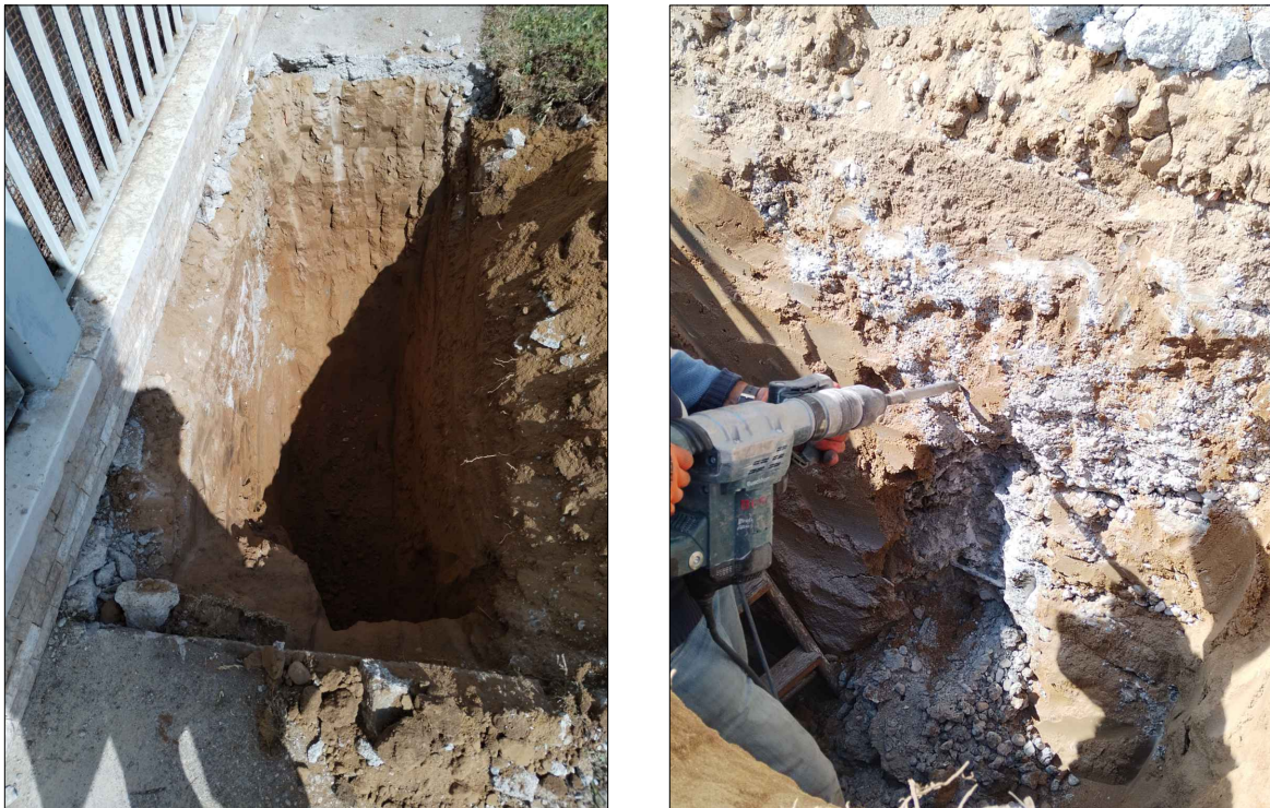
PUNTO 3F: FONDAZIONE CLS NON ARMATO LATO ESTERNO CONTROTERRA
