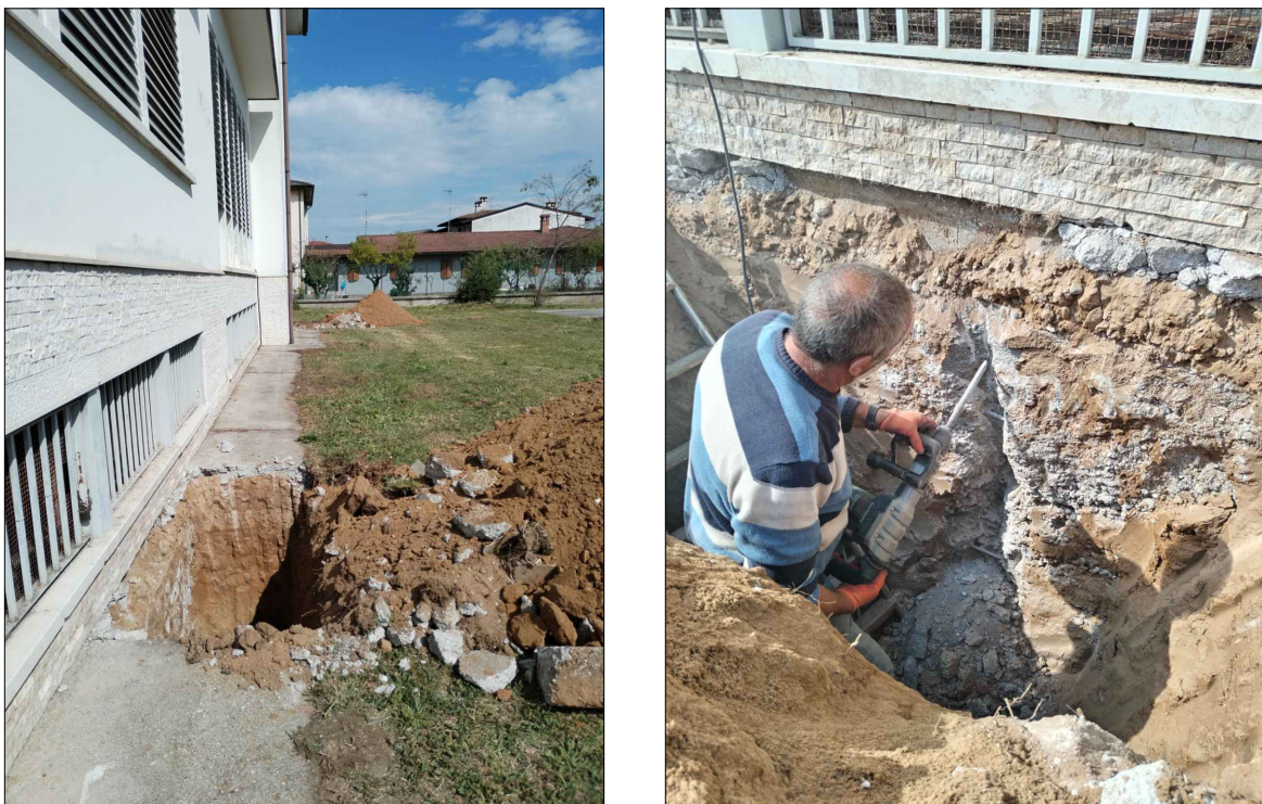
PUNTO 2F: FONDAZIONE CLS NON ARMATO LATO ESTERNO CONTROTERRA
