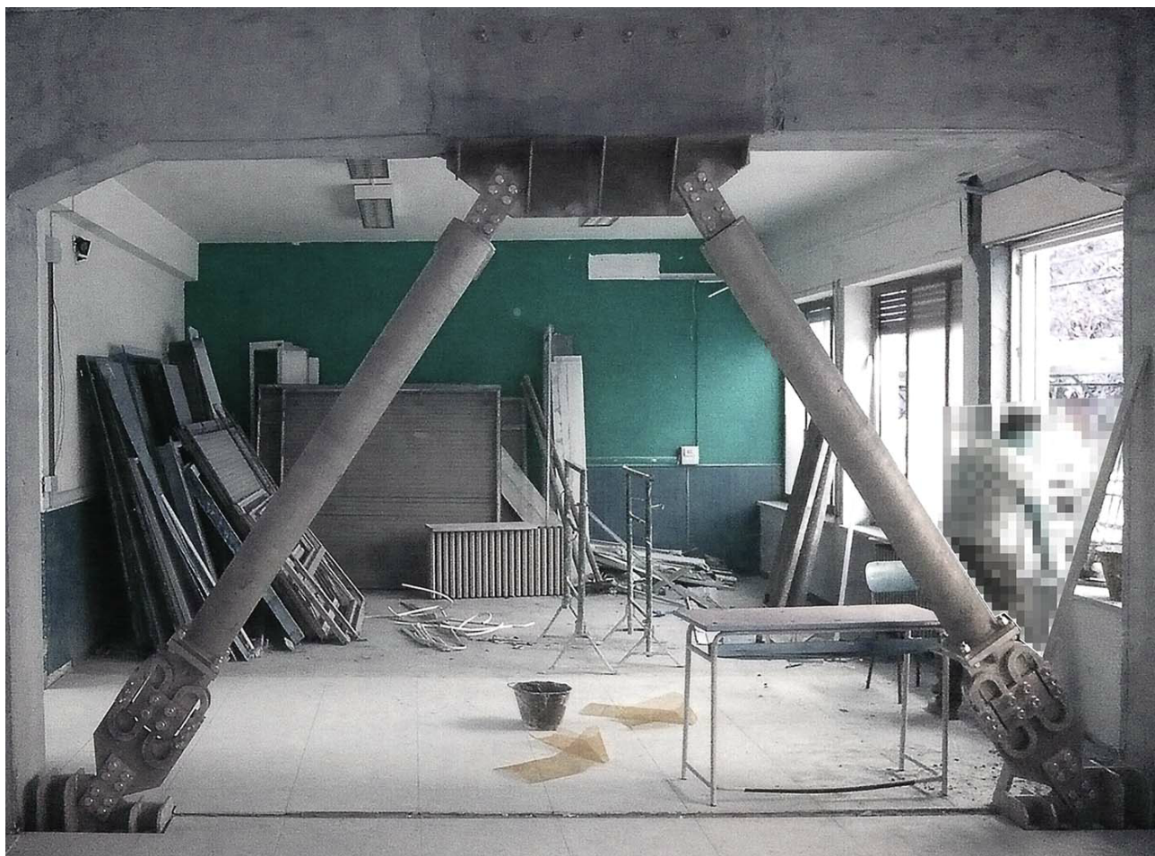
Installazione di controventi dissipativi
