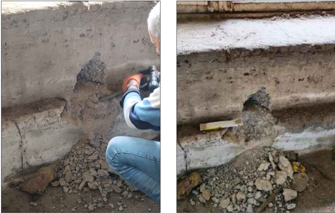
PUNTO 2FI: FONDAZIONE MURO PERIMETRALE IN CLS NON ARMATO
