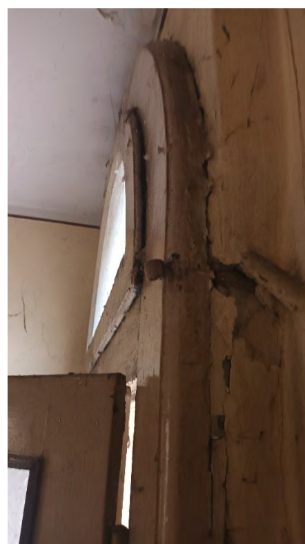
Figure 22: vista serramento porta ingresso dall'interno
