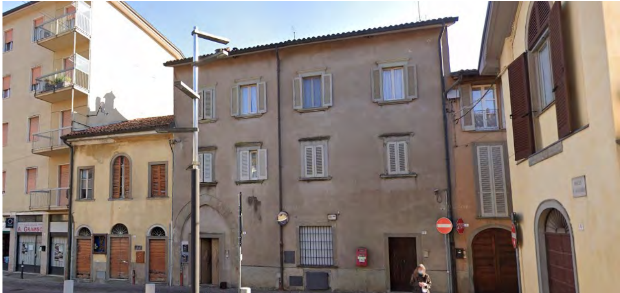
Figure 24: vista di insieme del fronte su P.zza IV Novembre, antecedente la posa dell'apprestamento di sicurezza
