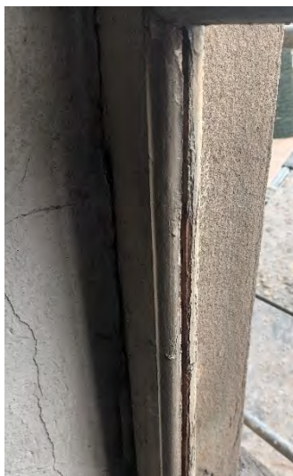
Figure 20: Serramento finestra destra fronte piazza, part. interno
