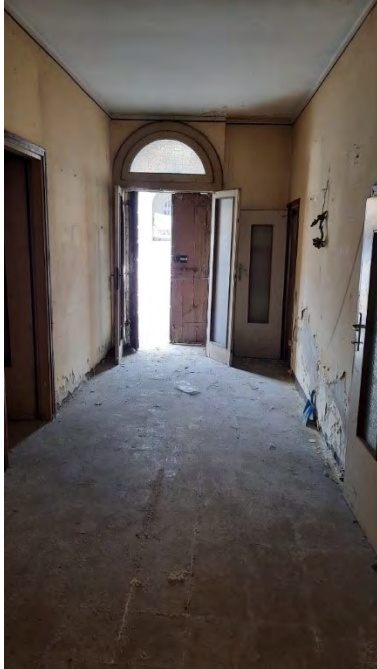
CORRIDOIO INGRESSO P.TERRA
