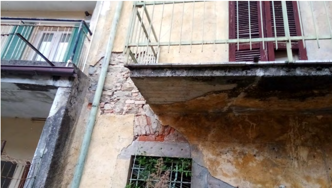
FRONTE CORTILE INTERNO
