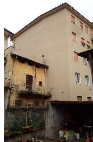
Figure 13: vista dal cortile confinante
