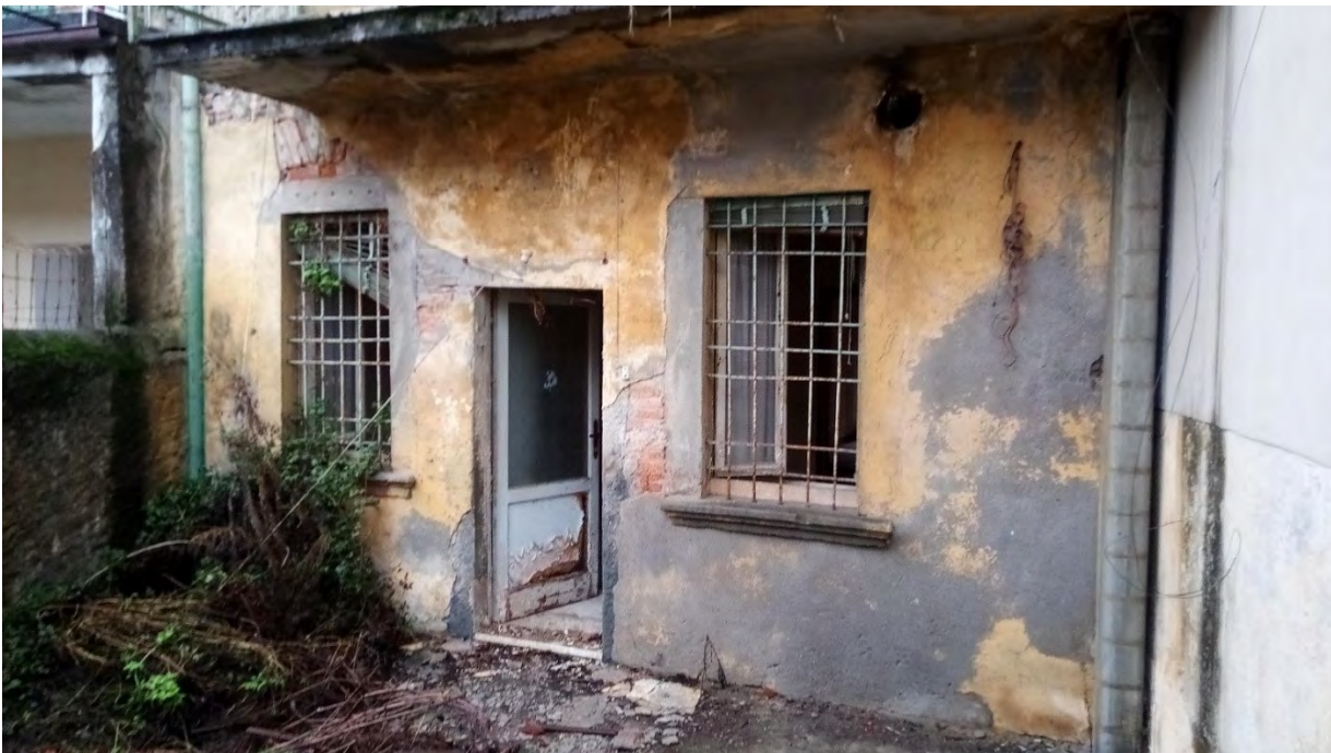
FRONTE CORTILE INTERNO
