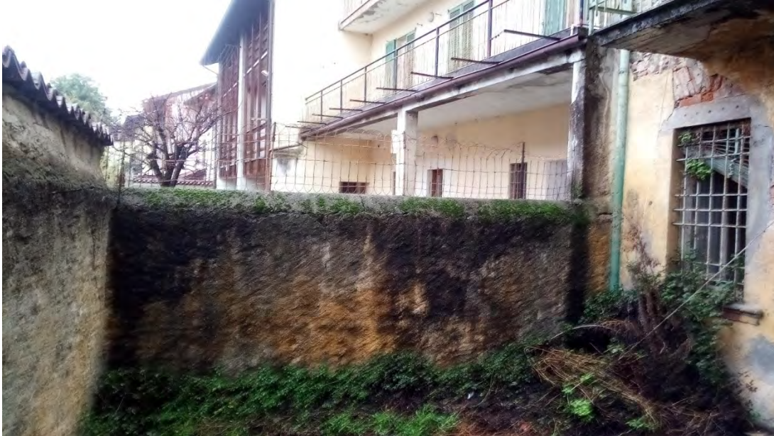
FRONTECORTILE INTERNO, PURATURA CORTILE
