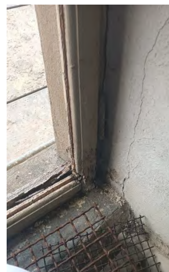
Figure 19: Serramento finestra destra fronte piazza part. interno
