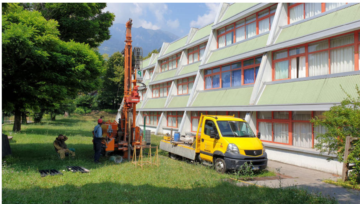
Foto 4: perforatrice per sondaggio a carotaggio
