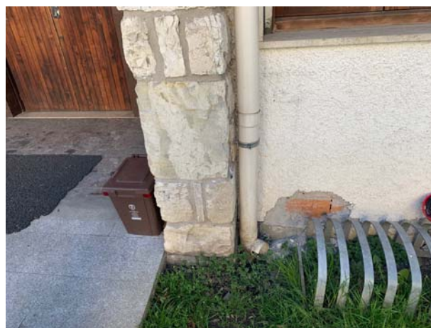
Foto sondaggio 12: MURATURA IN SCATOLE
