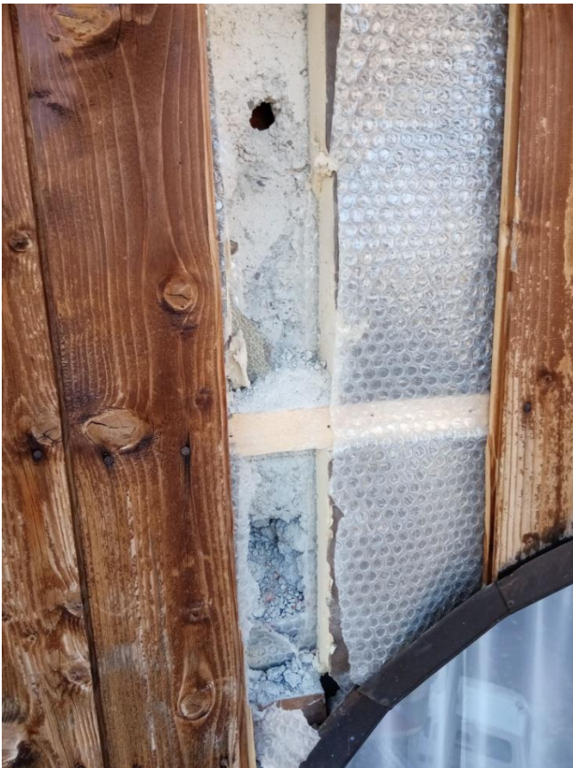
Particolari del rivestimento e dell'isolamento della facciata
