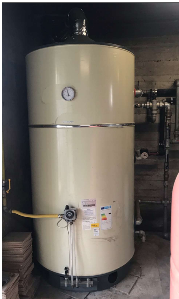
Figura4: Bollitore a gas
