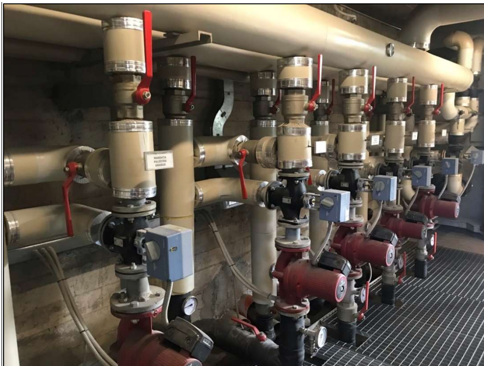
Foto 2: Collettore pompe tradizionali con valvole miscelatrici
