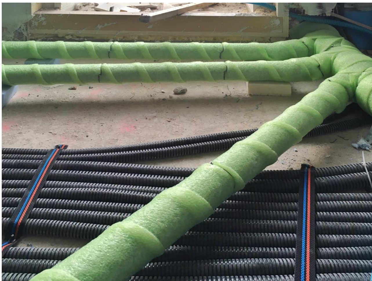
Fasciatura di tubi di scarico (tutti, compreso scarichi da lavandini, docce, vasche, WC etc.) con materassino elastomerico. Laddove necessario il materassino oltre a caratteristiche di elasticità dovrà possedere caratteristiche di fono-isolamento (vedasi anche il capitolo degli impianti)
