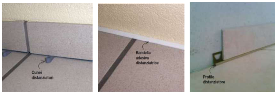
Esempio di sigillatura elastica dell'interstizio di disaccoppiamento.
