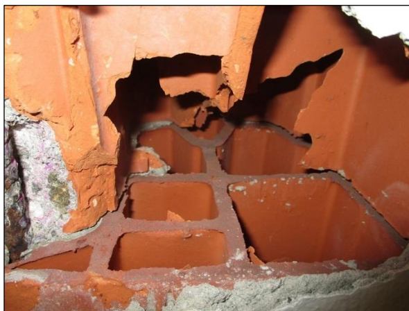
Foto n°16 - Particolare in cui è osservabile la geometria del laterizio che realizza il sistema di alleggerimento.
