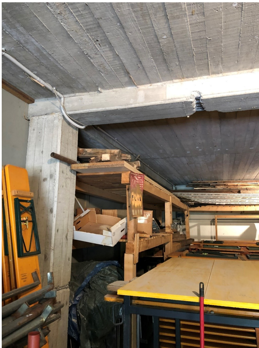
Figura 12 – Sondaggio tipo A – Trave T 1-3
