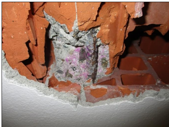
Foto n°17 - Particolare del travetto gettato direttamente in opera.
