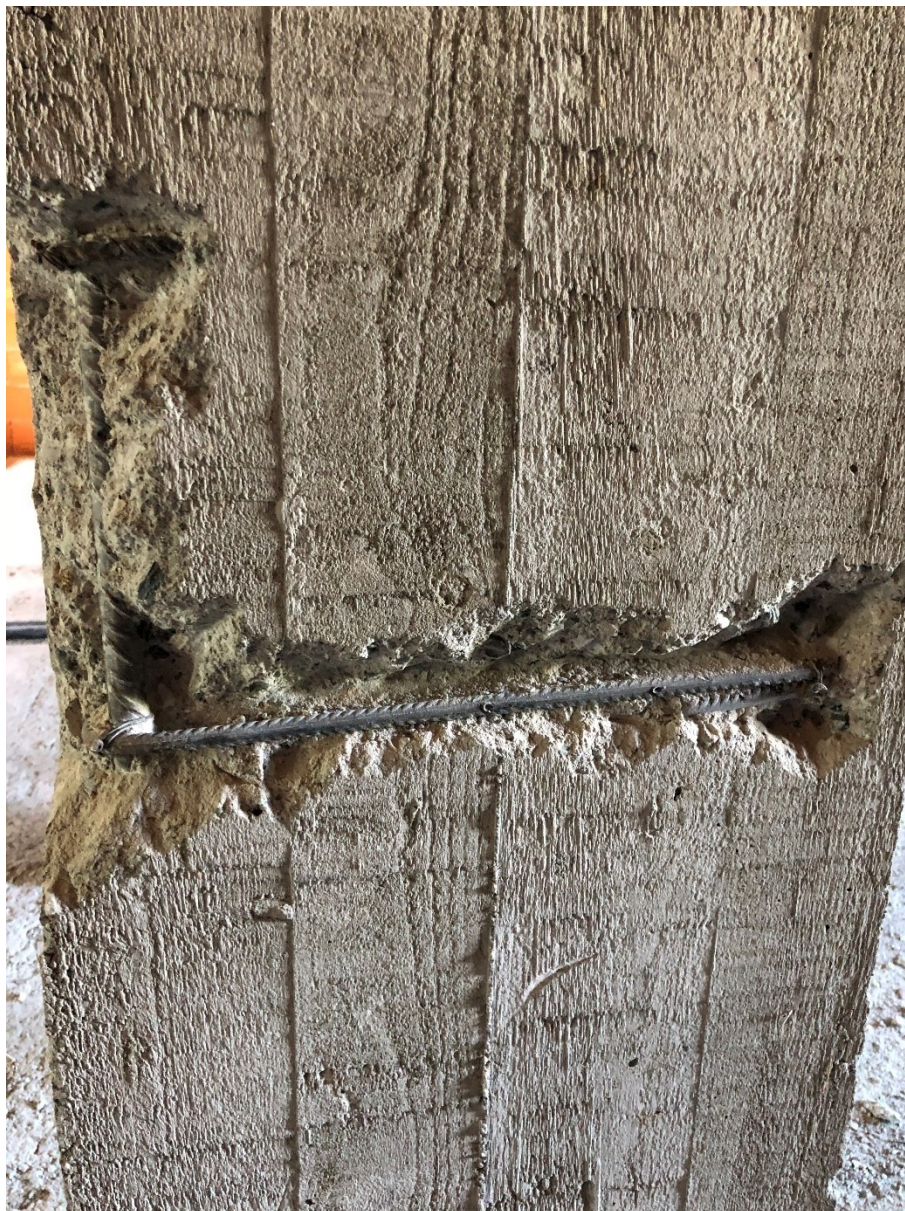
Figura 15 – Armatura pilastro P 2
