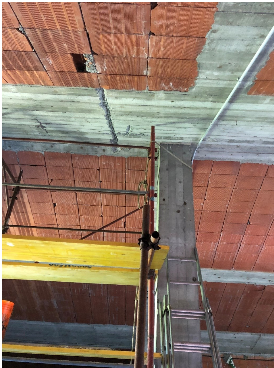
Figura 16 – Sondaggio tipo C – Trave di colmo
