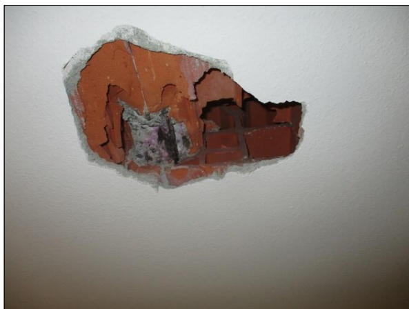
Foto n°15 - Individuazione della Tipologia Solaio A; demolizione puntuale eseguita nel Bagno al piano terra.
