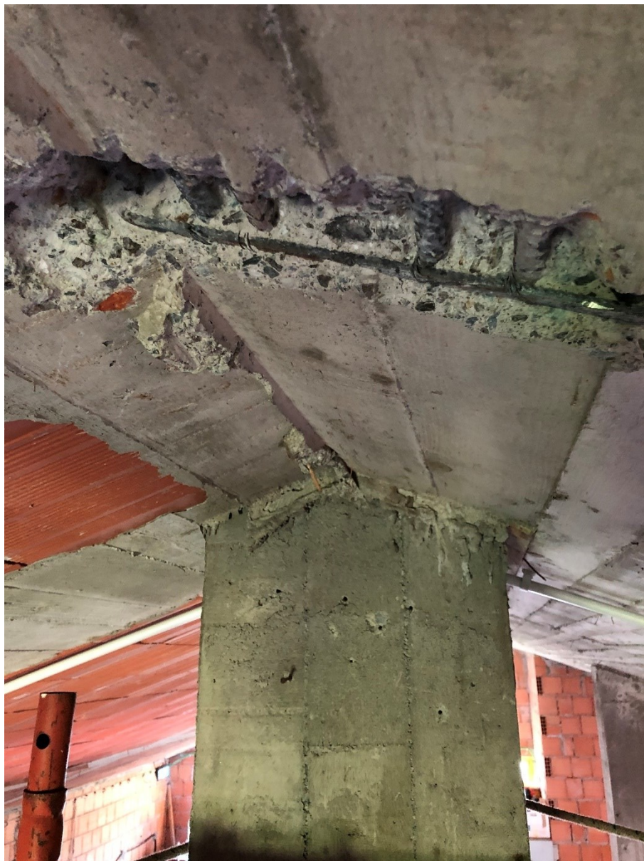
Figura 17 – Armatura trave di colmo
