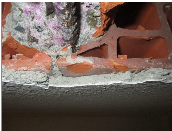
Foto n°18 - Dettaglio dello spessore dello strato di finitura del plafone.
