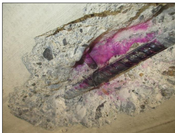
Foto n°14 - Particolare dell'armatura del solaio in C.A.
