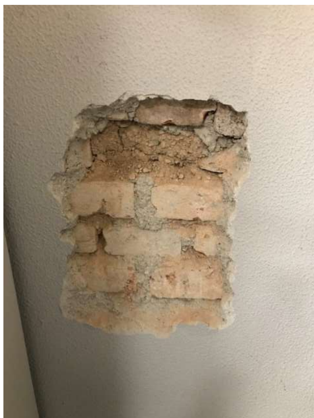
Figura 17: saggio 16 - M10 - muro perimetrale PP
