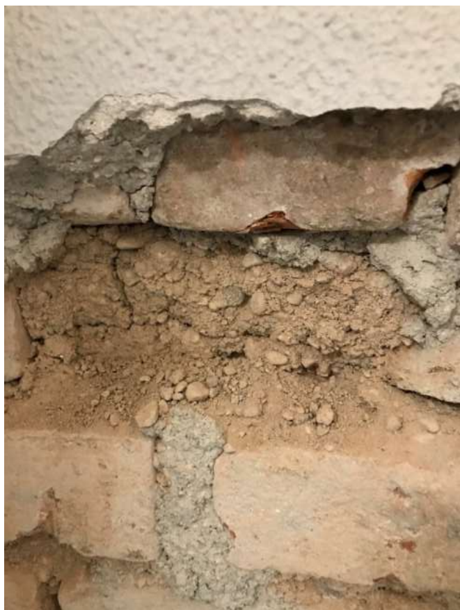
Figura 18: saggio 16 - M10 - muro perimetrale PP - dettaglio malta
