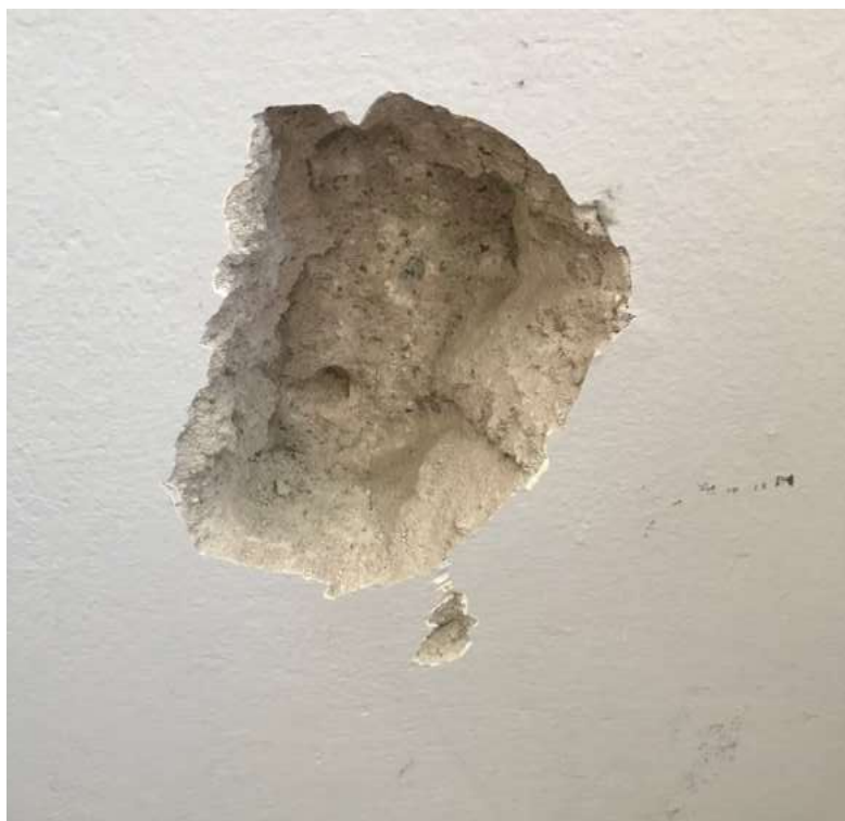
Figura 3: saggio 3 - M3 zona bassa - muro PT
