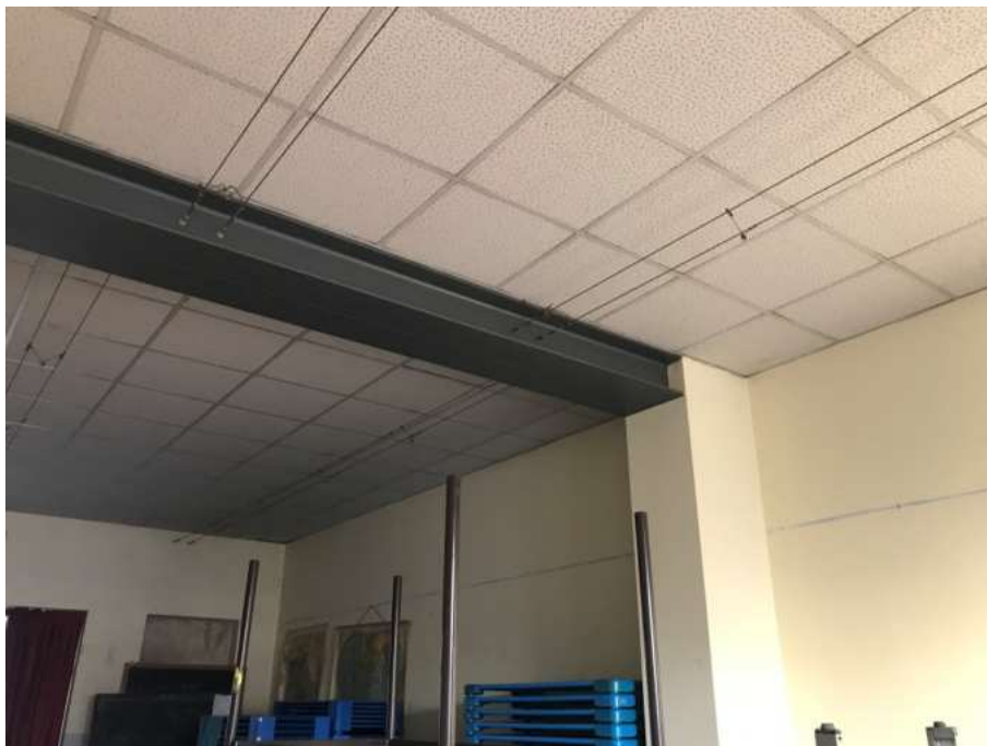
Figura 15 travi interne in acciaio solaio piano rialzato - profili affiancati HEB220
