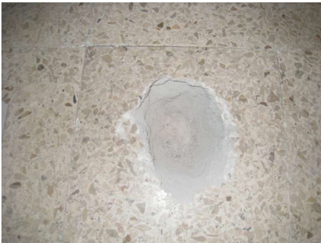
Figura 30: saggio 22 - S4 - pavimento PP
