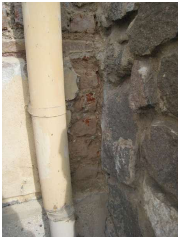
Figura 11: saggio 8 – M11- lato esterno - incrocio muro perimetrale con muro confinante edificio esistente
