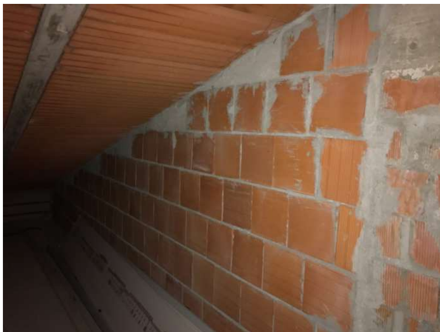
Figura 17 Dettaglio attacco rialzo perimetrale sottotetto – copertura
