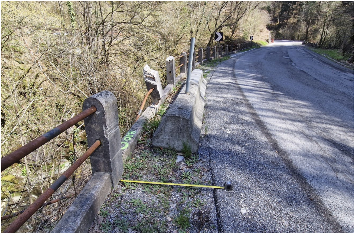
Parapetto incidentato pk 32+210
