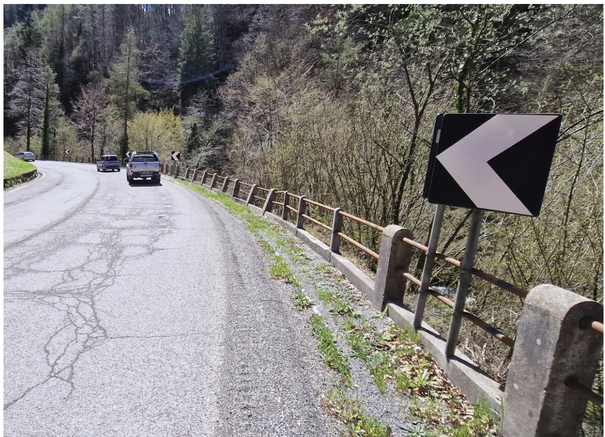
Parapetto incidentato pk 32+190
