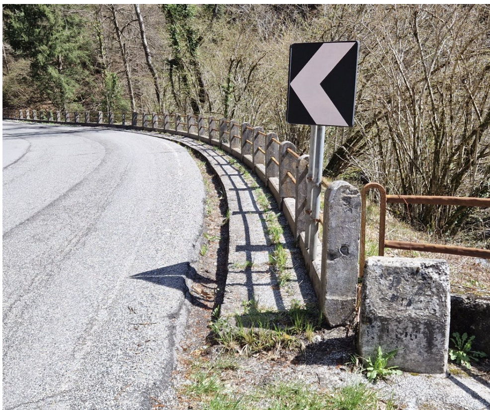
Tratto con parapetto su rilevato
