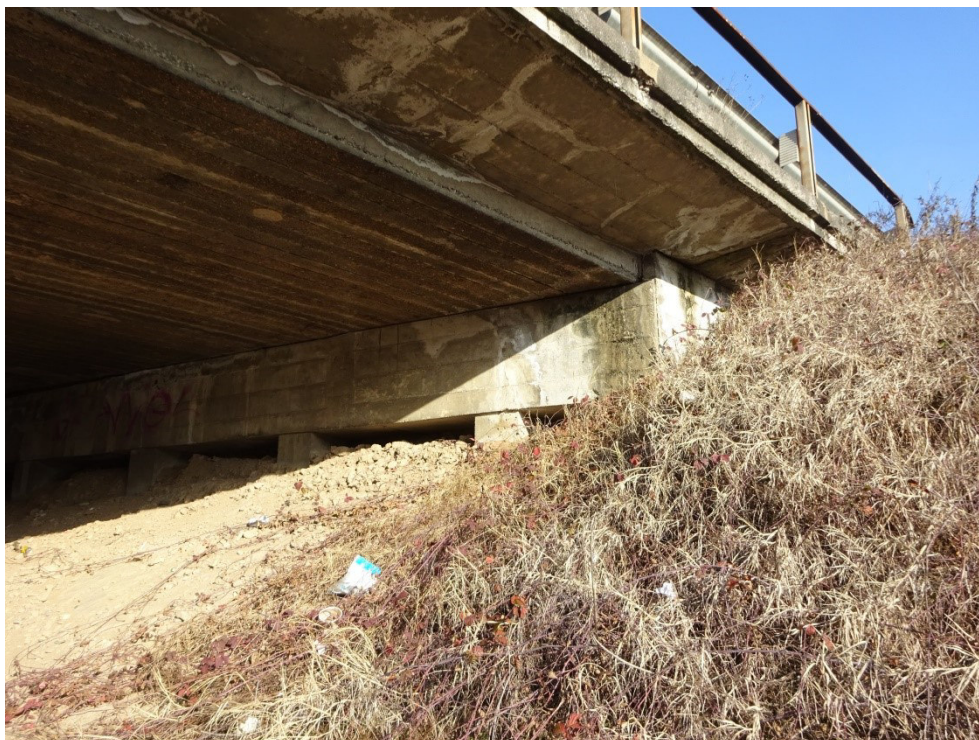
Foto 16 - Pulvino spalla lato est
