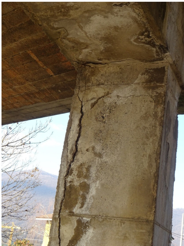
Foto 23 - Ammaloramento pilastro pila lato est
