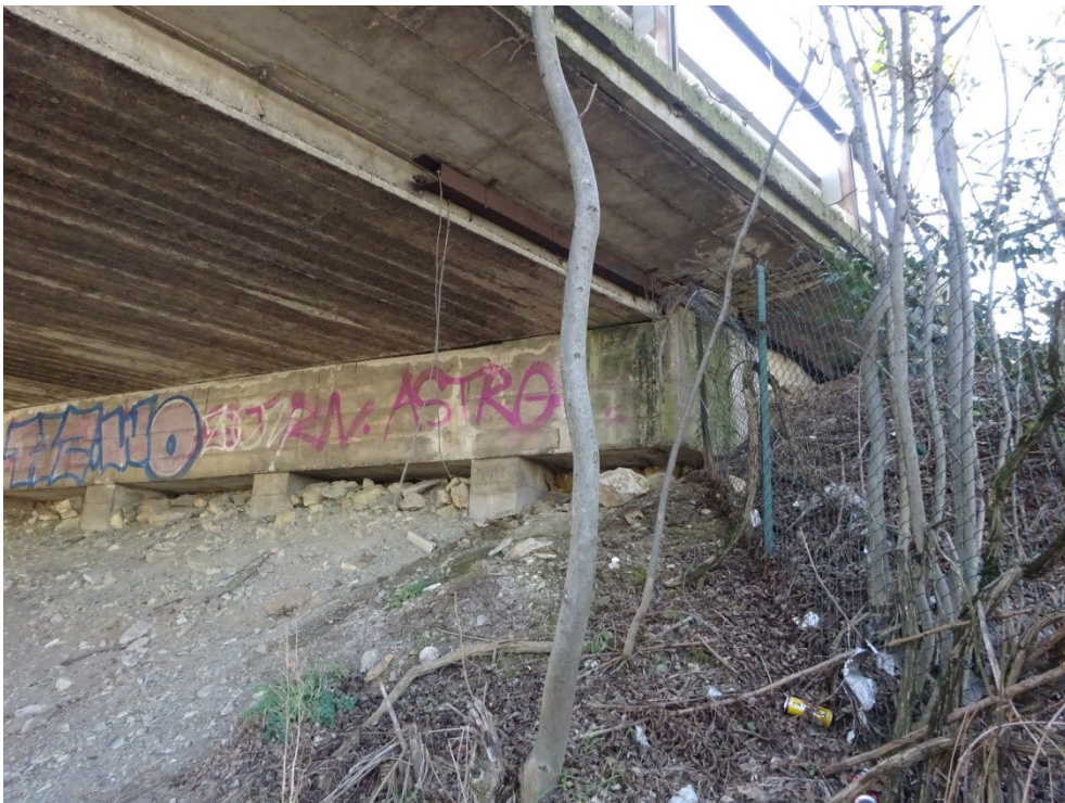
Foto 21 - Pulvino spalla lato ovest
