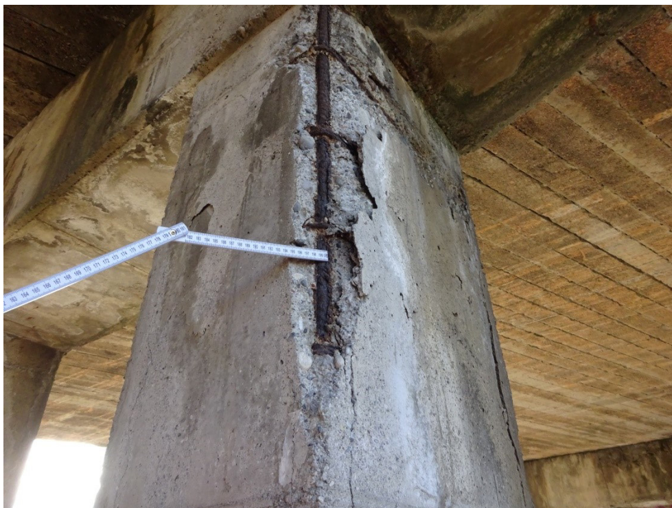
Foto 19 - Ammaloramento pilastri pila lato est
