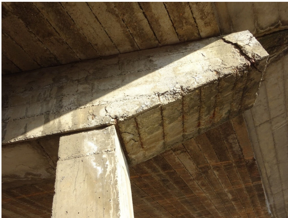
Foto 24 - Ammaloramento pulsino pila lato est
