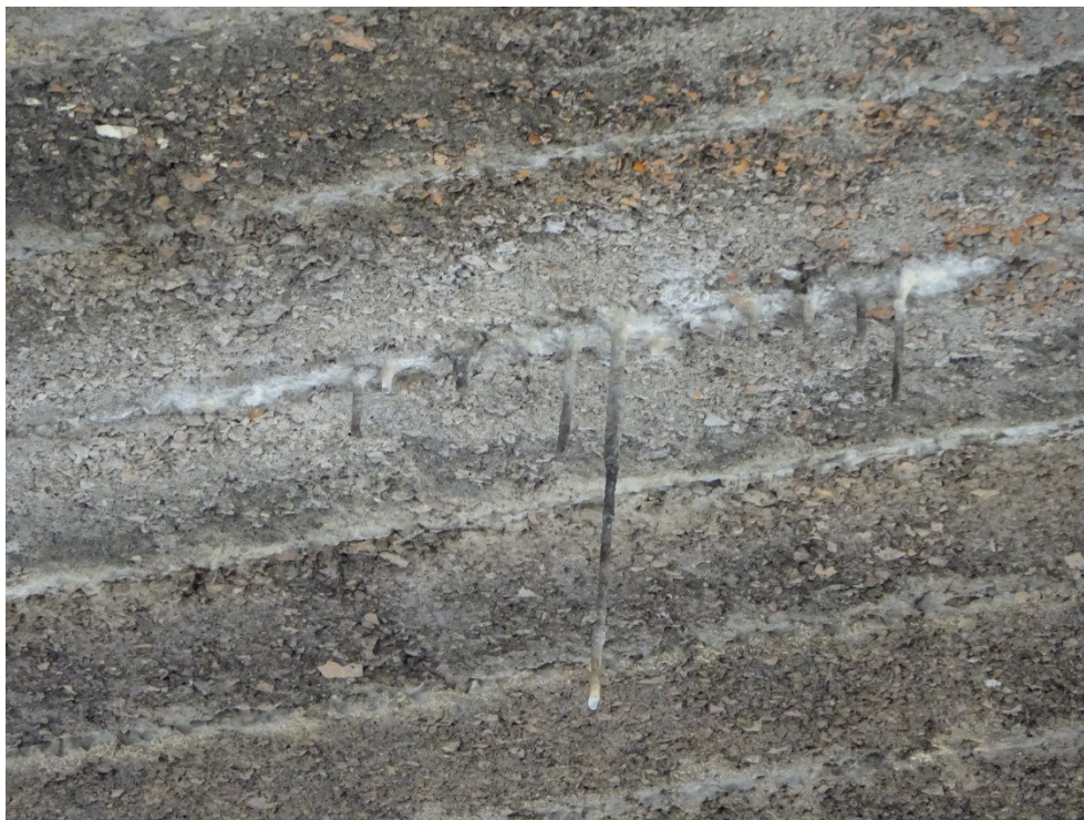
Foto 15 - Percolazioni e infiltrazioni dall'impalcato
