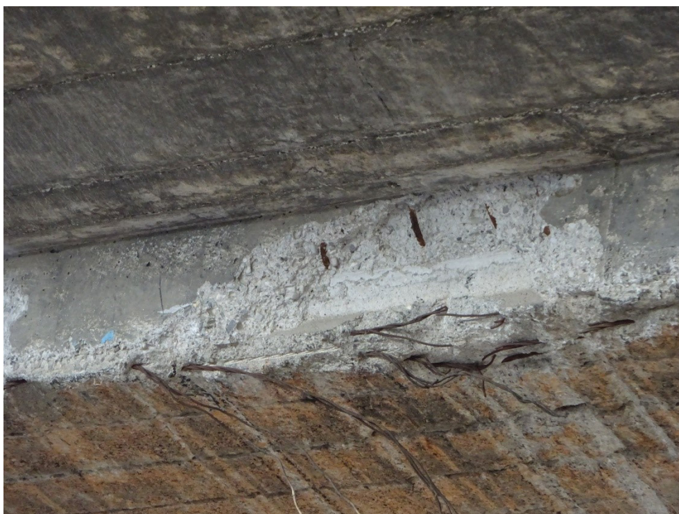
Foto 14 - Particolare danneggiamento soletta
