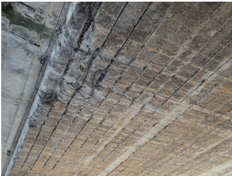
Foto 13 - Danneggiamento soletta campata centrale - lato nord
