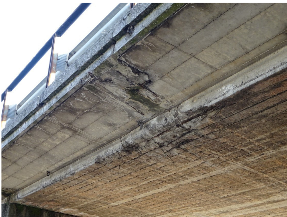
Foto 12 - Danneggiamento soletta campata centrale, lato nord
