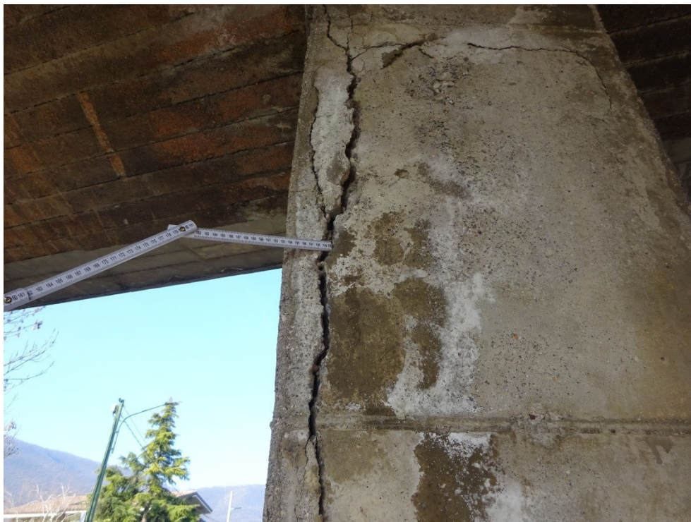
Foto 18 - Ammaloramento pilastri pila lato est
