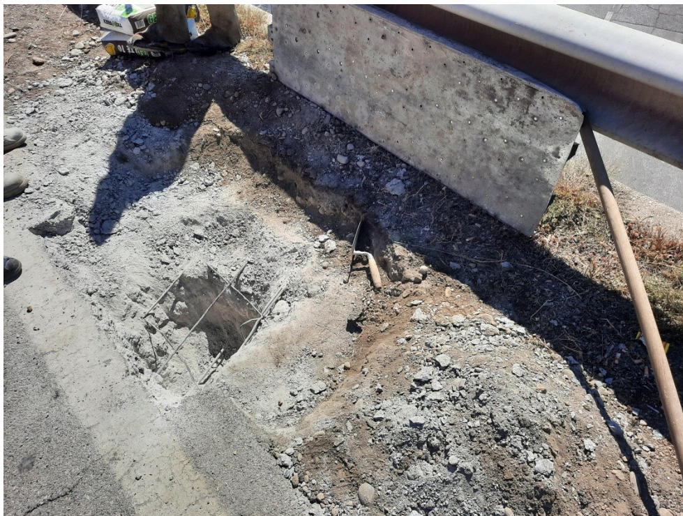
Foto 26 – Sondaggio sulla soletta
