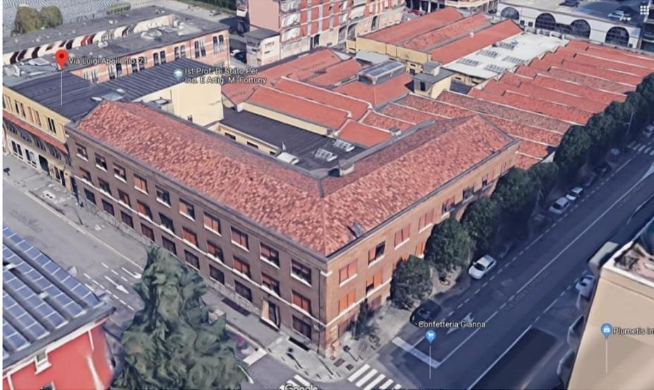
È il corpo più alto, costituito da un piano interrato e tre piani fuori terra. La tecnologia costruttiva è mista con telaio centrale a travi/pilastri c.a. e murature portanti perimetrali in laterizio pieno e talvolta semipieno. I solai sono in laterocemento e la copertura presenta un piano di sottotetto (non praticabile).
