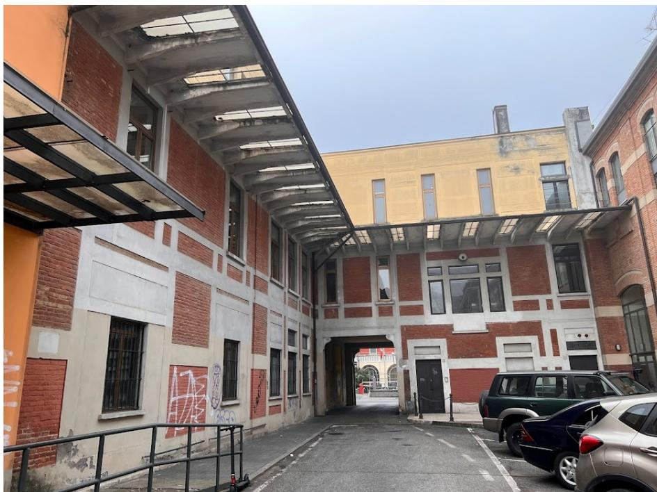
La struttura principale in travature è alternata con vetri, che si presentano rotti o mancanti.
