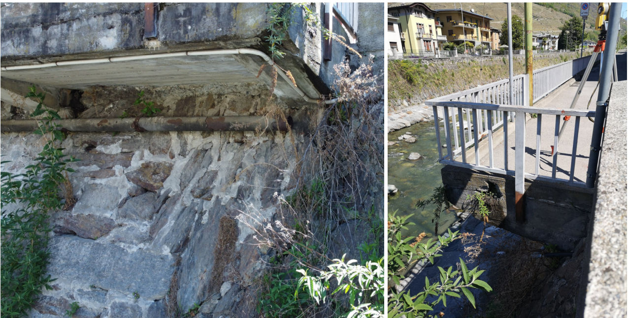
Figura 4 - 5: Particolari partenza della mensola sospesa sul fiume Adda
