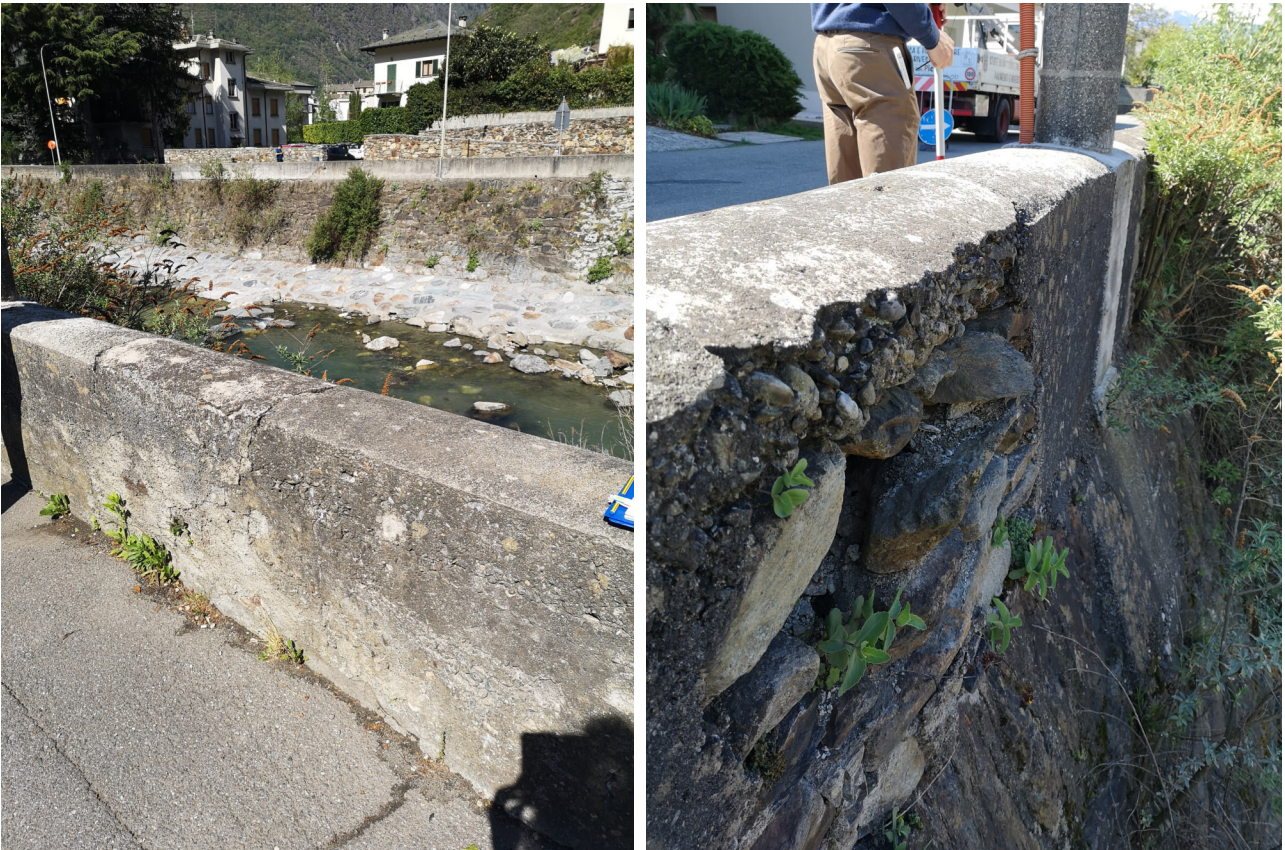
Figura 10 - 11: Particolari parapetti murati in parte in cls ed in parte in pietra da sopralzare
