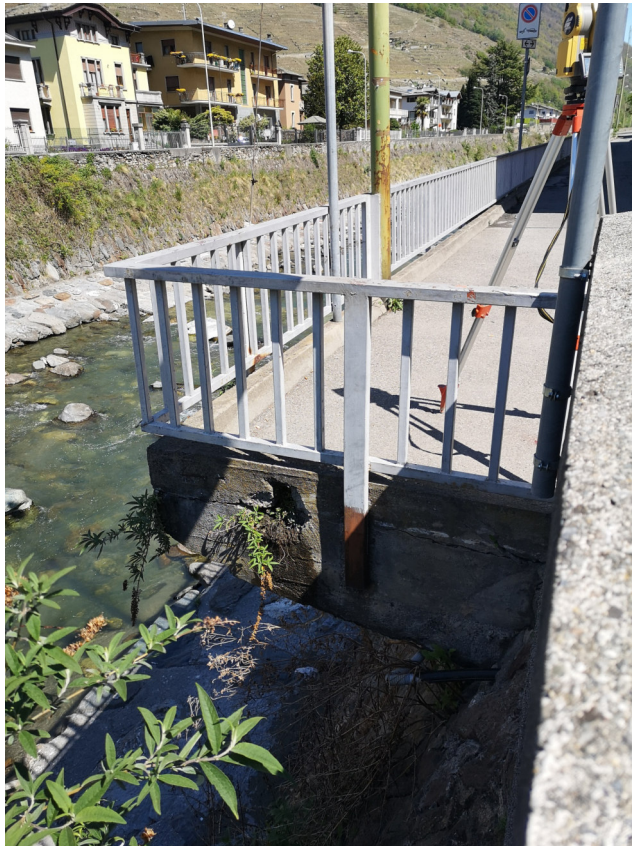
Figura 13: Vista della mensola esistente in c.a. da mantenere su cui agganciare nuovi parapetti in doppia lastra
