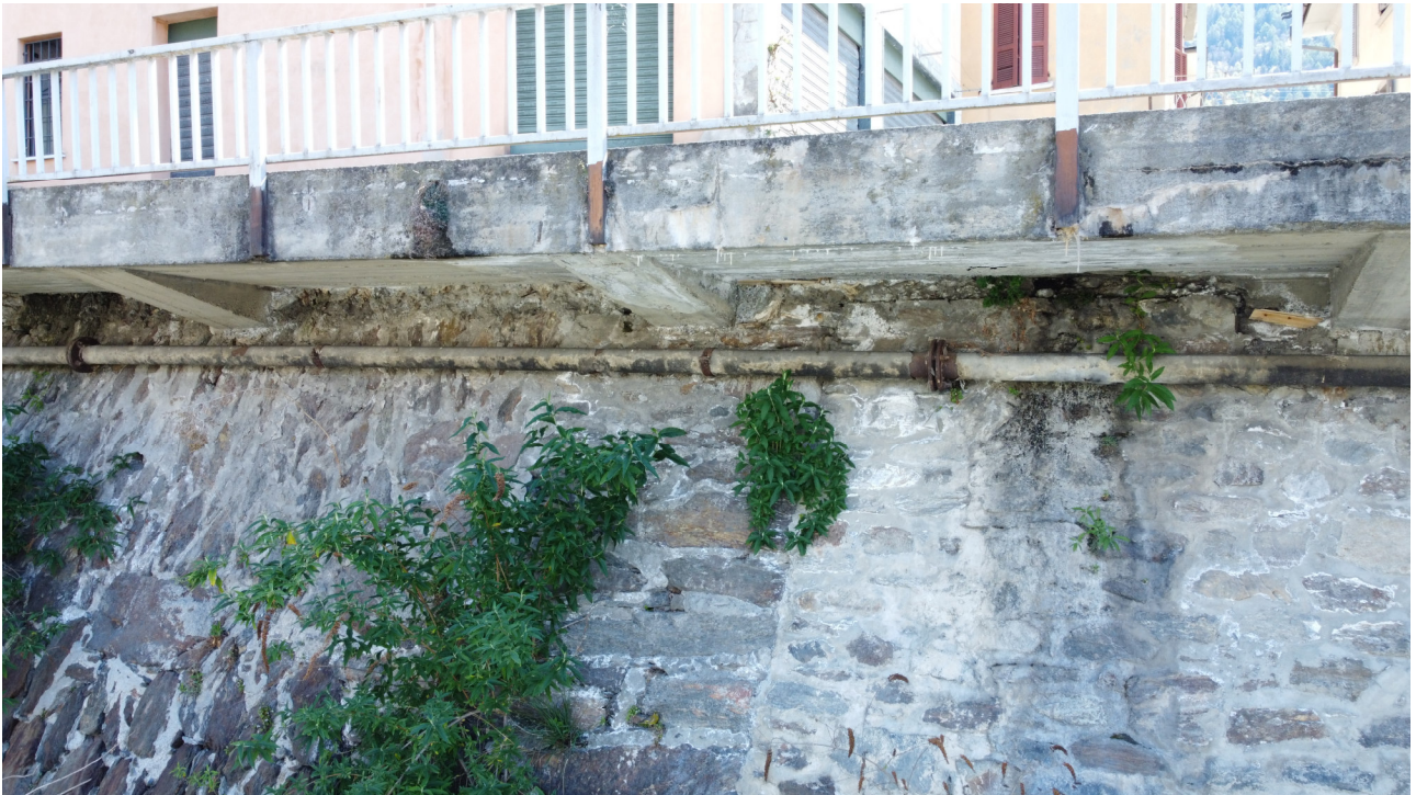
Figura 6: Particolare contrafforti inferiori della mensola sospesa sul fiume Adda
