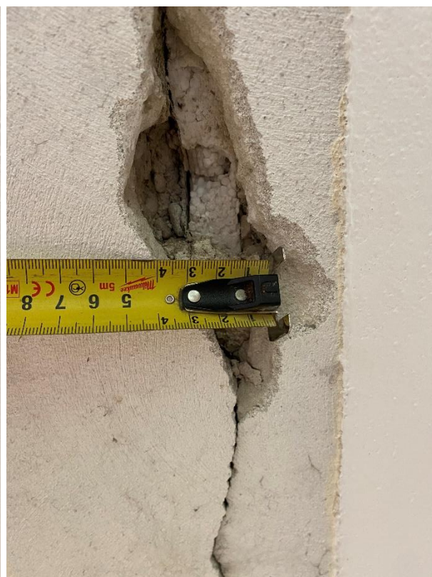
Distacco tra le strutture a livello impalcato
