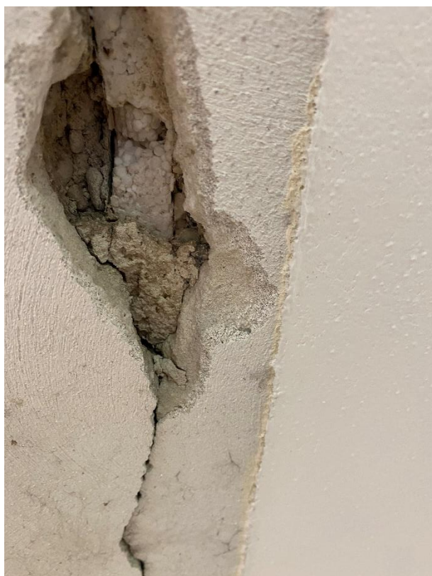
Distacco tra le strutture a livello impalcato
