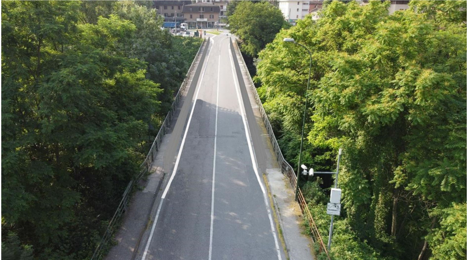
Vista estradosso ponte con nuovi guardrail
