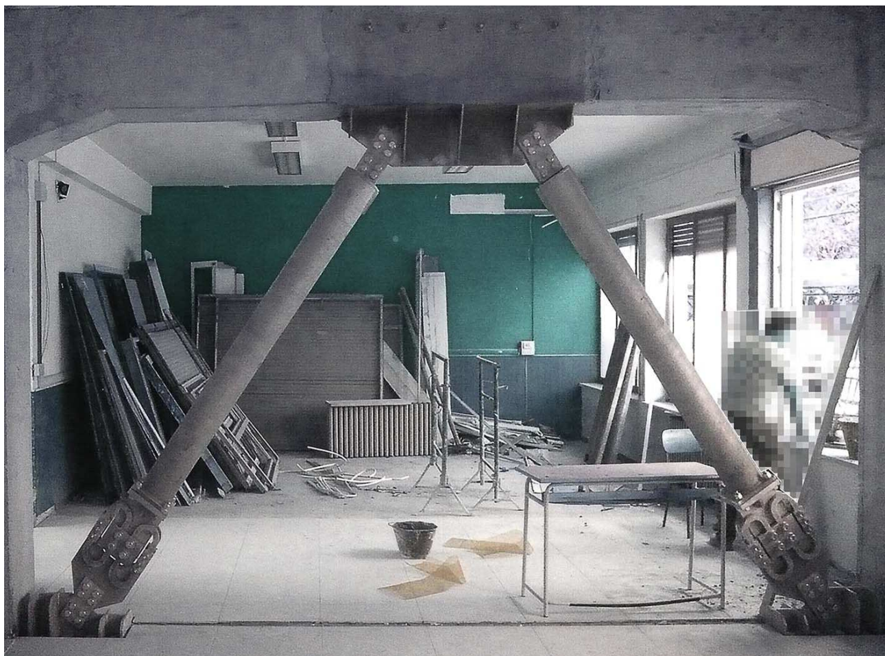
Installazione di controventi dissipativi
