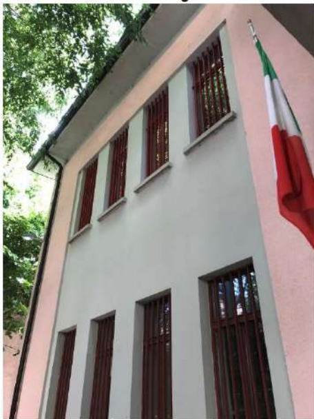
Serramenti blocco bagni Piano Primo e Secondo
