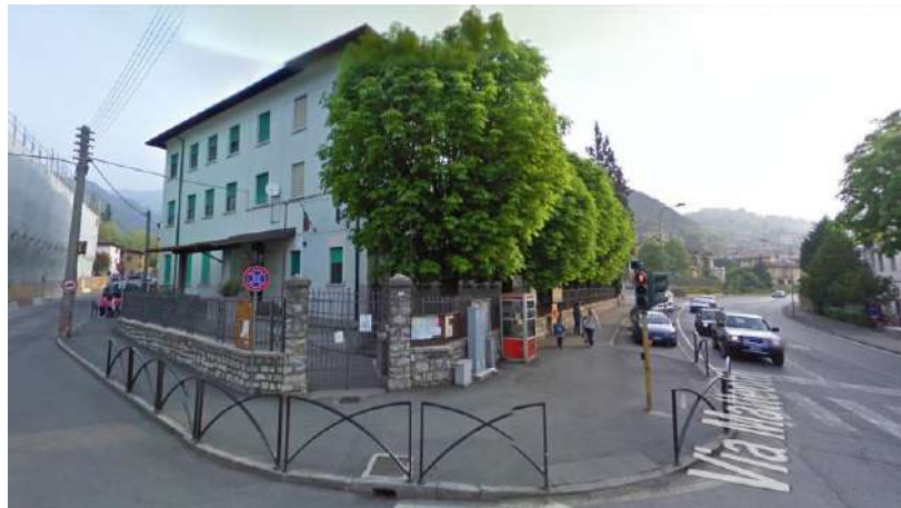
Vista dalla strada di accesso
