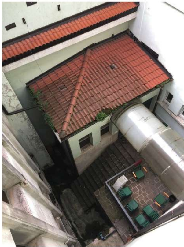
Vista cortile interno
