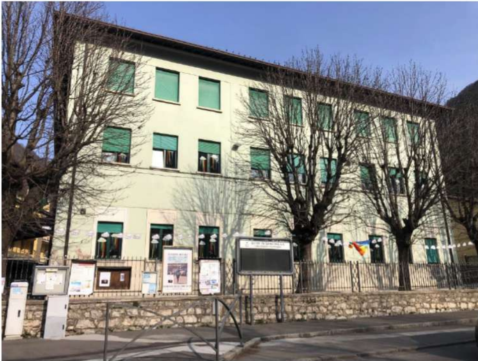
Prospetto sud – ovest da via Alessandro Volta
