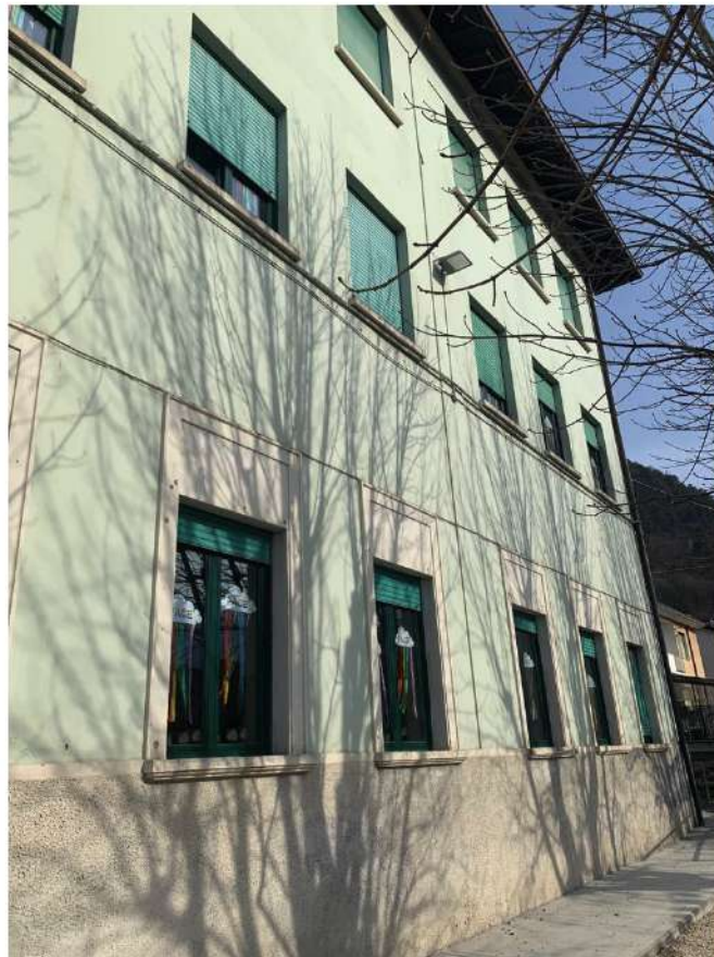
Prospetto sud – ovest da via Alessandro Volta
