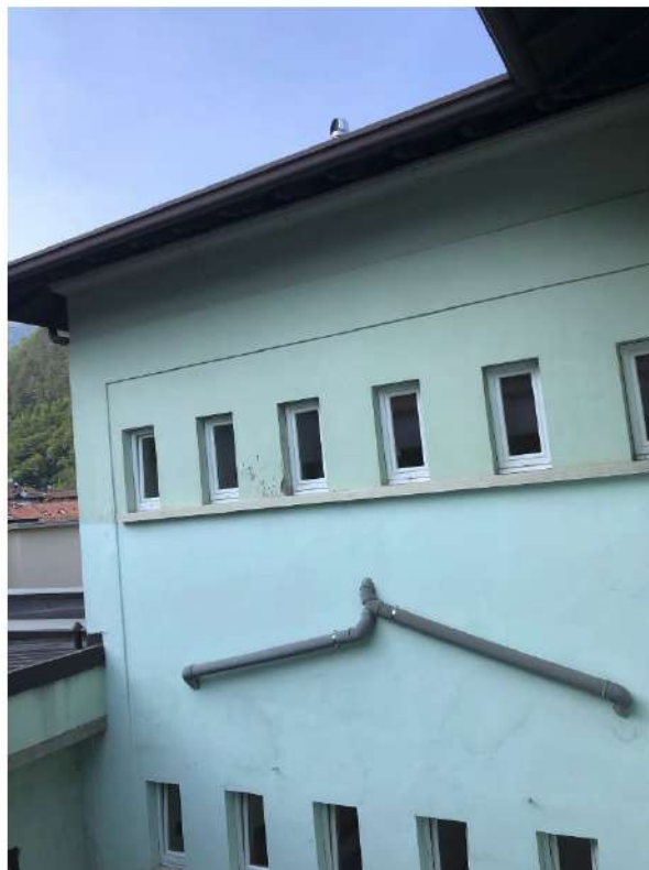
Facciata Est cortile interno
