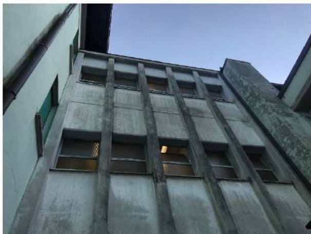
Serramenti blocco bagni Piano Primo e Secondo
