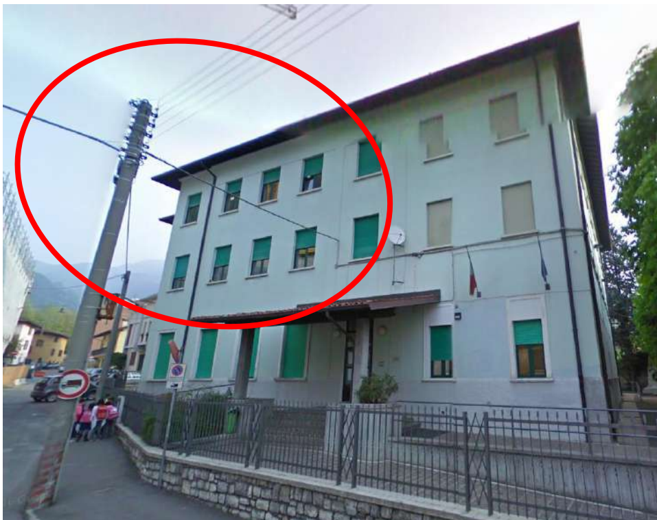
Interferenza linee elettriche in facciata con area di cantiere
