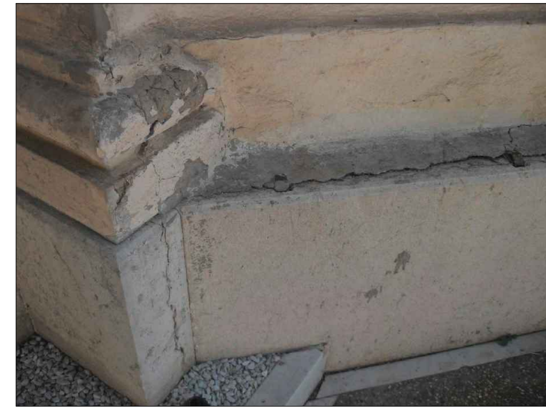
Intervento monumentale "G" Particolare deterioramento cappella
