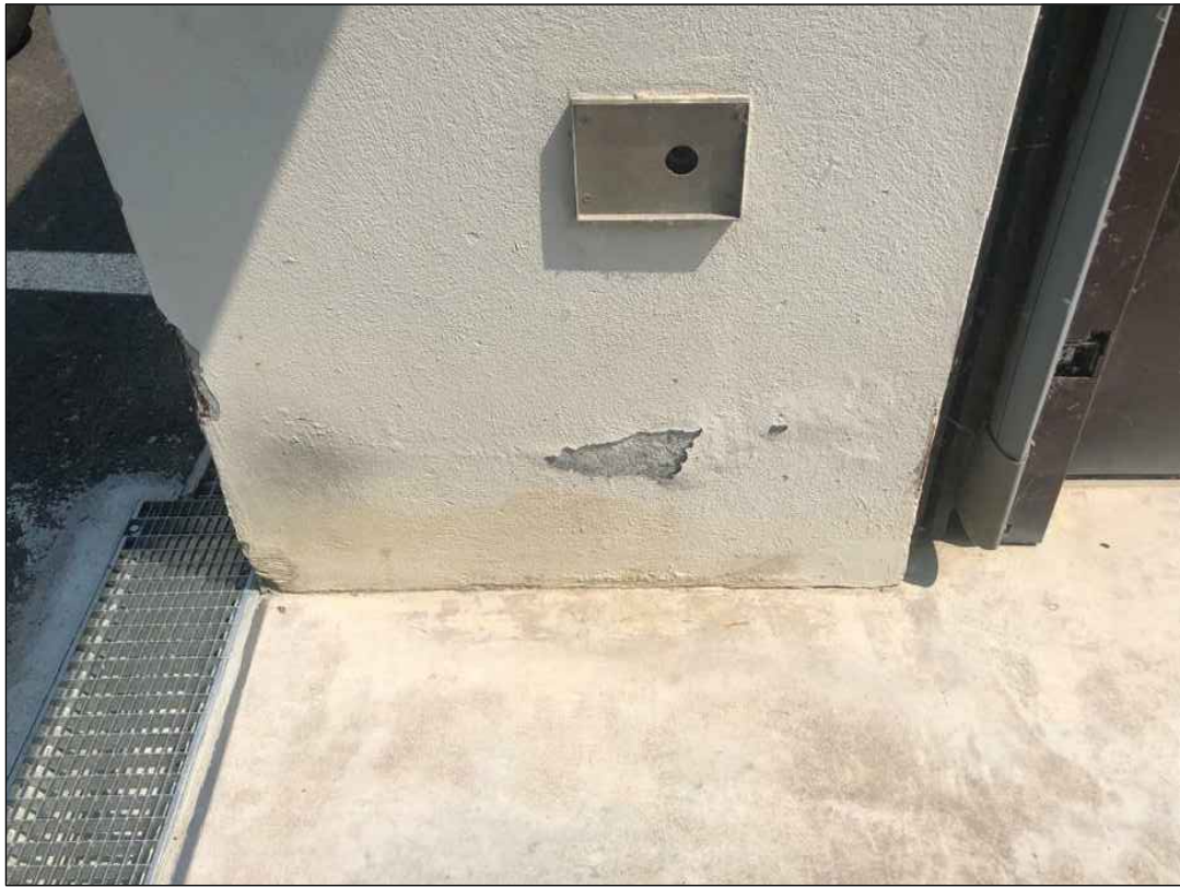
Particolare intonaco ammalorato muraure d'accesso principale
