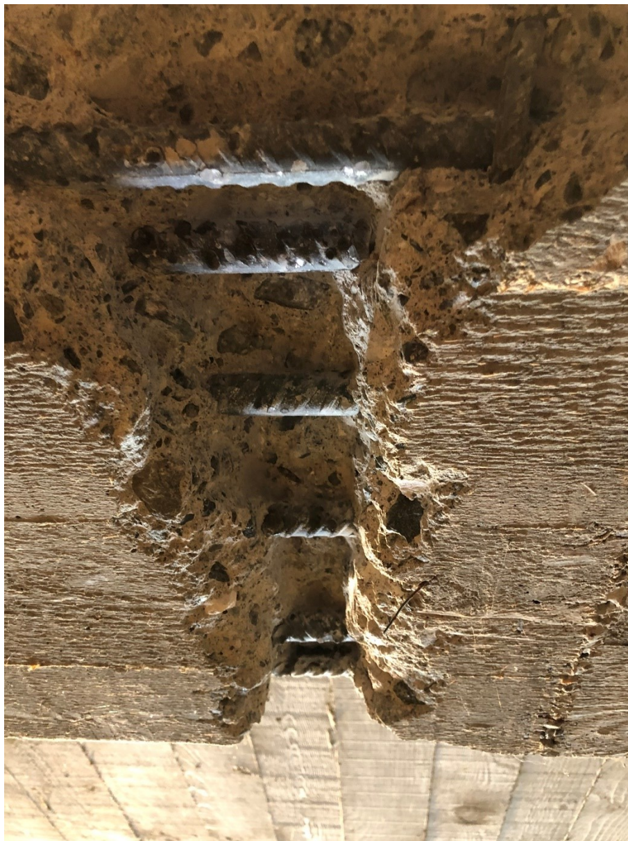
Figura 5 – Armatura trave T 1-3
