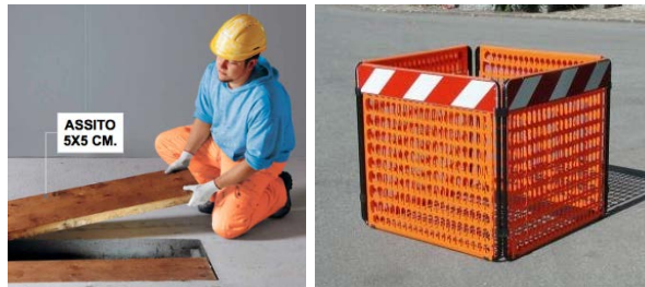
Si visualizzano i principali sistemi di protezione delle aperture nelle pavimentazioni e/o pozzetti
