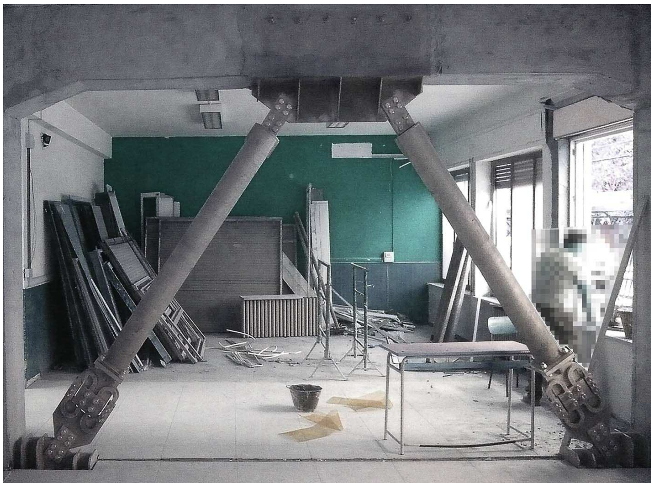
Installazione di controventi dissipativi
