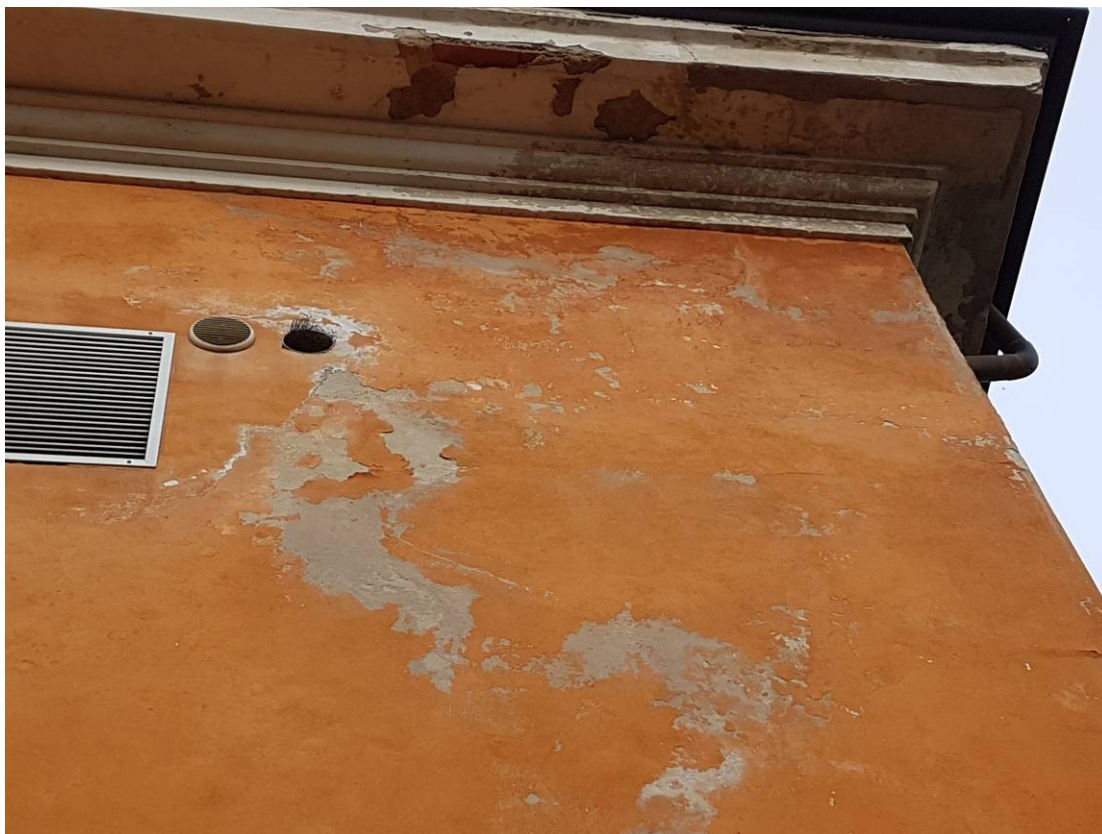
9.particolare degrado prospetto Sud
