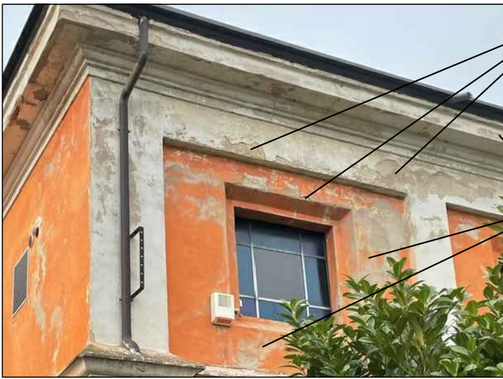
dettaglio del degrado sullo spigolo Sud-Est
