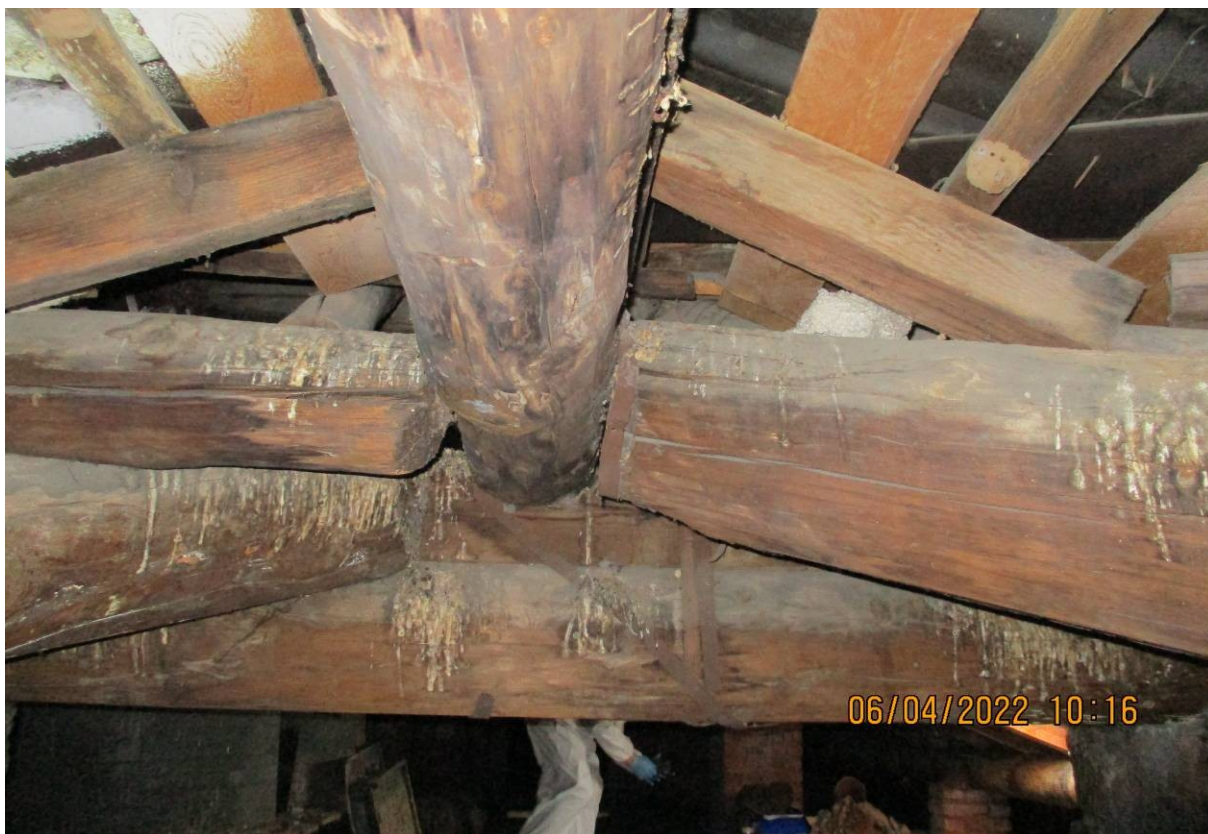
28. dettaglio del punto di appoggio del colmo del settore a doppia falda sul tetto a padiglione
