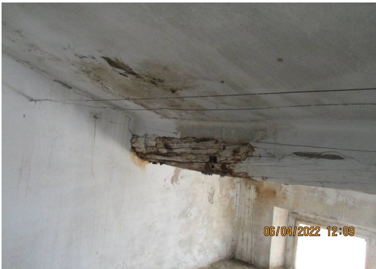
49. particolare di un'infiltrazione nel sottotetto ala "ex villa" sopra il volume con terrazza sul cortile interno adiacente all' "ala Est"
