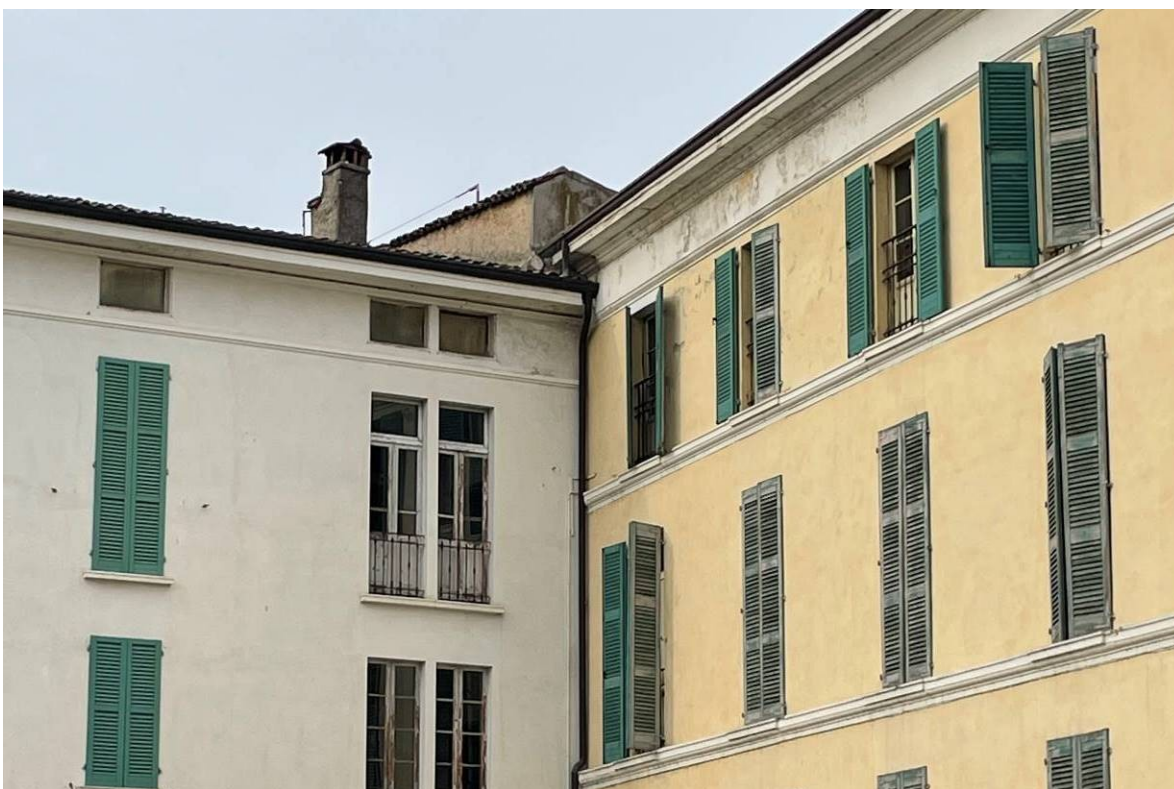
11. particolare dell'innesto delle coperture dell' "ex villa" con l' "ala Est" dal cortile interno
