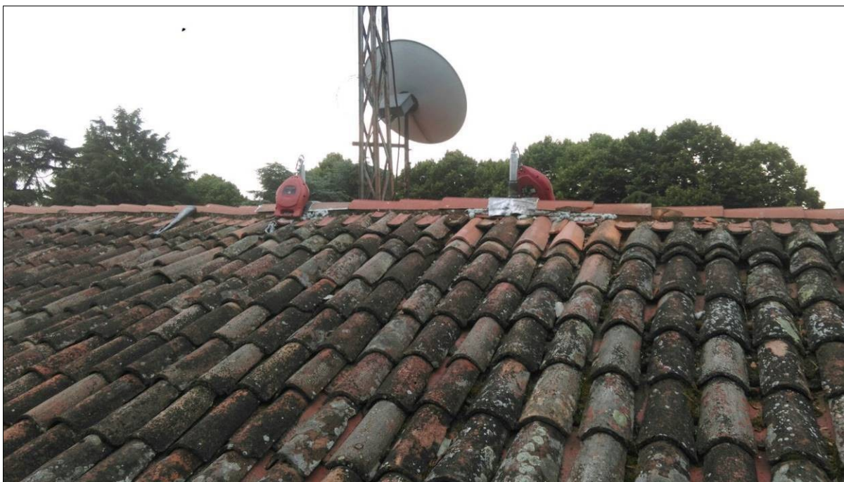
16. particolare dei coppi di copertura della falda Sud dell' "ex villa" – in evidenza il traliccio con la parabola
