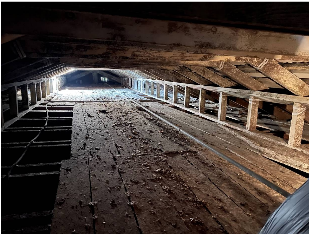
34. vista del sottotetto del settore Ovest . In evidenza la struttura lignea, la finestra sul fondo e la capriata
