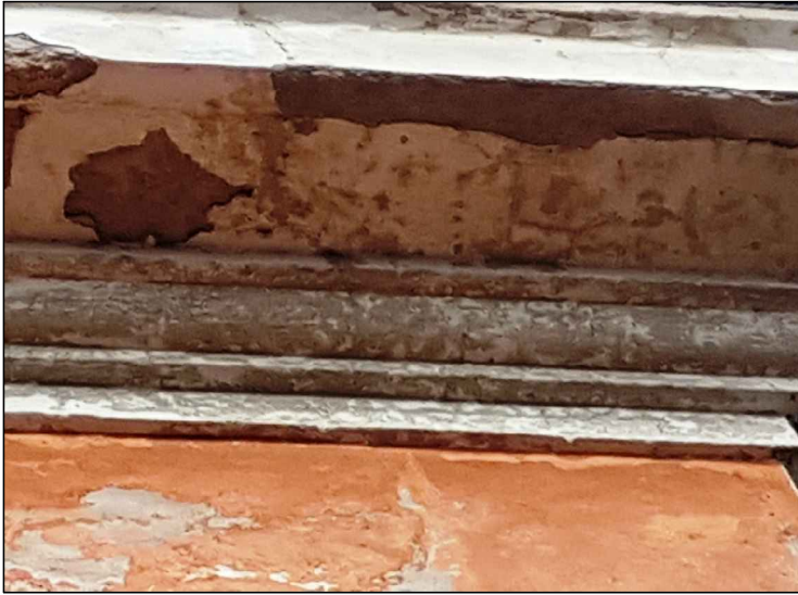
cornicione con porzioni di intonaco sollevato
