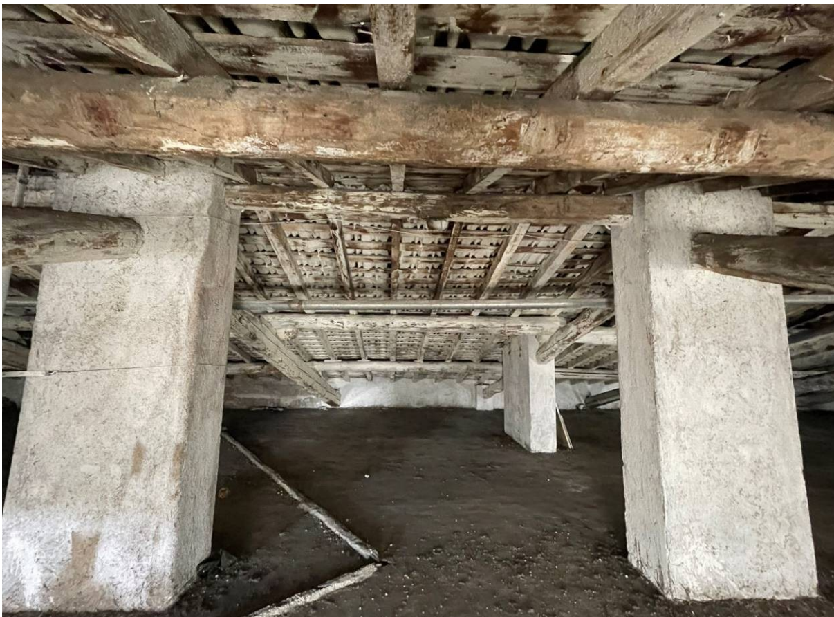
41. particolari della struttura lignea di copertura dell'ala "ex villa" sopra il corpo porticato
