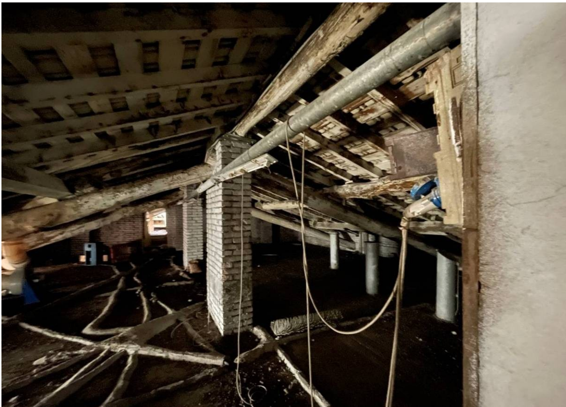
27. scorcio sottotetto "ex villa" nella porzione a dx della scala con setti murari in mattoncini di cotto pieno
