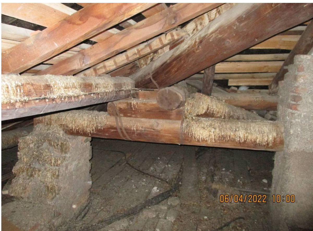
27. particolare del nodo d'innesto sulla copertura a padiglione del settore con copertura a doppia falda
