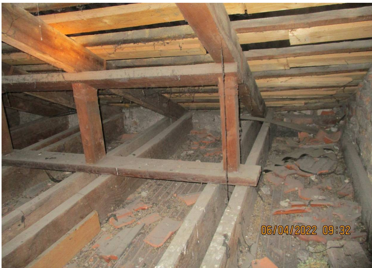
31. vista dell'appoggio dei travetti del settore Est verso cortile interno
