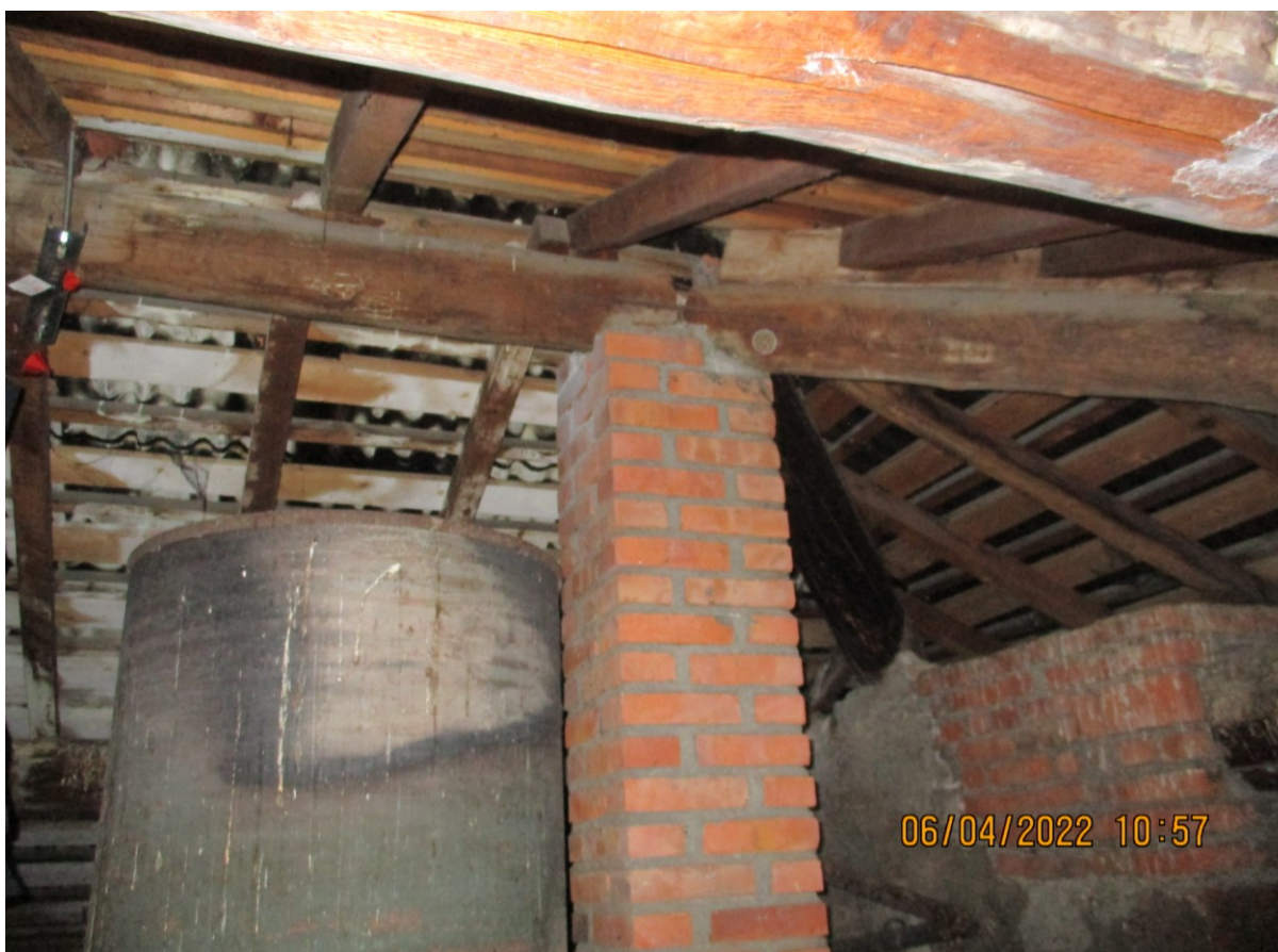
23. vista appoggio colmo del settore centrale con copertura a padiglione
