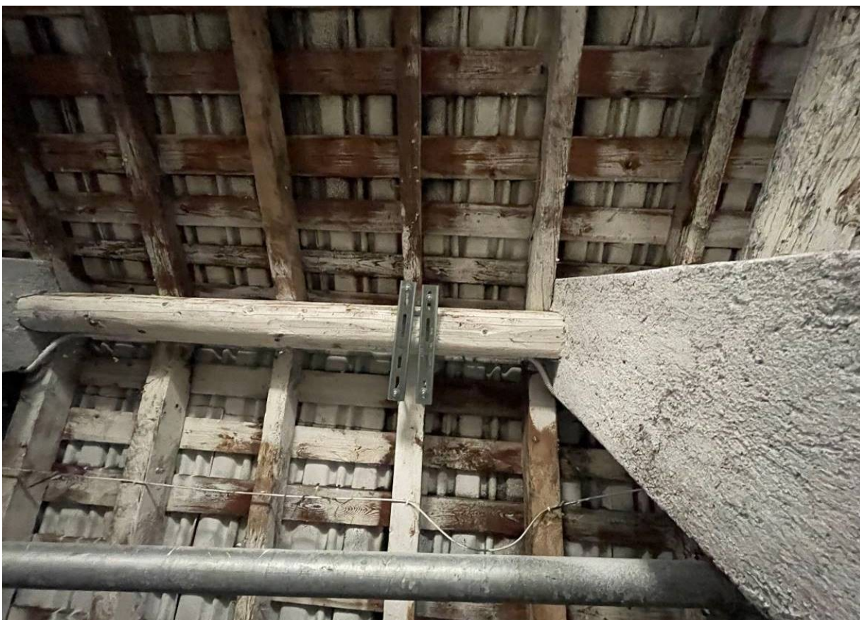
40. particolare della copertura dell'ala "ex villa" – in evidenza la trave di colmo
