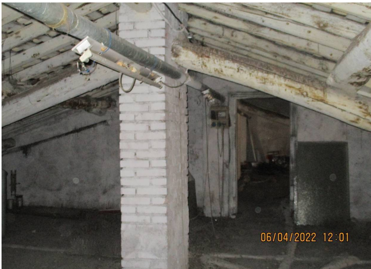
29. vista sottotetto "ex villa" dal settore con muri in mattoni di cotto pieno verso il settore intonacato
