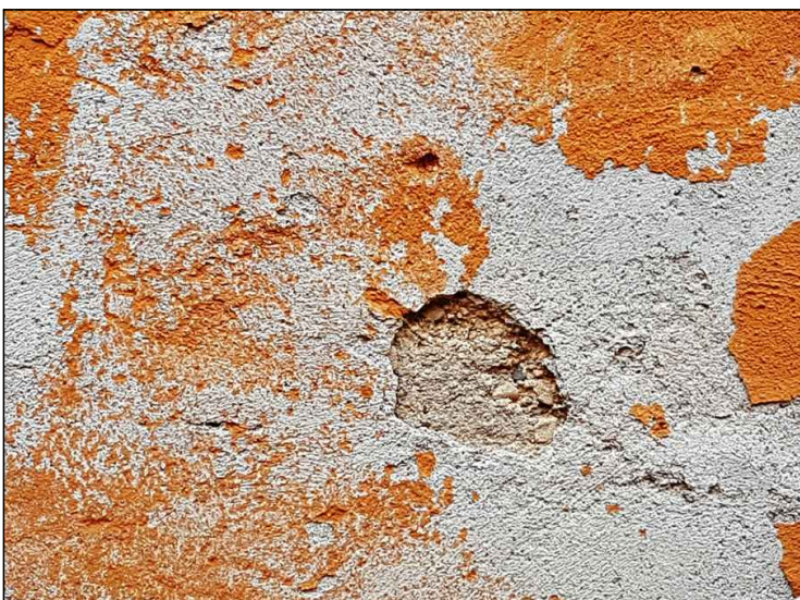
intonaco degradato con distacco locale
