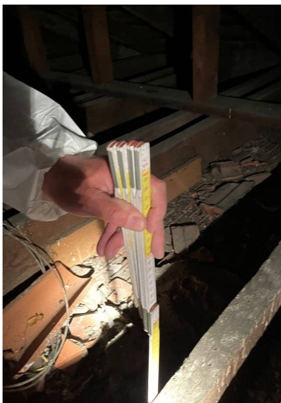
37. dettaglio stratigrafia solaio settore Ovest
