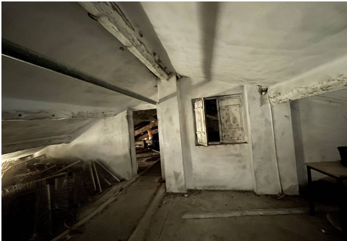
30. scorcio sottotetto "ex villa" dal settore intonacato verso il settore con setti murari in mattoni di cotto pieno a vista
