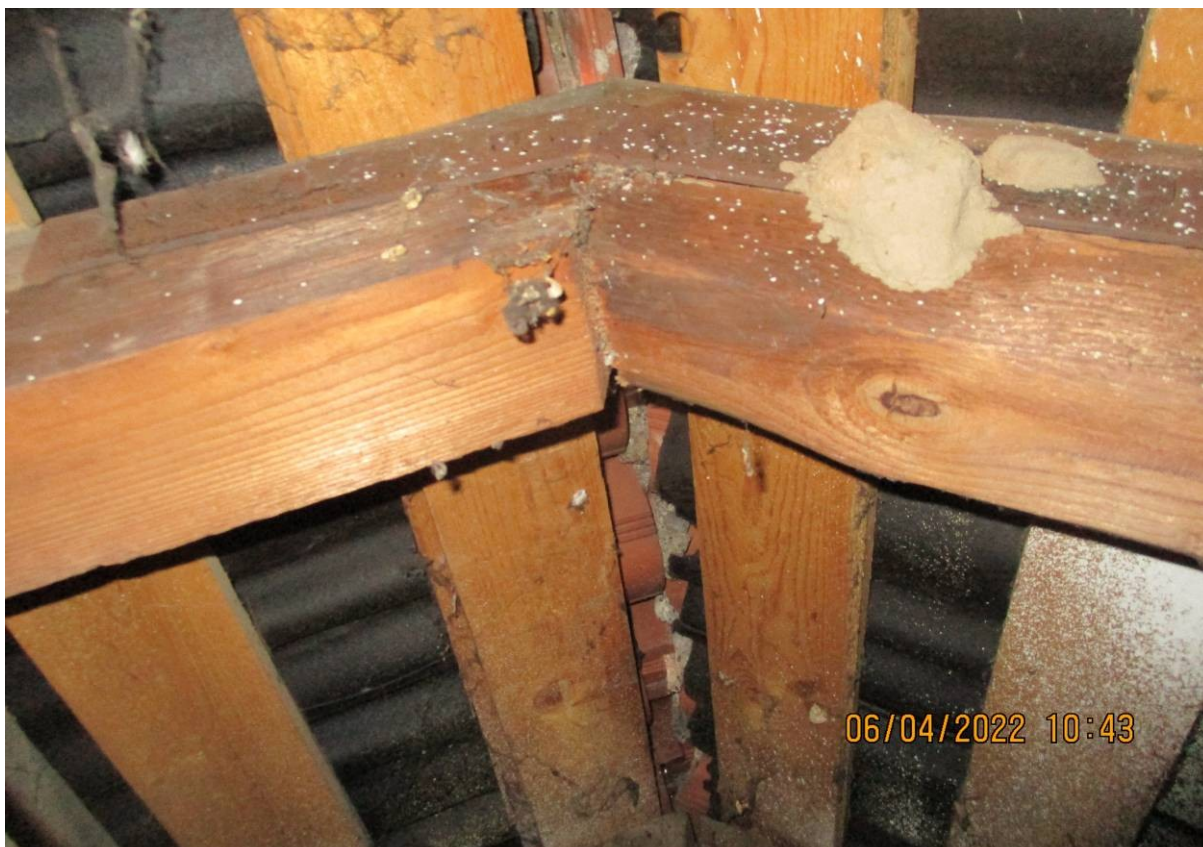
36. dettaglio del colmo settore a doppia falda, in evidenza i coppi sigillati con malta e i pannelli di onduline
