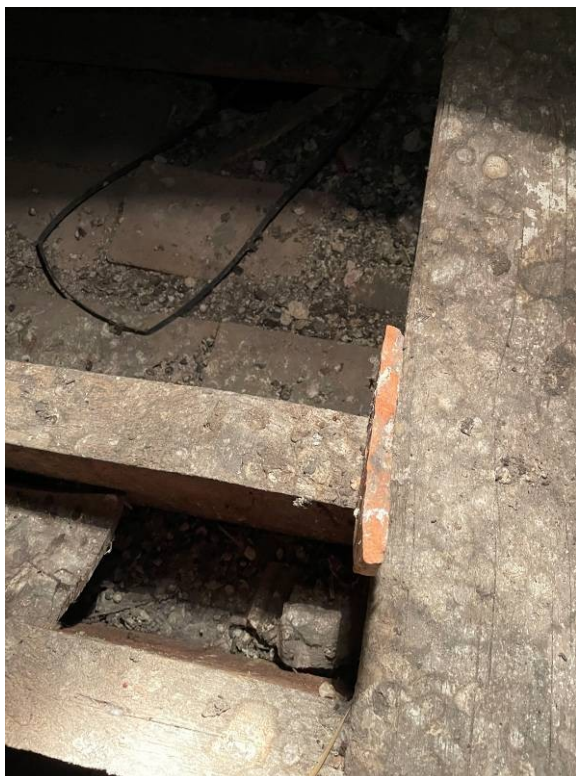
39. dettagli materiali stratigrafia solaio settore Ovest
