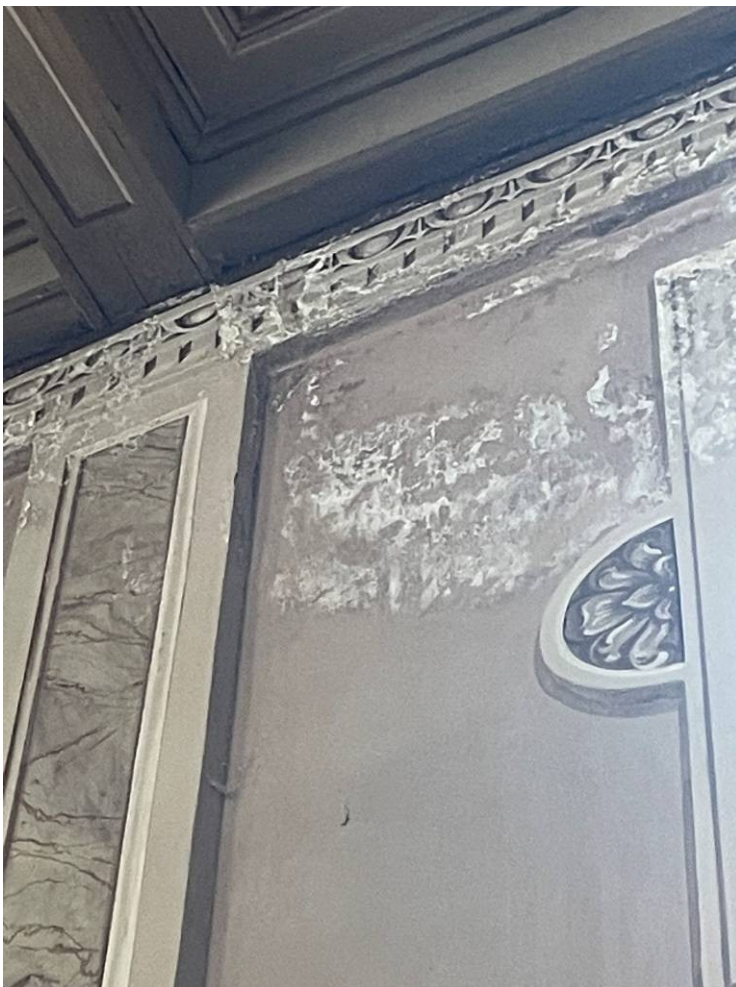
24.particolare degrado interno
