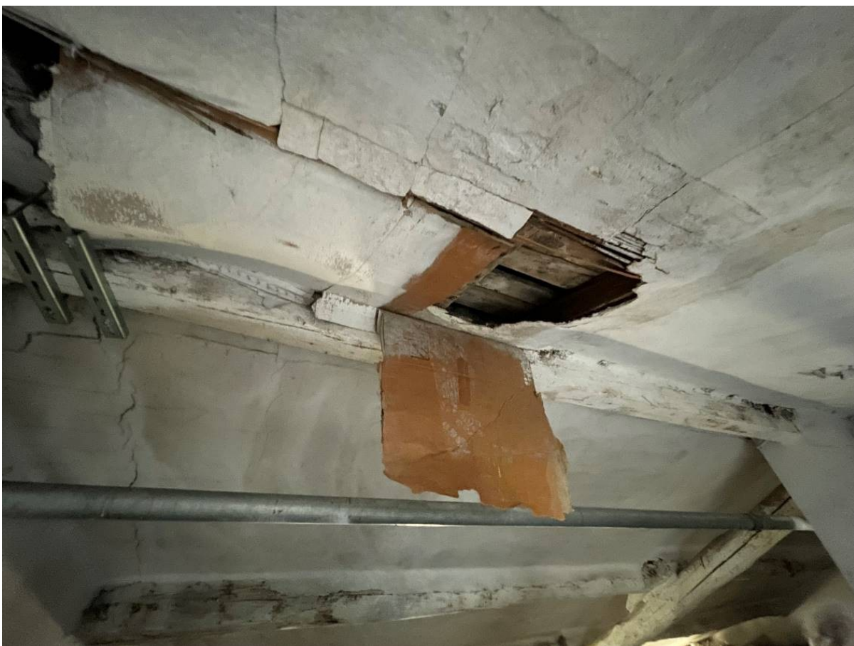
34. vista porzioni ammalorate a causa di infiltrazioni del soffitto in cannucciato intonacato
