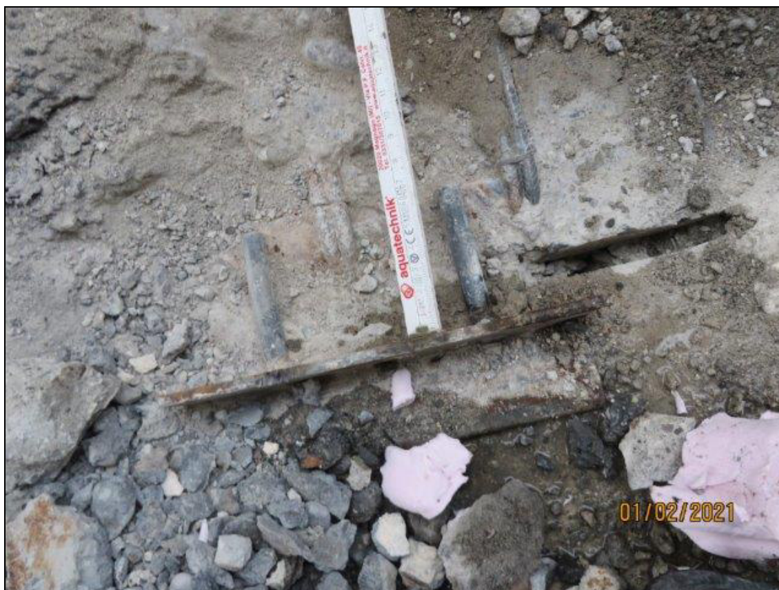
Foto n. 5: particolare sondaggio contro-solaio superiore (1° solaio) corpo B
