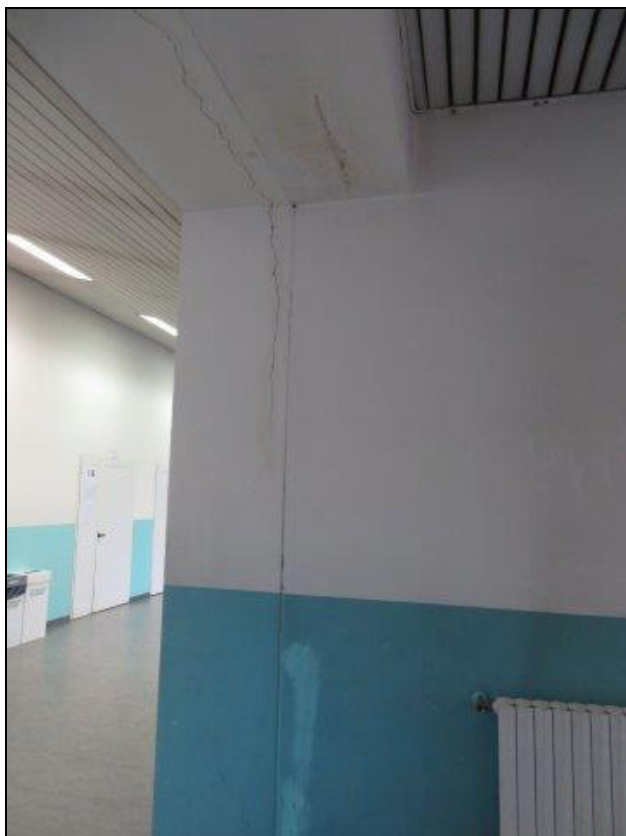
Foto nn. 3-4: giunto dilatazione corpi A2-B
