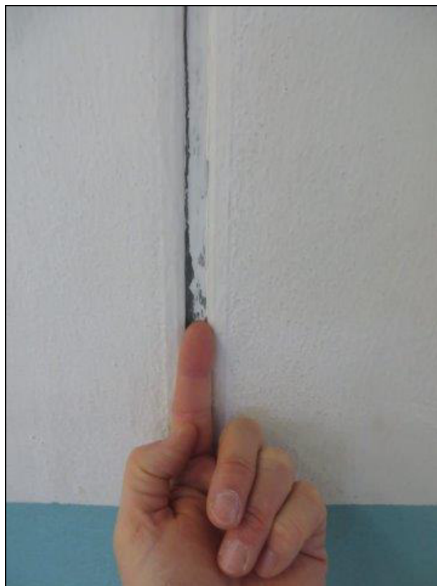
Foto nn. 3-4: giunto dilatazione corpi A2-B
