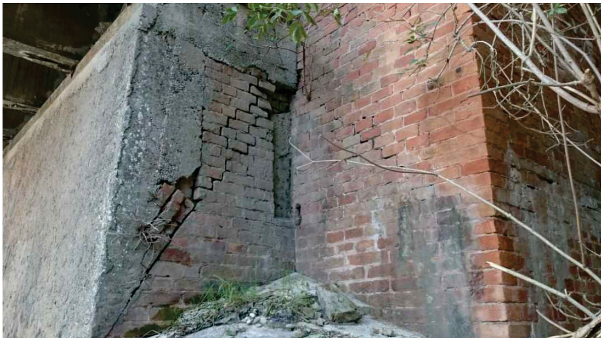
Figura 3: Superficie di soccimento spalle
