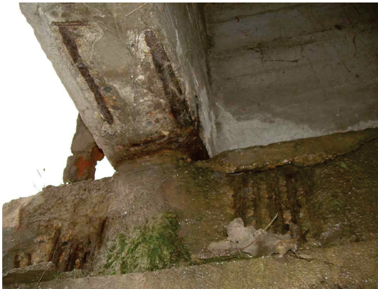
Figura 5: Corrosione armature
