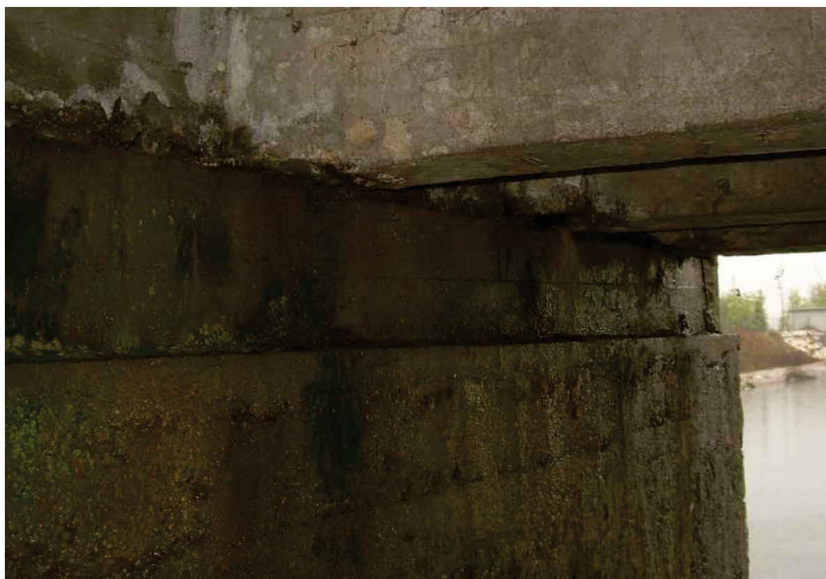
Figura 4: Degrado cls e armature esposte in corrispondenza degli appoggi
