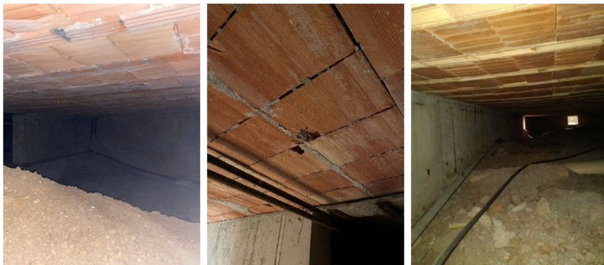
Figura 4 - Tipologie di solaio osservate durante il sopralluogo nel vespaio
