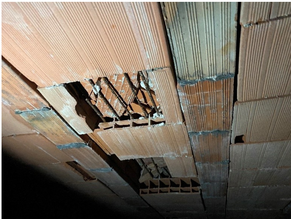
Figura 19 - Intradosso solaio del vespaio areato
