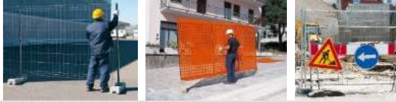
ALLESTIMENTO RECINZIONE INTERNA DI CANTIERE (delimitazione area di intervento)
