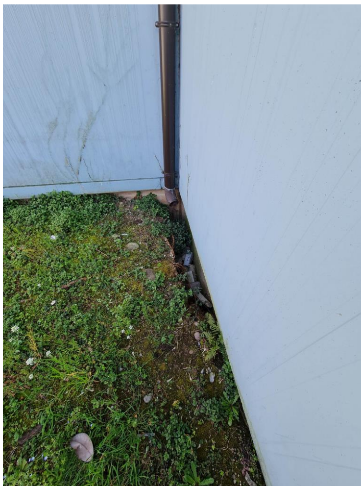
Fig. 6 pluviale non collegato
