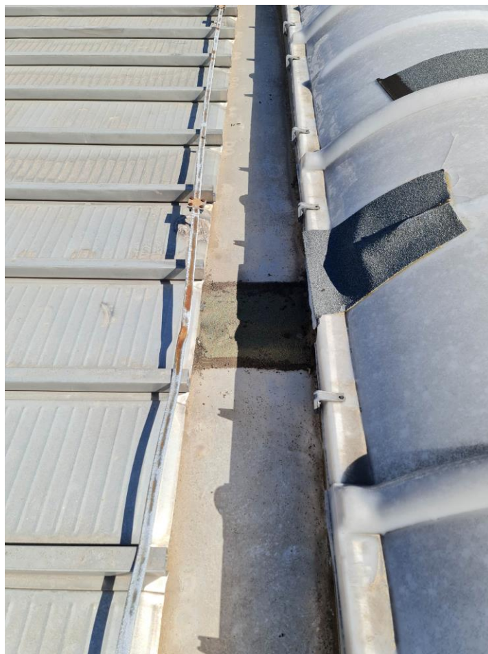
Fig. 9 canale in alluminio e lucernario riparati con guaina
