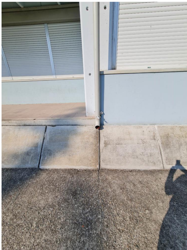
Fig. 7 pluviale non collegato
