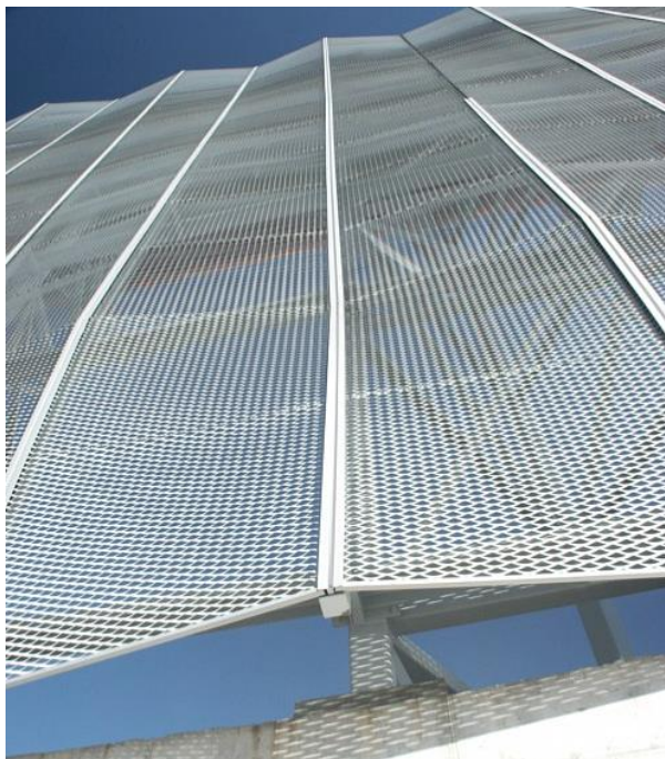
Figura 3 – Lamiera stirata posata a protezione del telaio sismo-resistente in acciaio.
