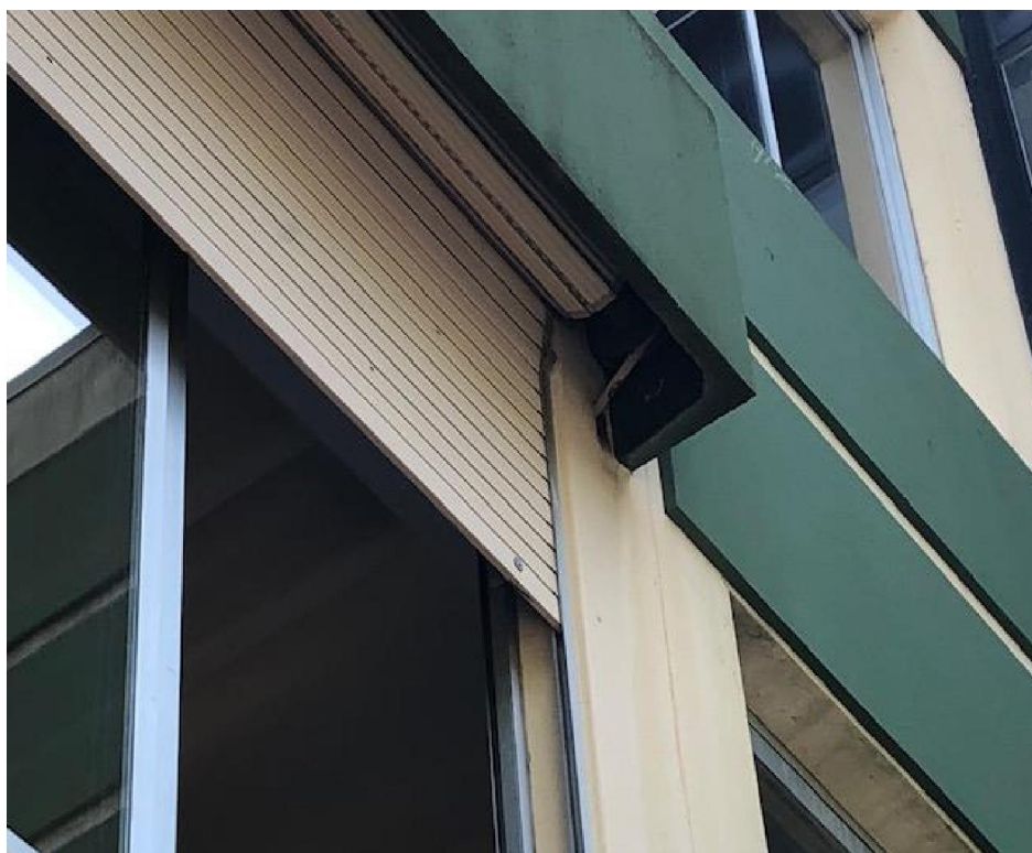
Foto 7: Particolare tapparella esterna da sostituire
