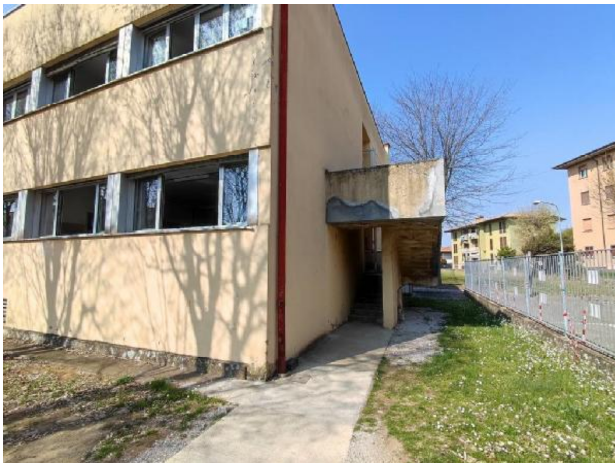
Foto n.7 – Sulla destra nella foto la scala in muratura, a servizio dei piani primo e secondo, di cui è prevista la sostituzione con una nuova scala metallica.
