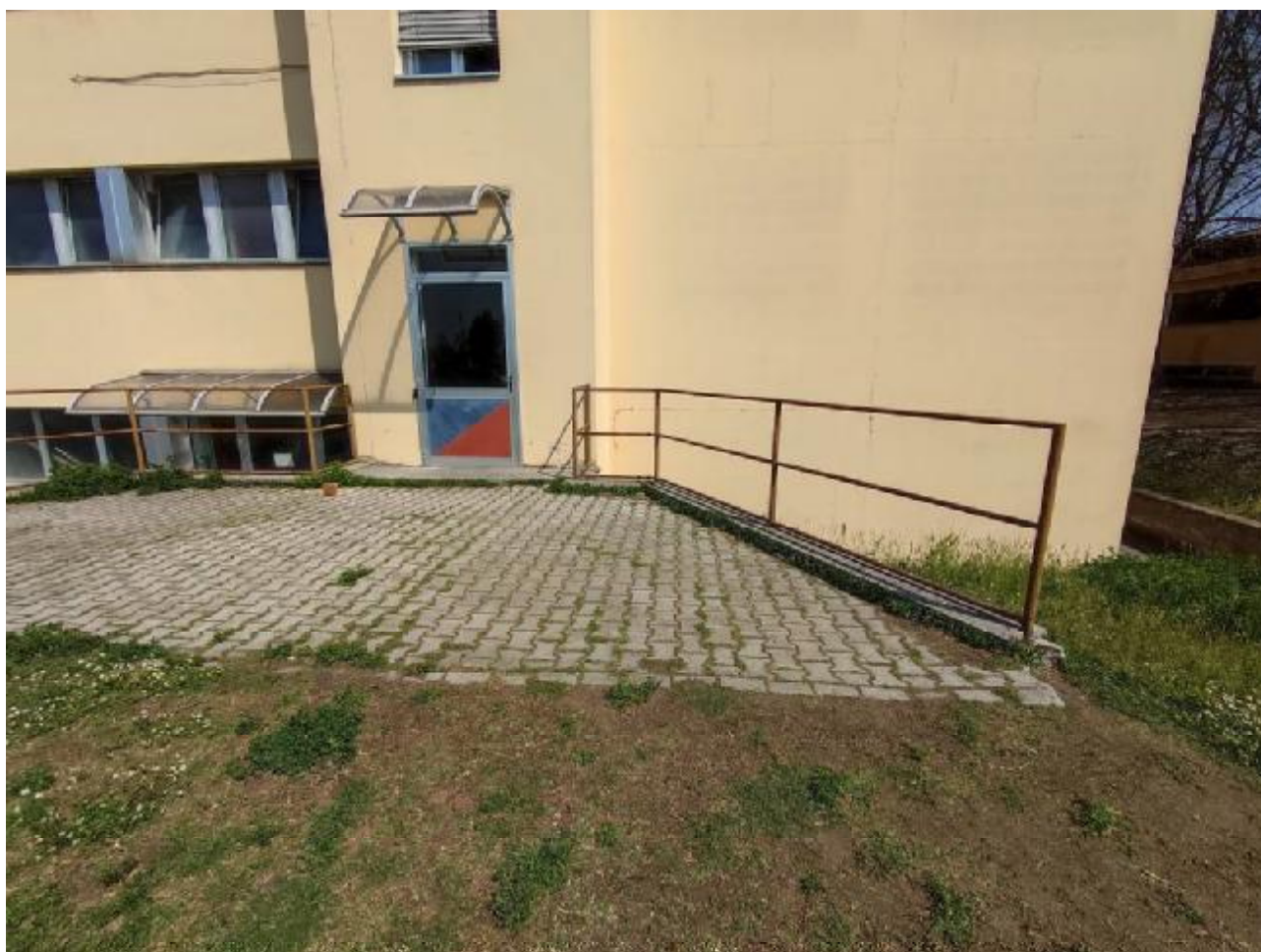
Foto n.10 – Parapetto su area pertinenziale del complesso scolastico, di cui è prevista la sostituzione con un nuovo parapetto regolamentare.
