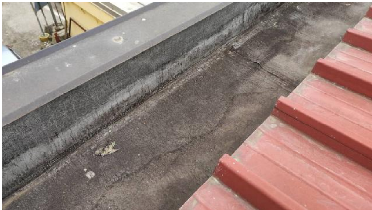
Foto n.3 – Particolare canale di scolo acque meteoriche lungo il perimetro della copertura.
