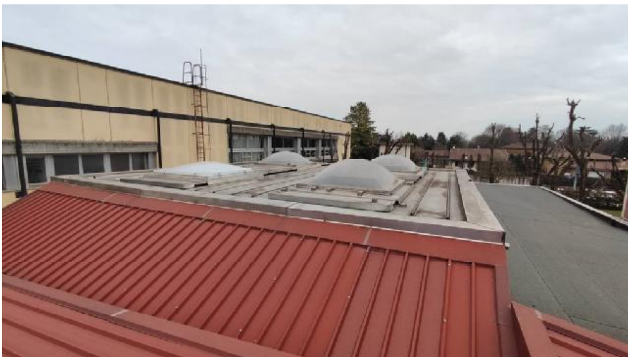
Foto n.2 – Copertura in lamiera piana con lucernai. A destra copertura in guaina bituminosa ardesiata.
