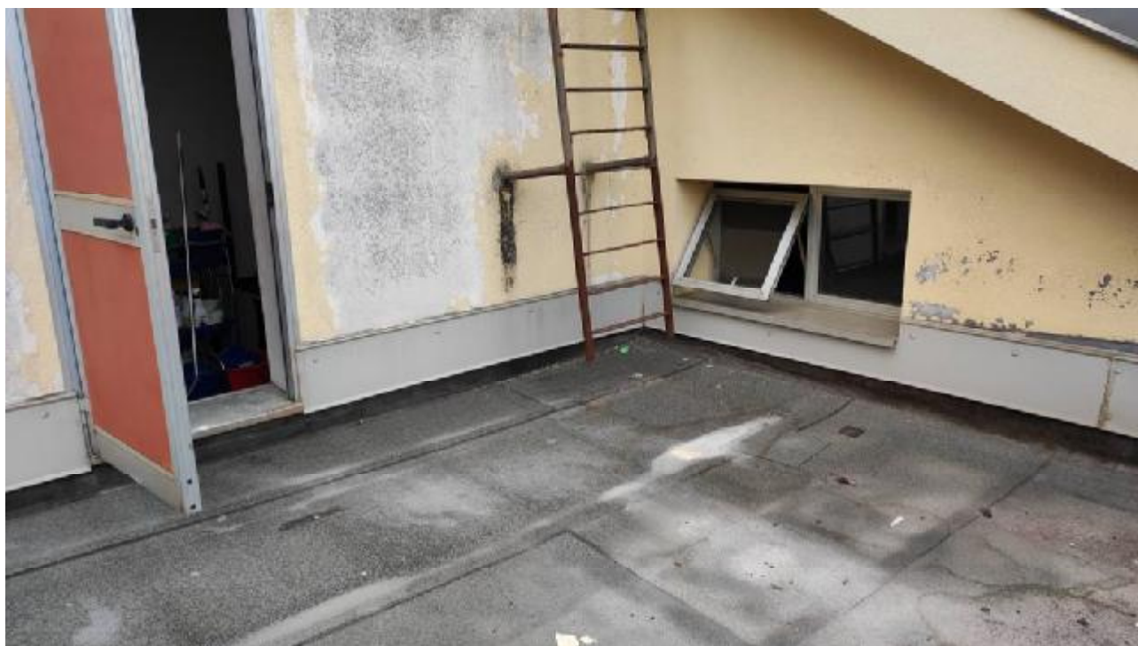
Foto n.4 – Punto di accesso alla copertura da blocco "C". Si nota la scala per il superamento di quota tra corpo "A" e i corpi "B" e "C"., di cui è prevista la sostituzione.
