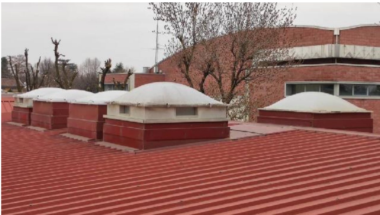
Foto n.1 – Copertura in lamiera a falda con lucernai in sommità.
