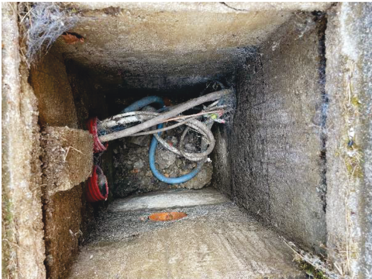
Figura 34 - Pozzetto rete elettrica (da demolire)
