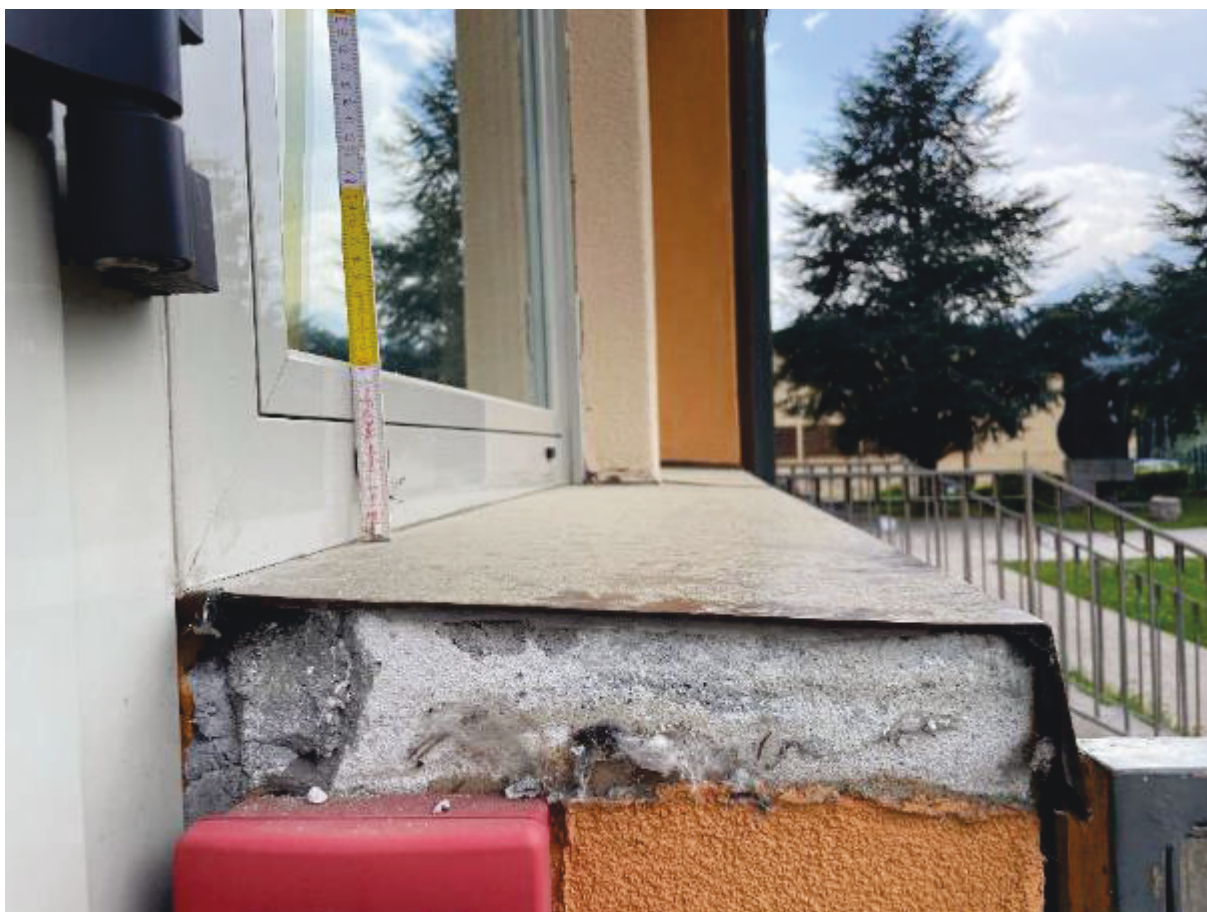
Figura 30 - Davanzale esistente tipo (da rimuovere)
