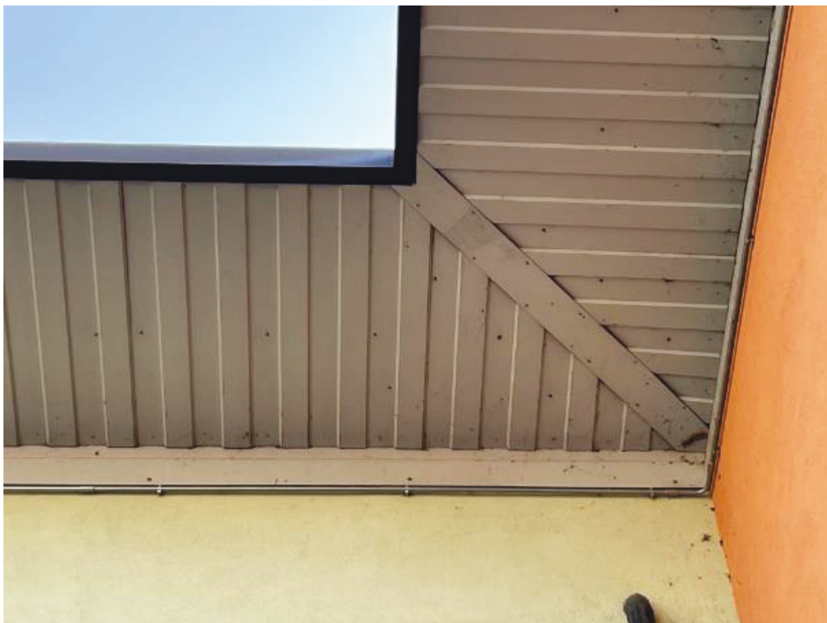
Figura 24 – Grondino in lamiera (da rimuovere)
