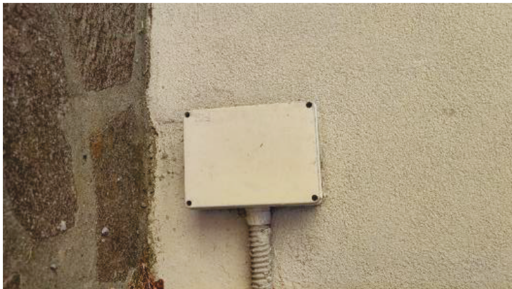
Figura 47 - Scatola di derivazione esterna (oggetto di rimozione e riposa)
