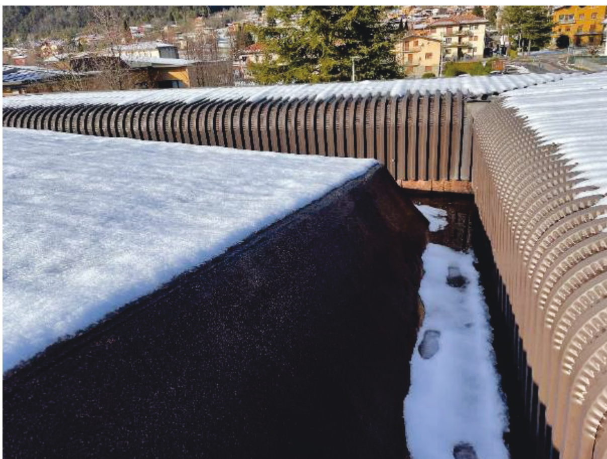
Figura 38 - Lamiera parapetto copertura
