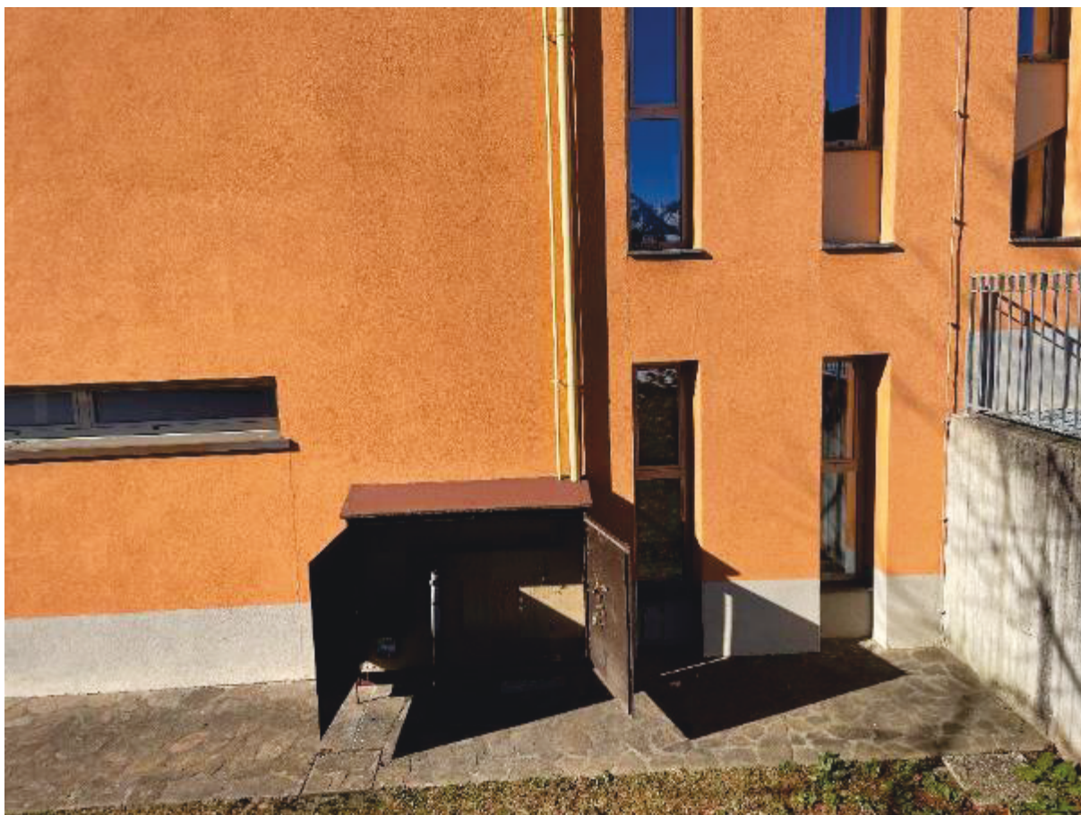
Figura 26 - Cassonetto contatore metano lato Est (rimozione)
