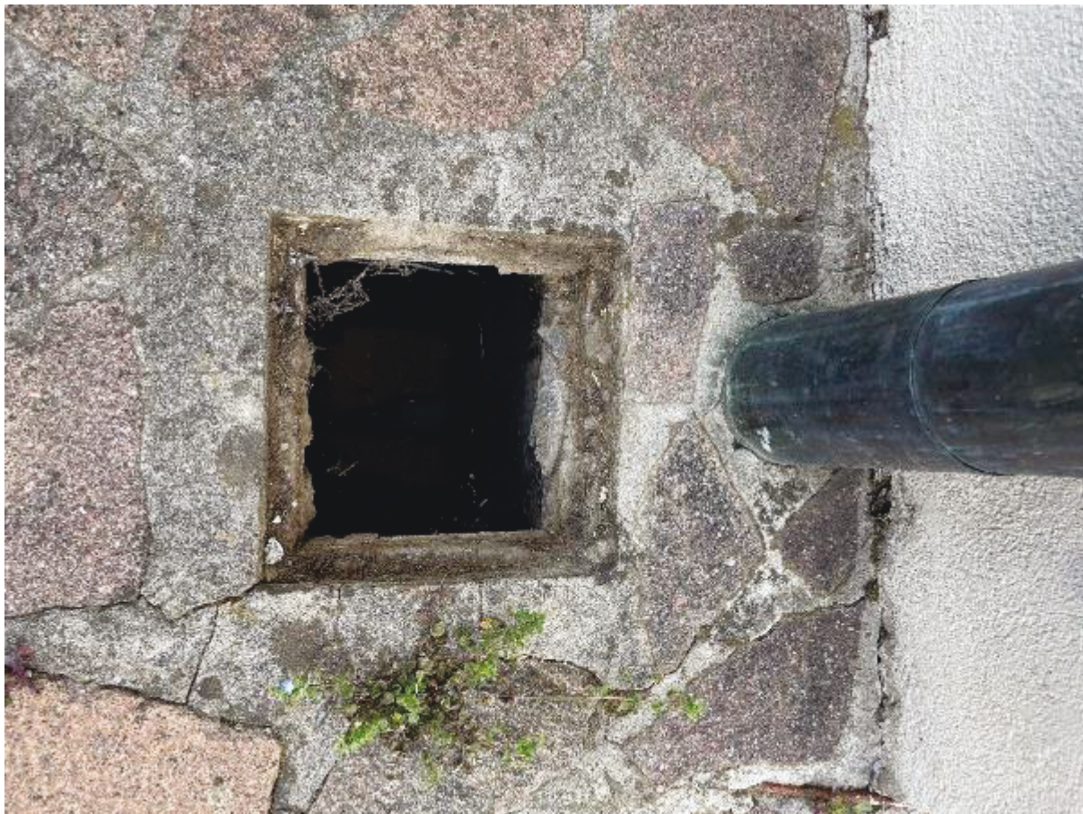
Figura 32 - Pozzetto pluviale tipo (spostamento e revisione)
