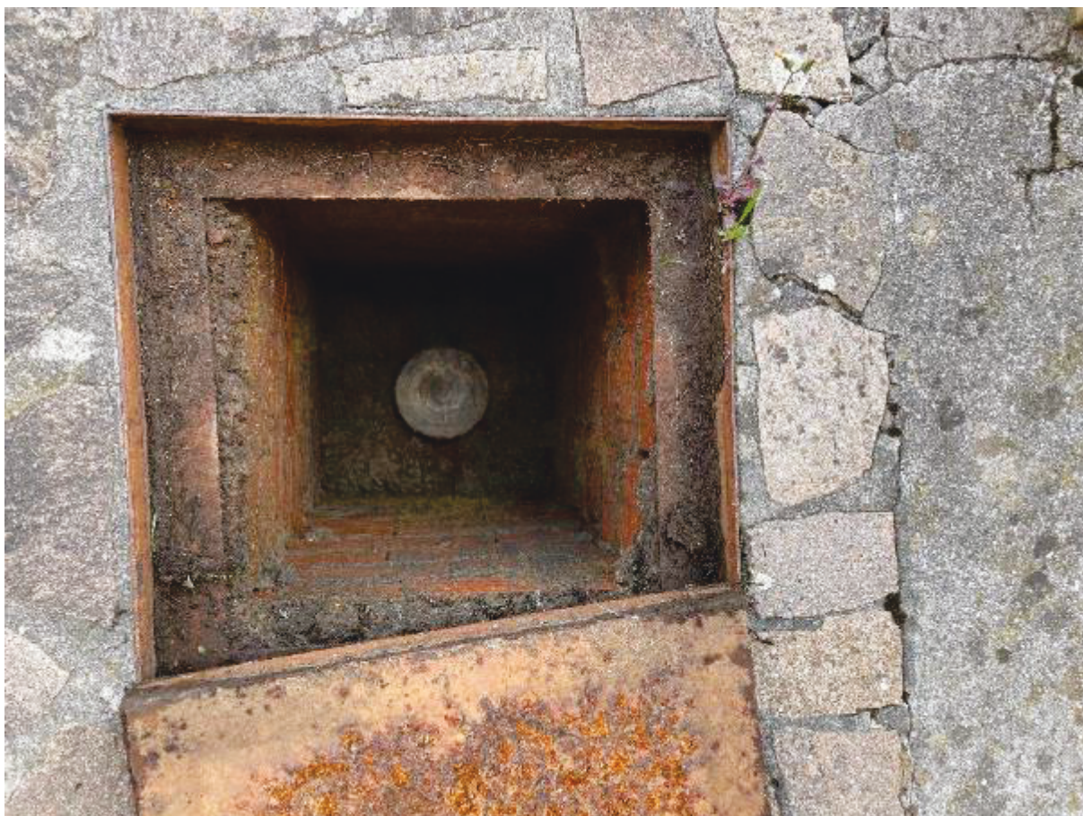
Figura 33 - Pozzetto sifone acque nere (da spostare)
