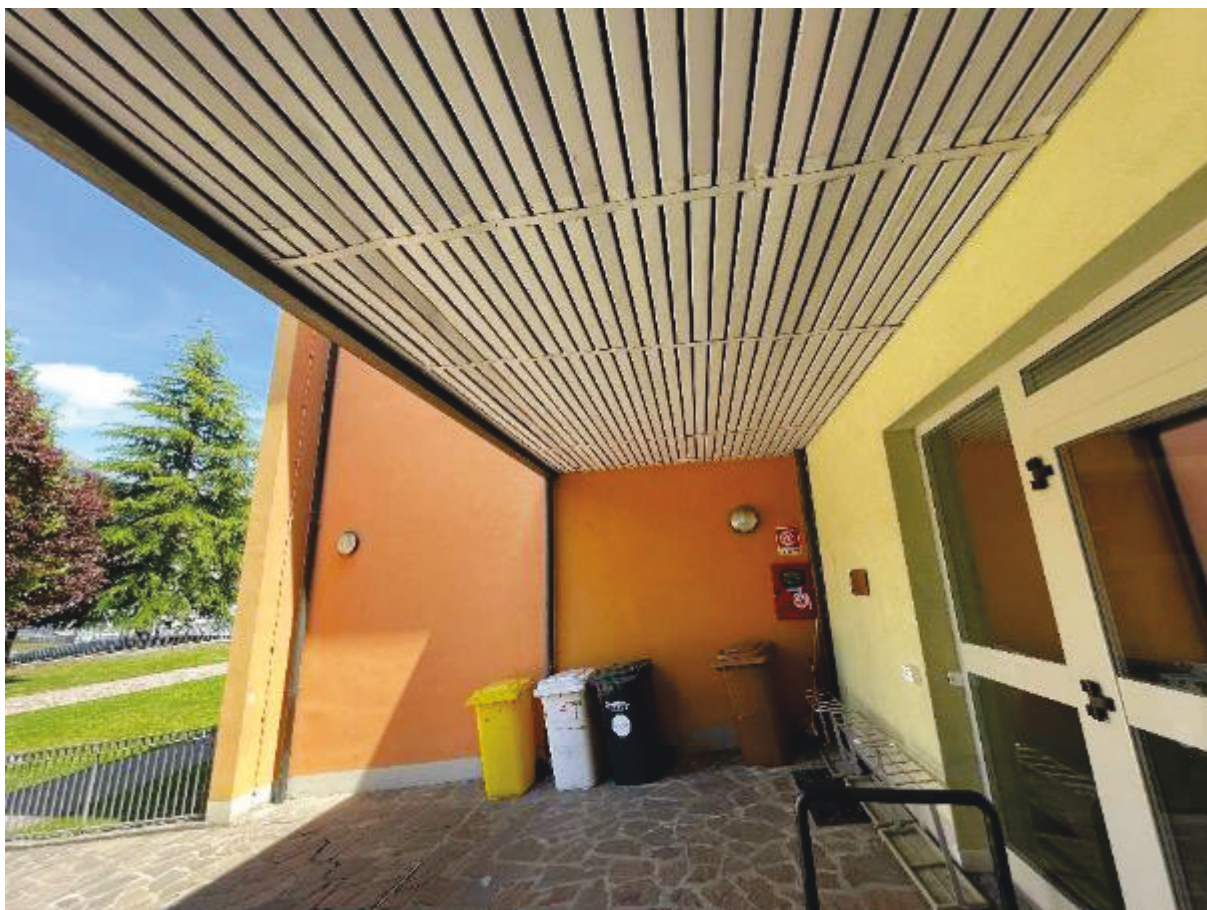
Figura 37 - Tamponamento tettuccio ingresso (rimozione e rifacimento)
