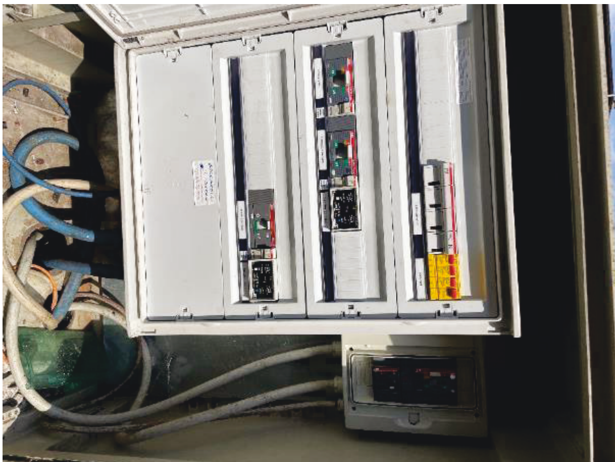
Figura 36 - Quadro generale (da spostare)
