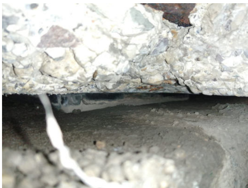
Fig.17: appoggio in buono stato, presenza ristagno acqua.
