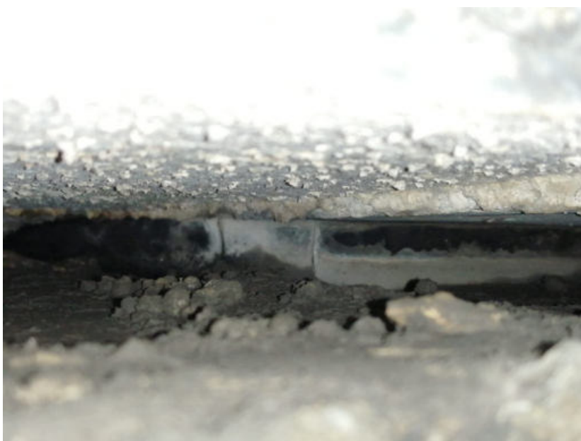
Fig.13: appoggio in buono stato, presenza ristagno acqua.
