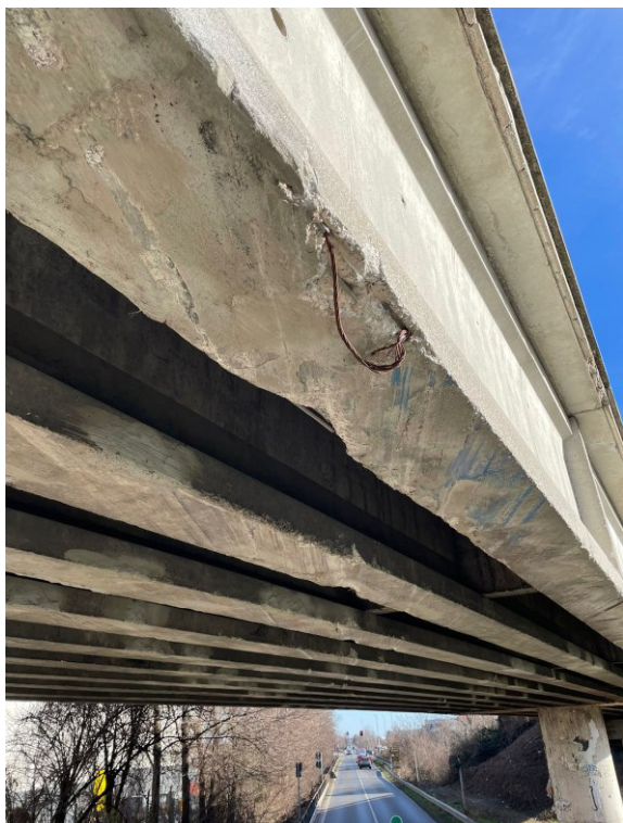
Imm. 15: Urti veicolari sotto travi C.A.P. e trefolo tranciato su trave BC 1
