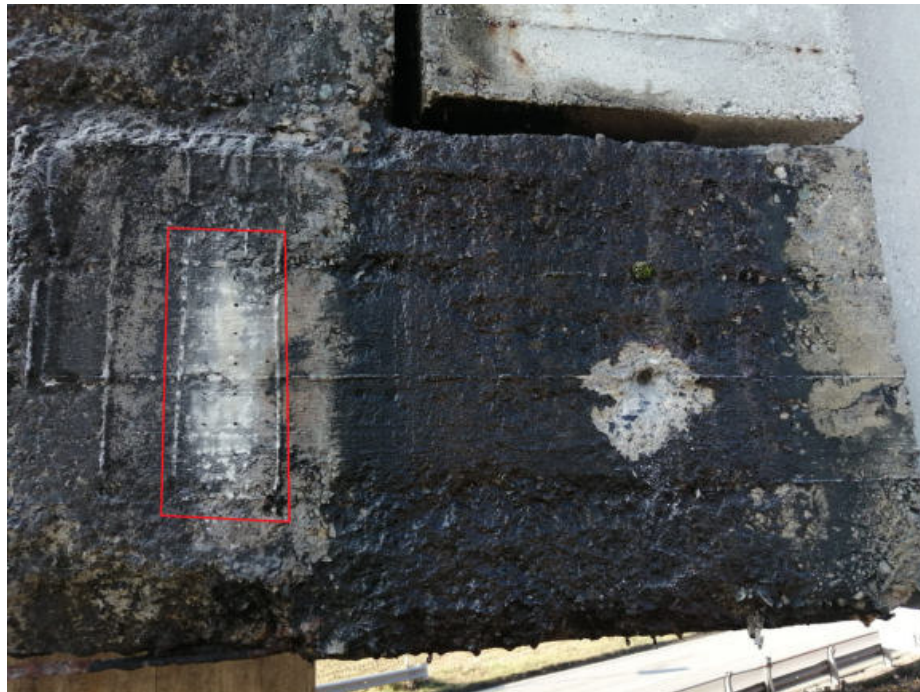
Fig.11: ubicazione battute sclerometriche su mensolina 2 sella Gerber pila B.
