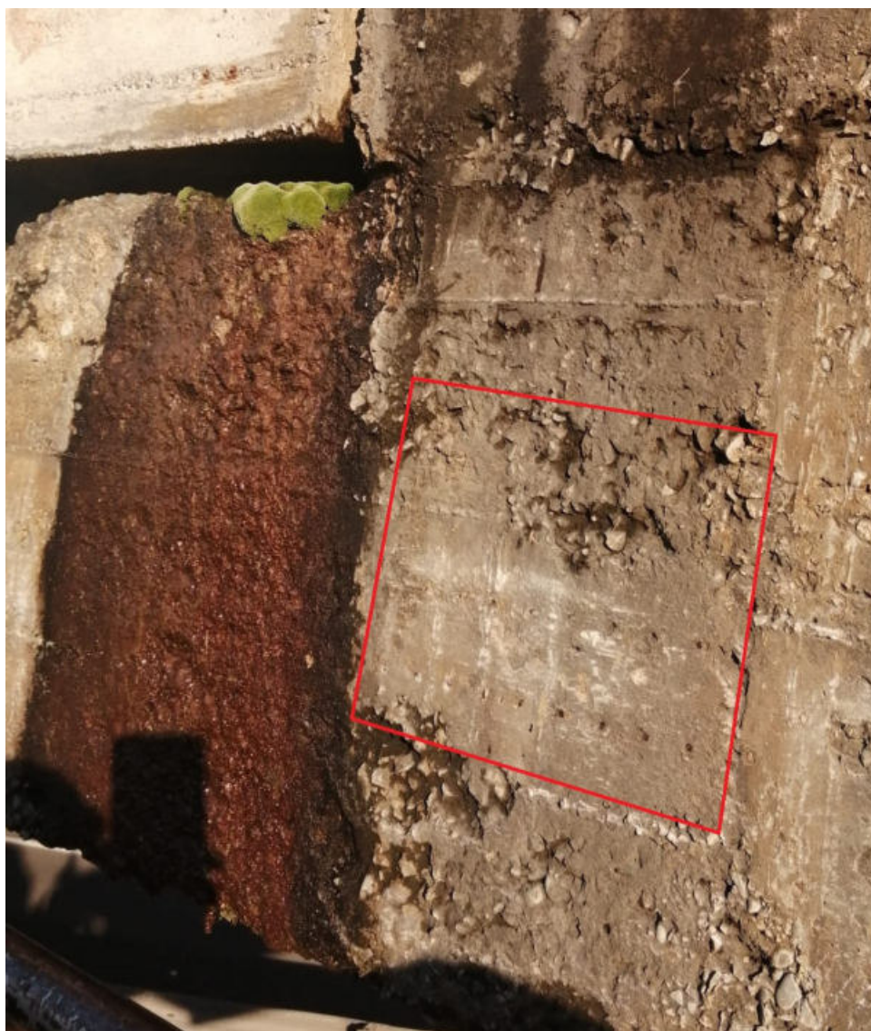
Fig.10: ubicazione battute sclerometriche su anima sella Gerber pila C.
