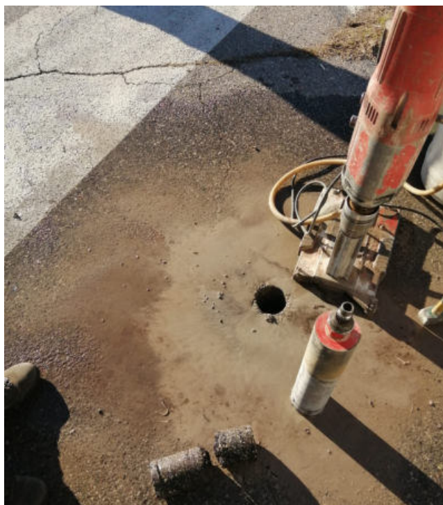
Fig.3: esecuzione carota C1 pila C.
