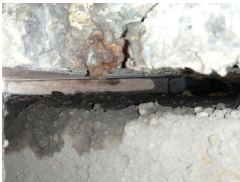
Fig.12: appoggio in buono stato, presenza ristagno acqua.
