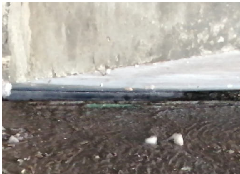
Fig.8: appoggio spalla A trave 4 campata AB.
