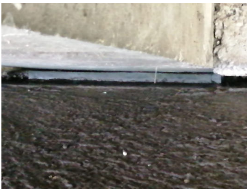
Fig.19: appoggio spalla D trave 6 campata CD.
