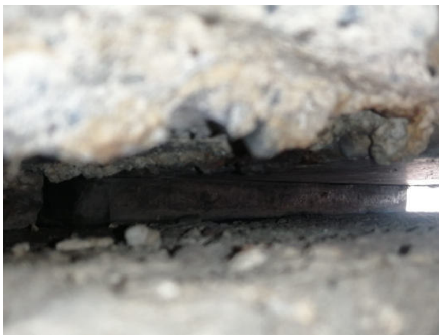
Fig.16: appoggio in buono stato, presenza ristagno acqua.
