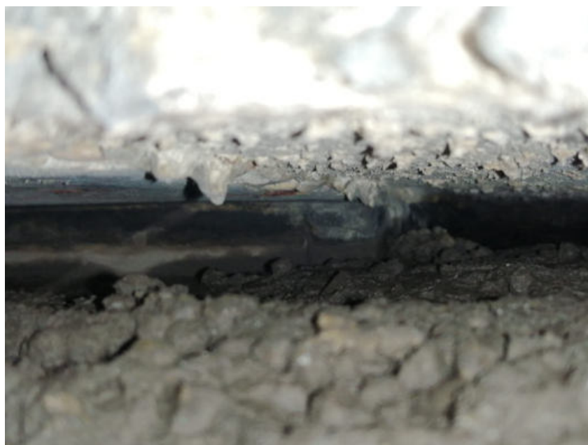
Fig.15: appoggio in buono stato, presenza ristagno acqua.
