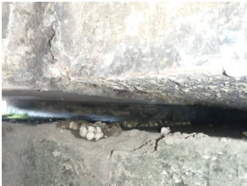
Fig.14: appoggio in buono stato, presenza ristagno acqua.
