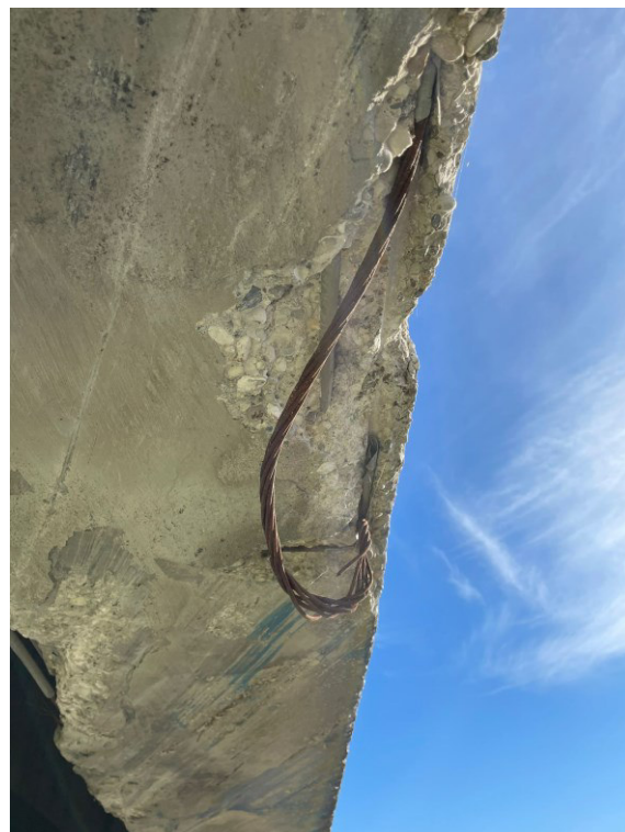
Imm. 15: Urti veicolari sotto travi C.A.P. e trefolo tranciato su trave BC 1
