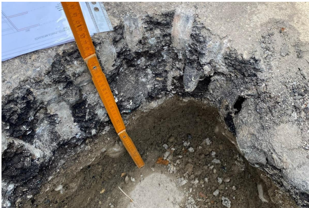
Figura 21: Manufatto BSSP011_P008: ricarica materiale su impalcato (lato nord)
