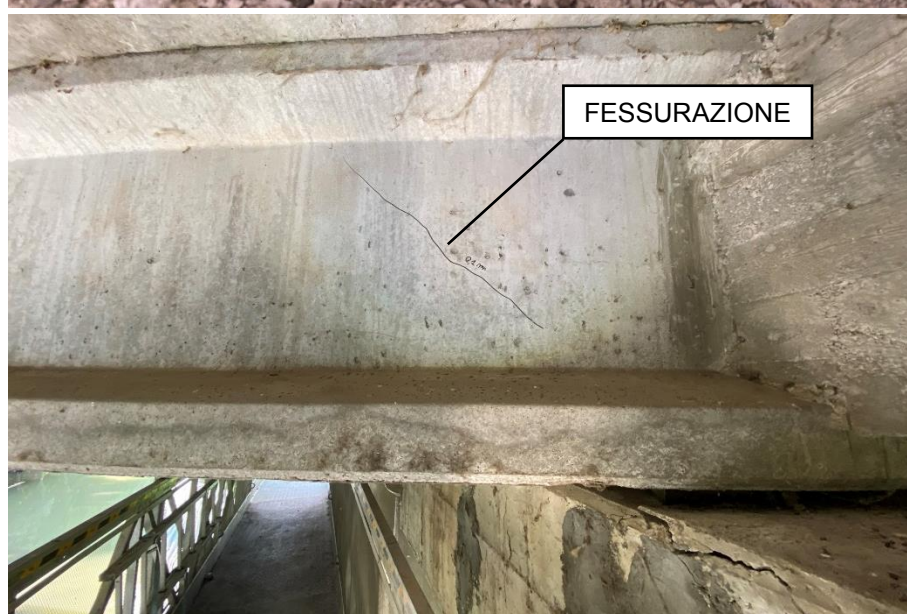
FESSURAZIONE TRAVE A2 (vista laterale)
