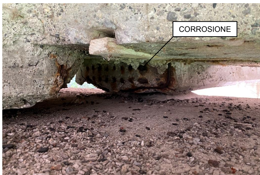
CORROSIONE TRAVE A2 (testata)
