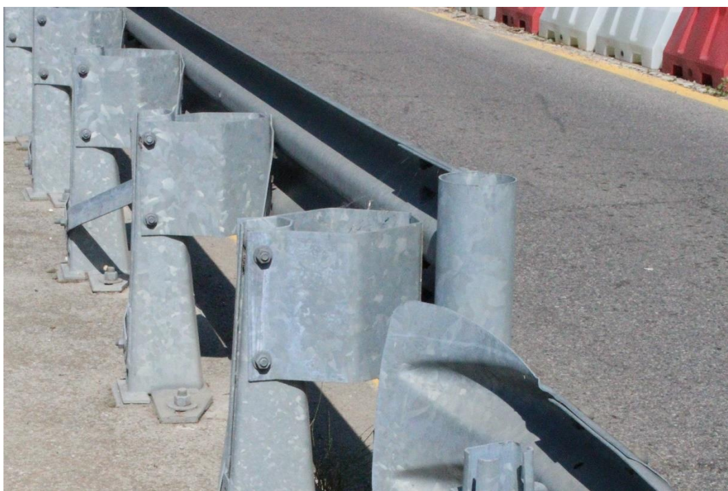
Figura 18: Manufatto BSSP011_P008: barriera di sicurezza stradale (lato sud)
