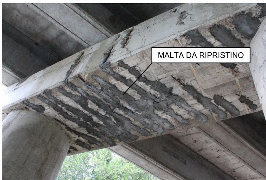
Figura 5: Individuazione di un intervento di carattere non strutturale sulla US2 allo stato di fatto (2021-06-28)
