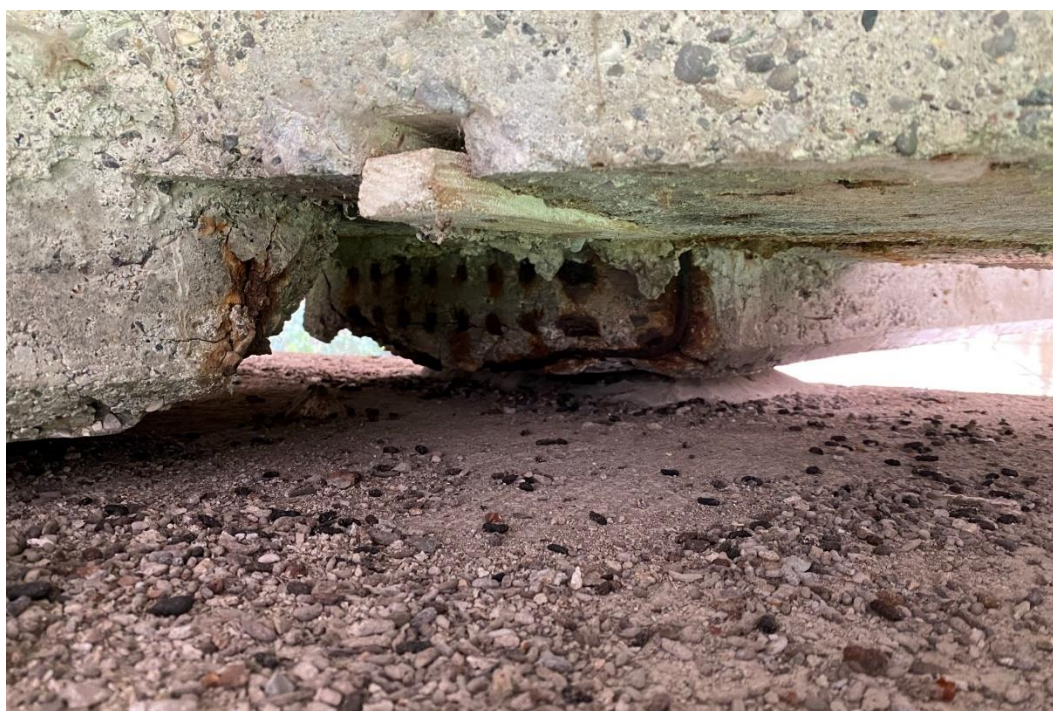
Figura 14: Manufatto BSSP011_P008: trave A2-OVEST (appoggio est)
