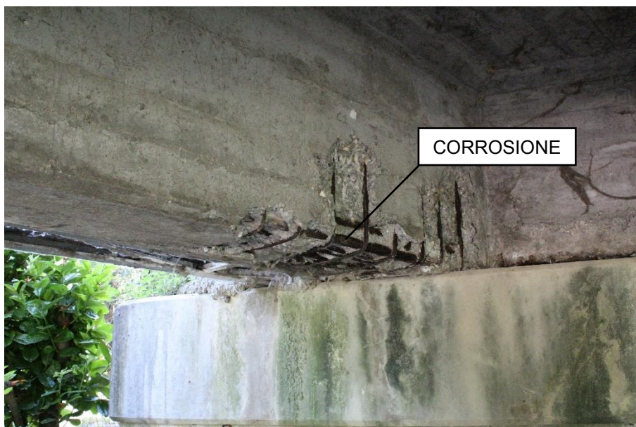
CORROSIONE TRAVE S1 (vista laterale)
