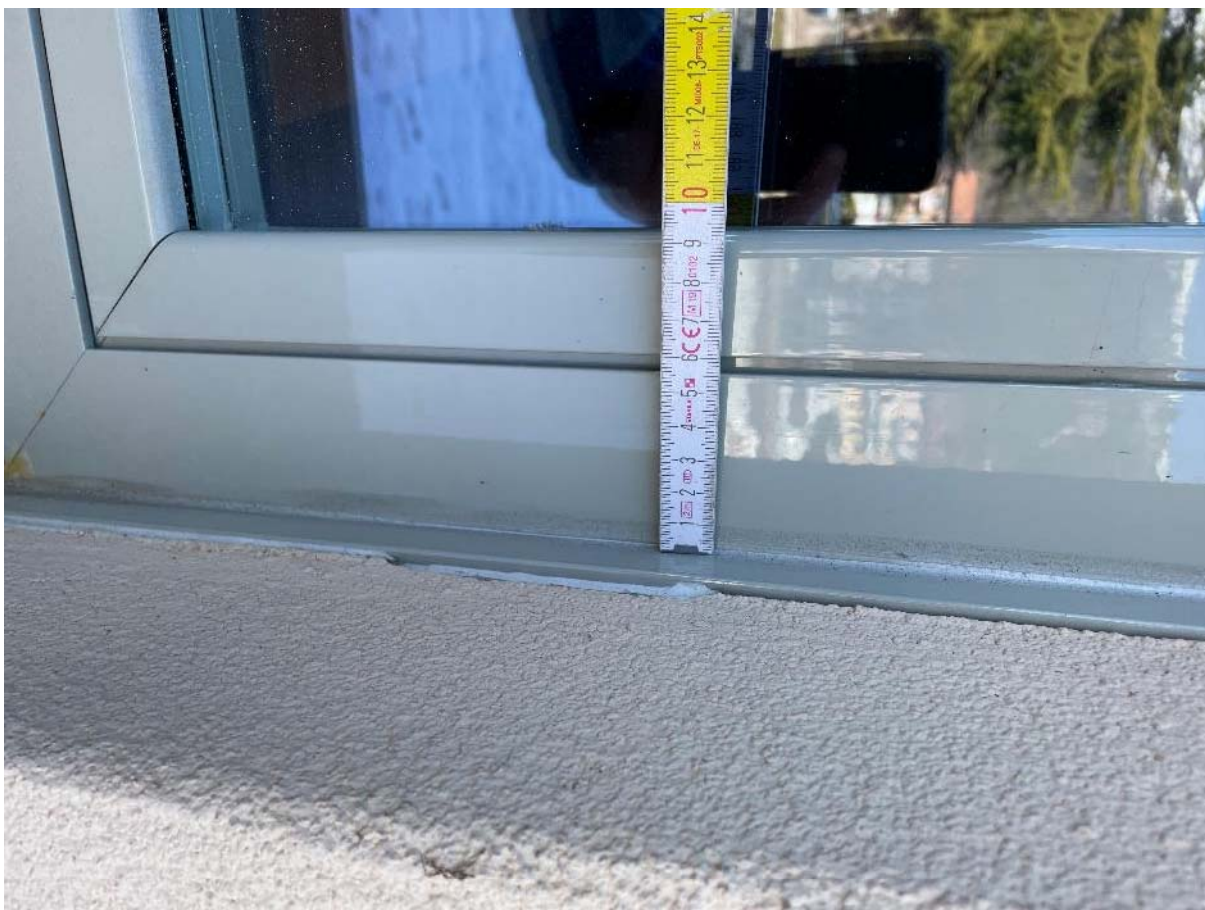
Figura 31 - Telaio spalle finestre esistenti (da isolare)
