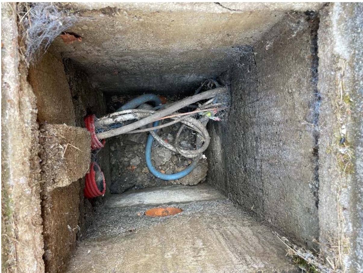
Figura 34 - Pozzetto rete elettrica (da demolire)
