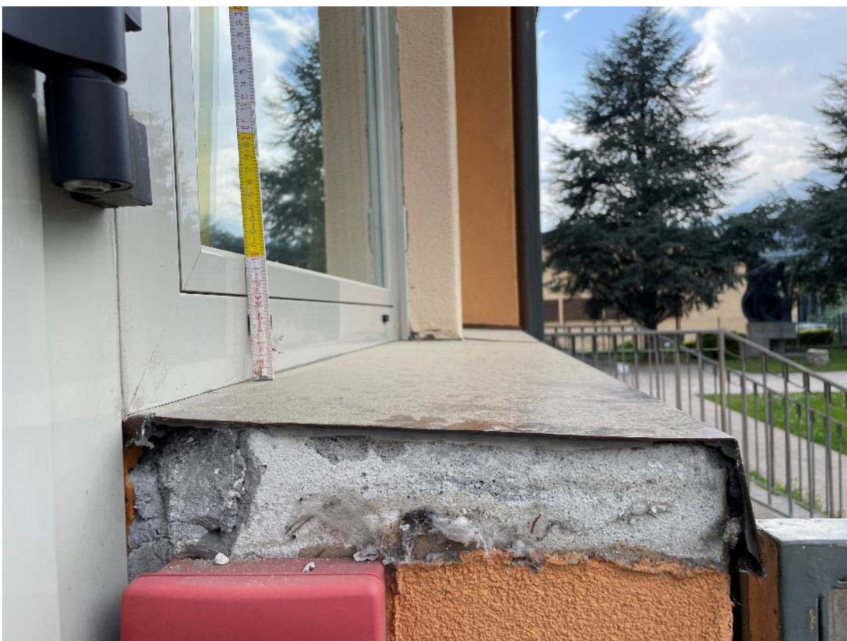
Figura 30 - Davanzale esistente tipo (da rimuovere)
