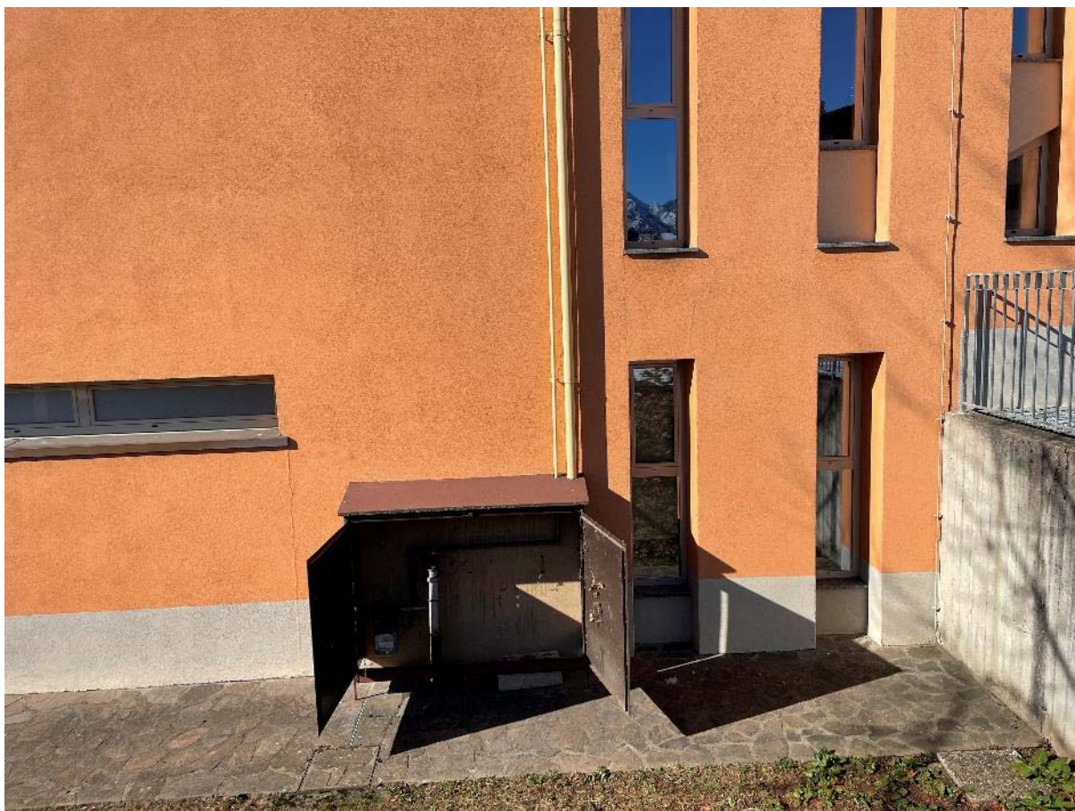
Figura 26 - Cassonetto contatore metano lato Est (rimozione)
