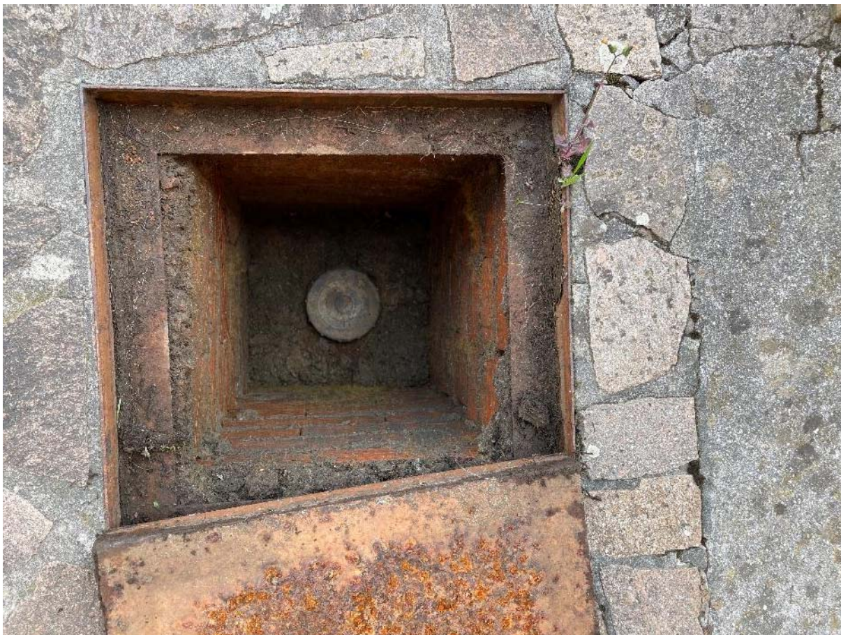
Figura 33 - Pozzetto sifone acque nere (da spostare)
