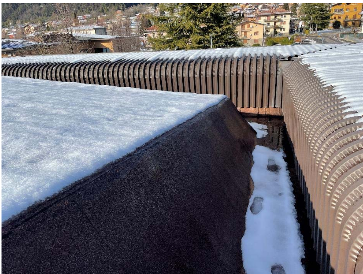
Figura 38 - Lamiera parapetto copertura
