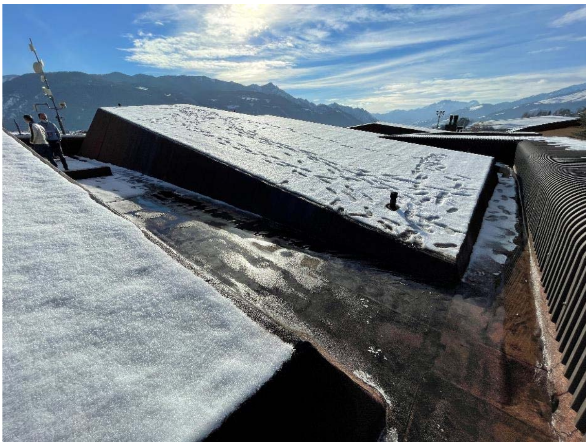
Figura 39 - Copertura con padiglioni (posa nuova impermeabilizzazione)
