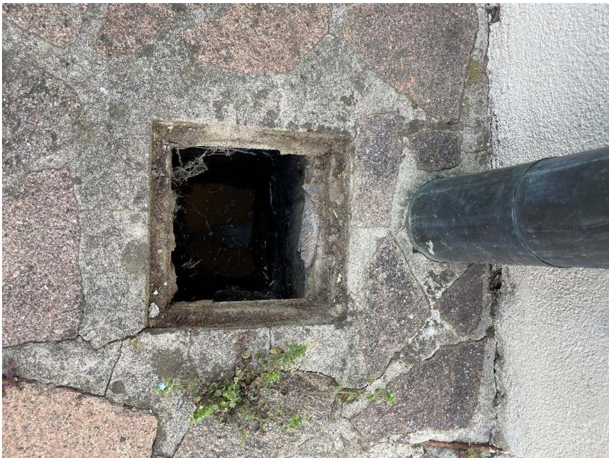
Figura 32 - Pozzetto pluviale tipo (spostamento e revisione)
