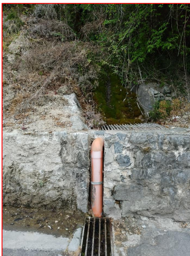
Figura 3 - Manufatti di raccolta di una sorgente lungo Via Donatori di Sangue
