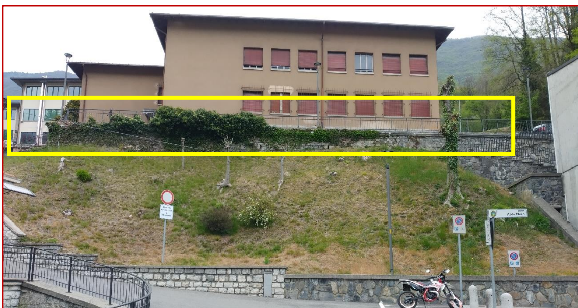
Figure14–Muro oggetto di sostegno mediante paratia berlinese
