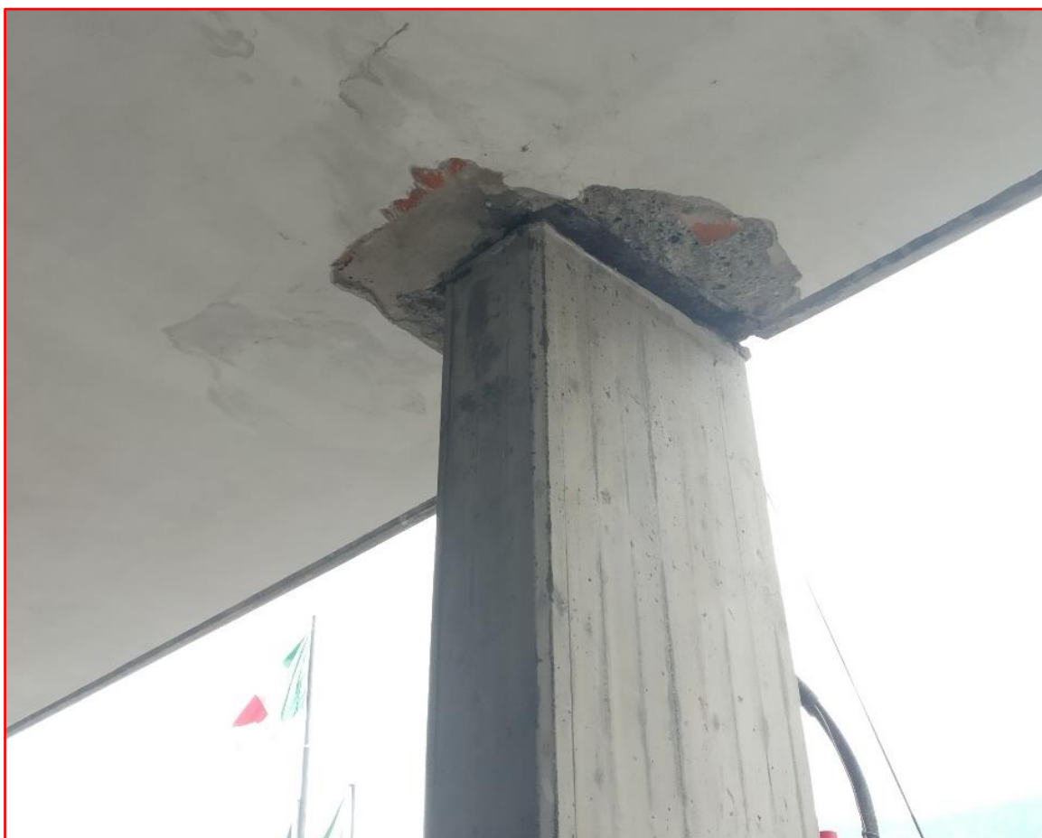
Figura 5 – Sfilamento dei pilastri esterni presso l'ingresso del municipio
