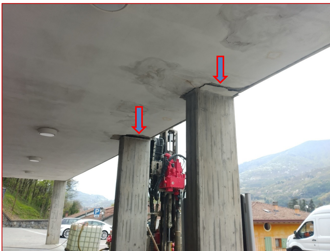
Figura 19 – Pilastri centrali ceduti (foto eseguita durante i sondaggi geognostici)
