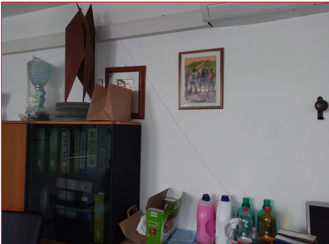
Figure 22 – Lesionamenti nei tavoli interni del municipio
