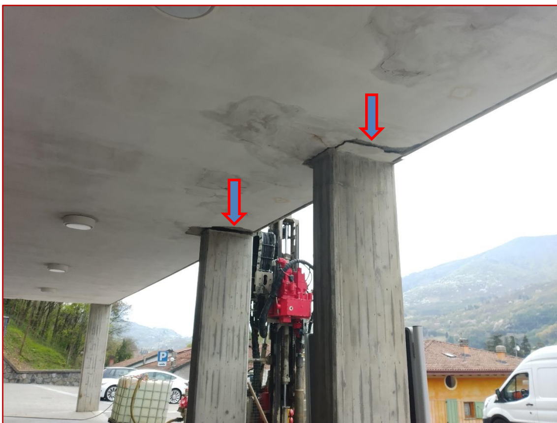
Figura 20 – Pilastri centrali ceduti (foto eseguita durante i sondaggi geognostici)
