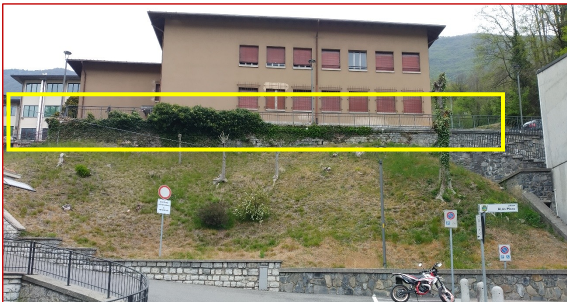
Figure14–Muro oggetto di sostegno mediante paratia berlinese
