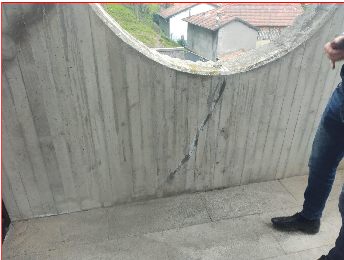
Figura 21 – Forature circolari al primo piano oggetto di rinforzo
