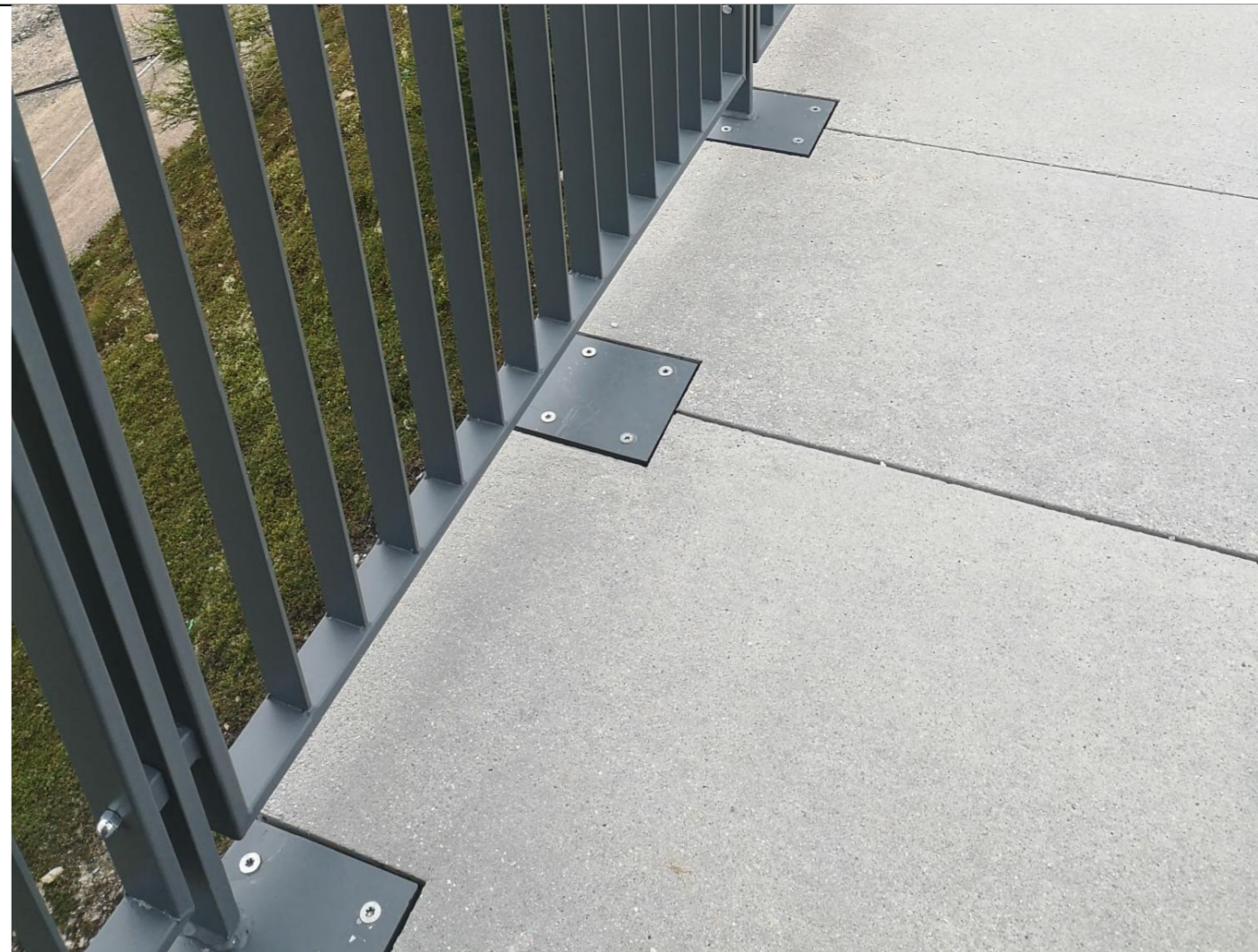
RIFERIMENTO FOTOGRAFICO PER LA POSA DELLA PIASTRA AL CALCESTRUZZO
