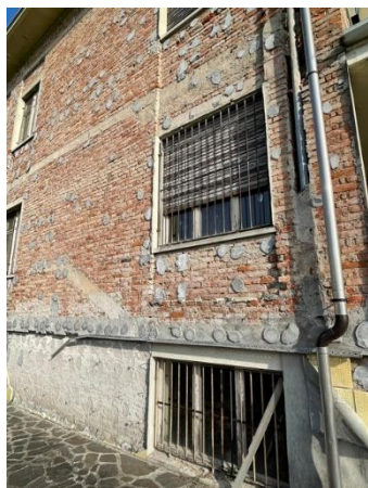
Figura 6 - Vista strutture in C.A. e mattoni pieni
