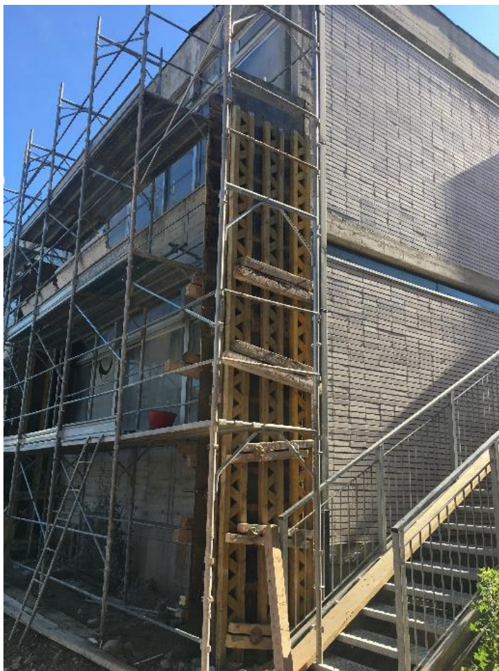
Figura 26 Intervento di rinforzo dei nodi strutturali
