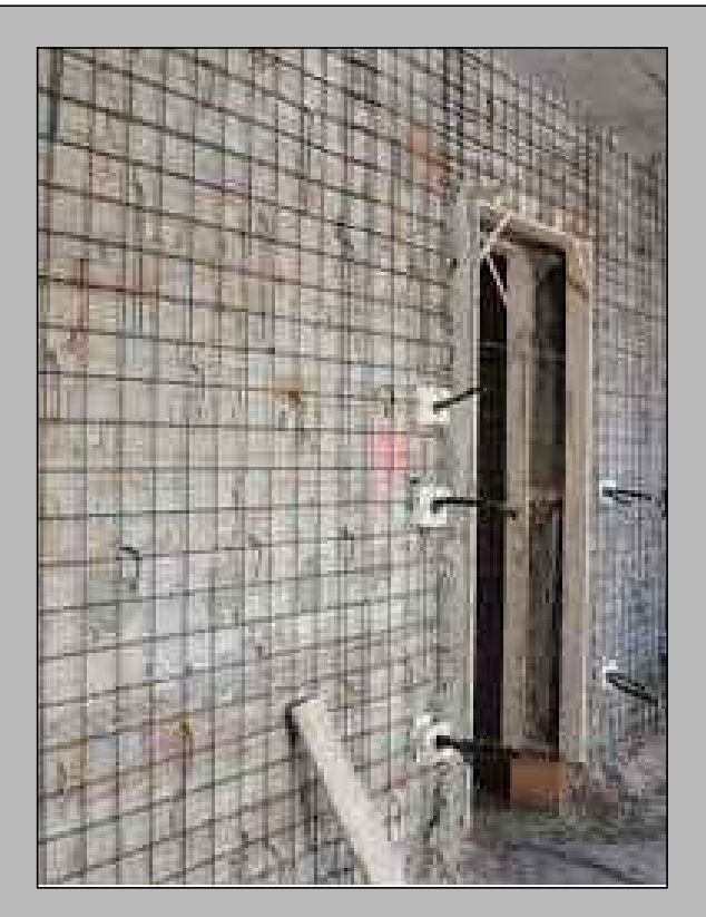
Particolare intonaco armato
