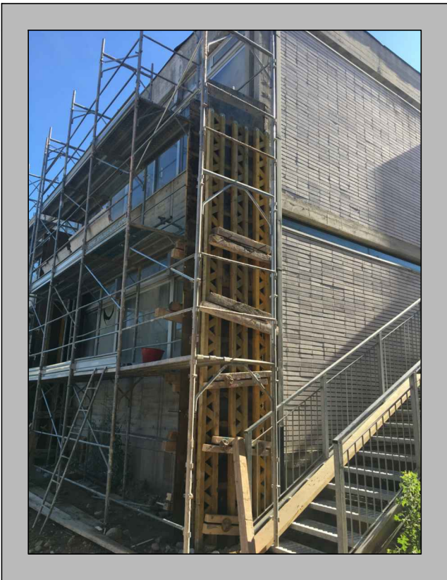
Intervento di rinforzo dei nodi strutturali
