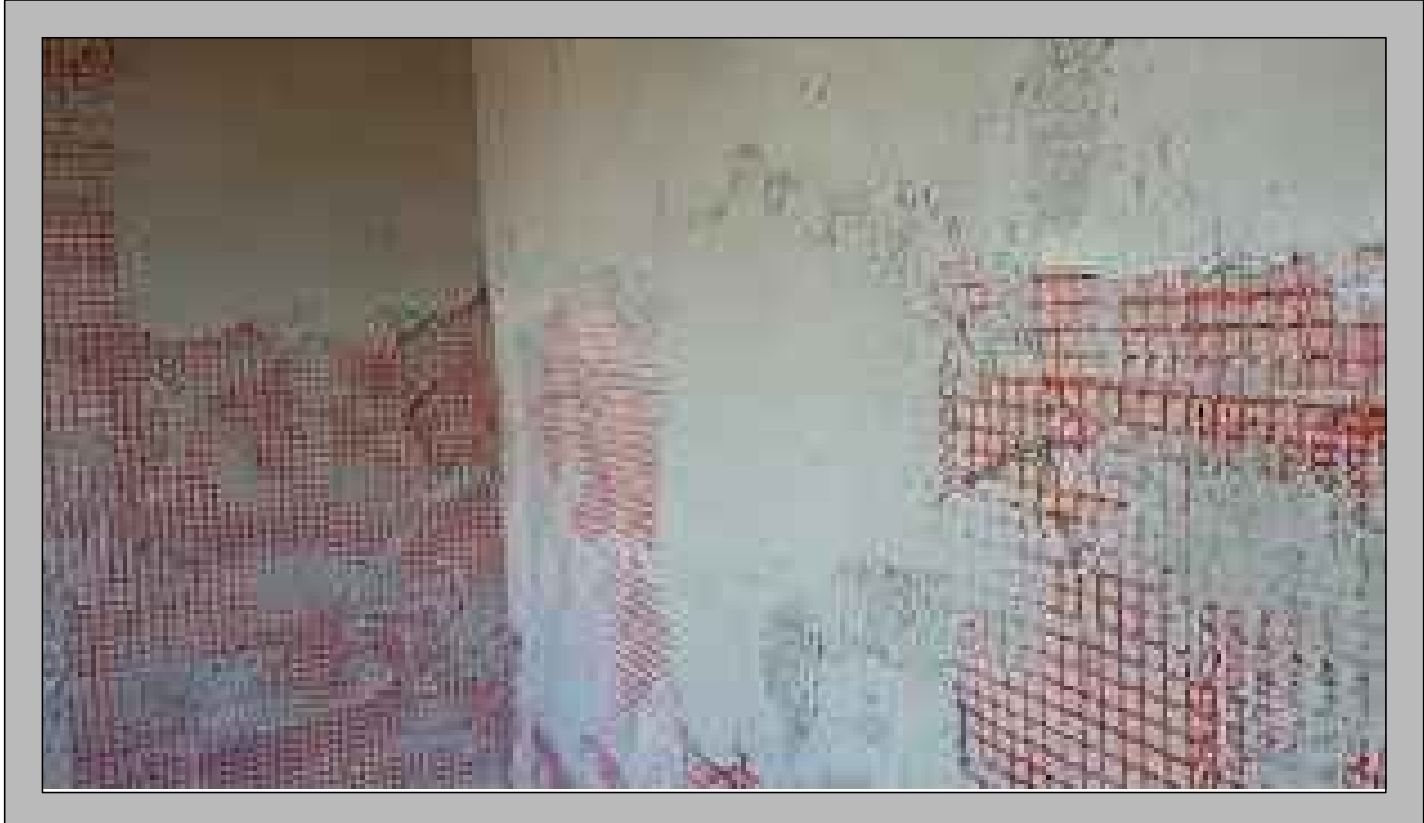
Particolare intonaco armato
