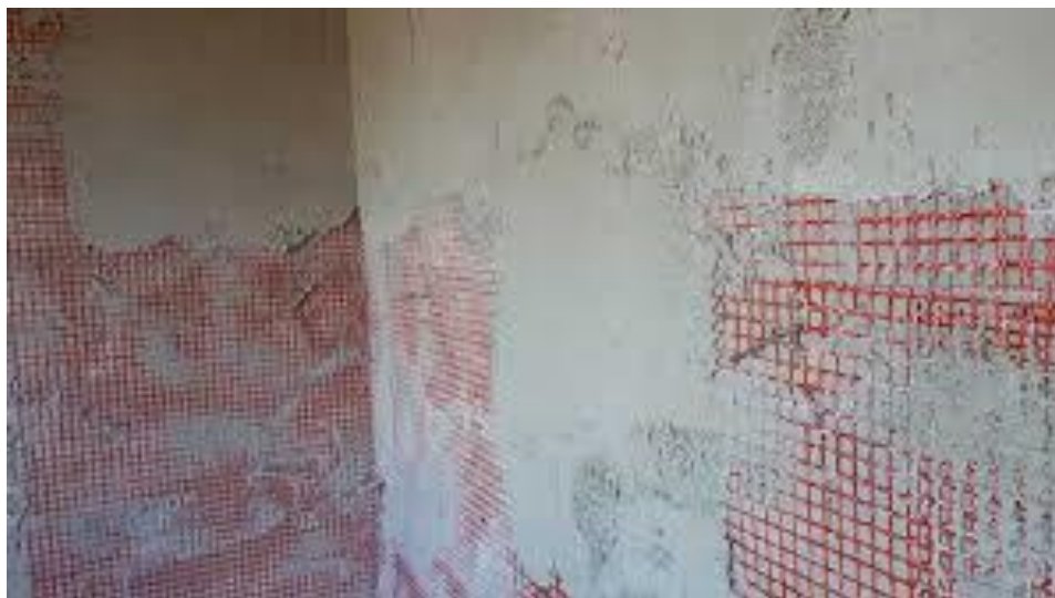
Figura 24 Particolare intonaco armato
