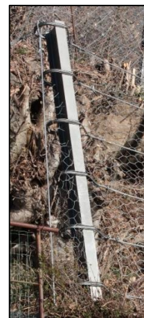
Montante con profilo a C (passacavo) saldato (tipico di barriere "travi e funi") (*)
