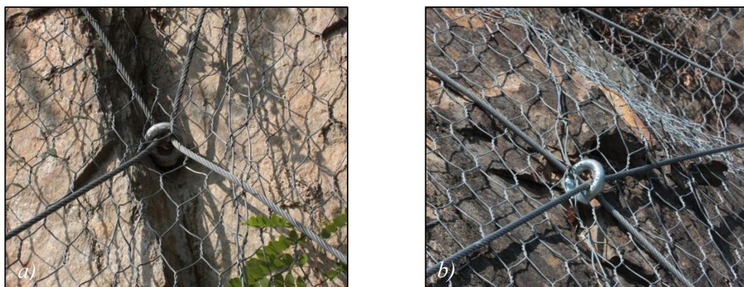
Figura 82: a) Esempio di errata installazione delle funi di rinforzo (Fonte: Caso studio); b) Esempio di una corretta installazione delle funi di rinforzo (Fonte: Caso Studio).
