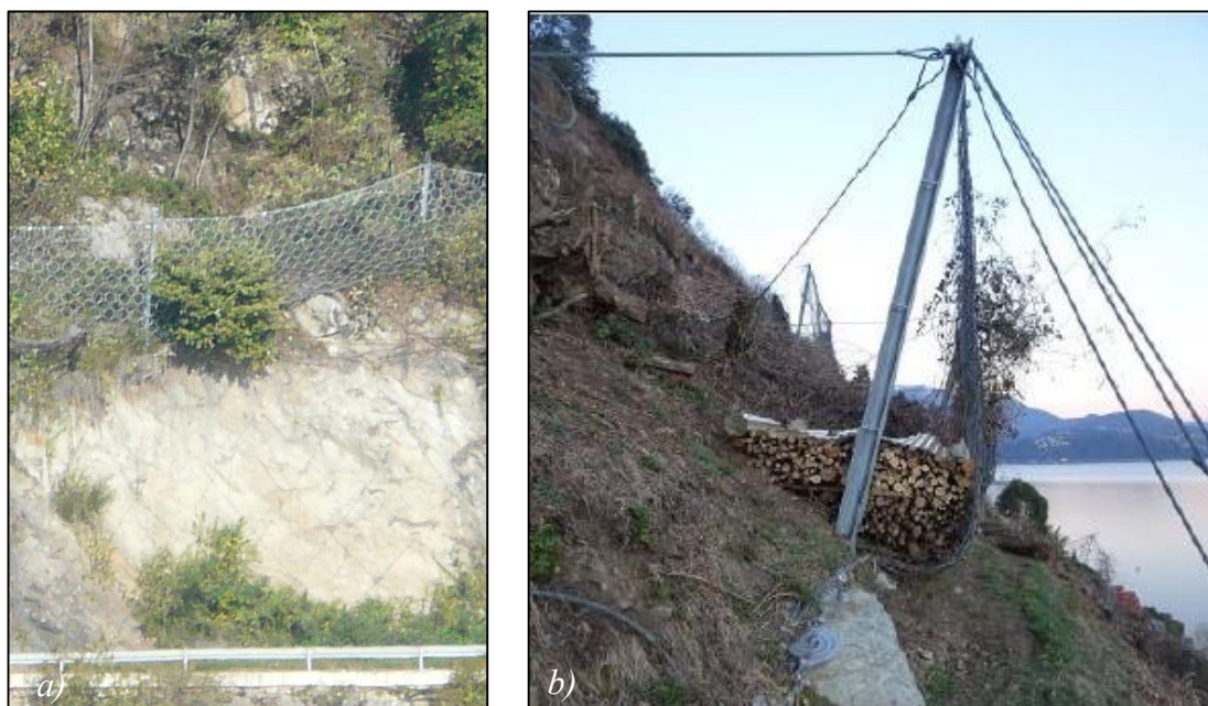
Figura 55: a) Esempio di specie vegetale arbustive posta a valle dell'opera (Fonte: Caso Studio); b) Esempio di stoccaggio di legname da parte di un privato all'interno della campata di una barriera paramassi (Fonte: report fotografico di Cargnel, O., in merito al Caso Studio).
