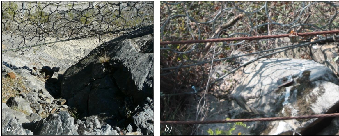
Figura 73: a) Esempio di varco al piede chiuso con la posa in opera di una rete a doppia torsione (Luciani, 2015); b) Esempio di varco al piede chiuso obbligando la fune longitudinale inferiore a transitare in un passacavo intermedio (Fonte: Caso Studio).
