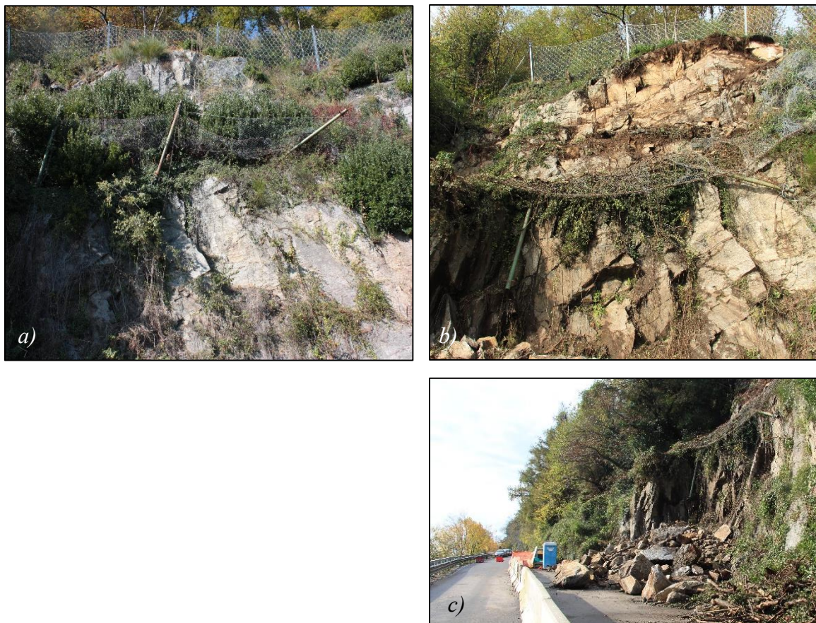
Figura 101: Fenomeno di crollo nella scarpata di controripa della S.S. 34 del Caso Studio. La condizione pre-crollo è riportata in (a), quella post-crollo in (b) e (c).
