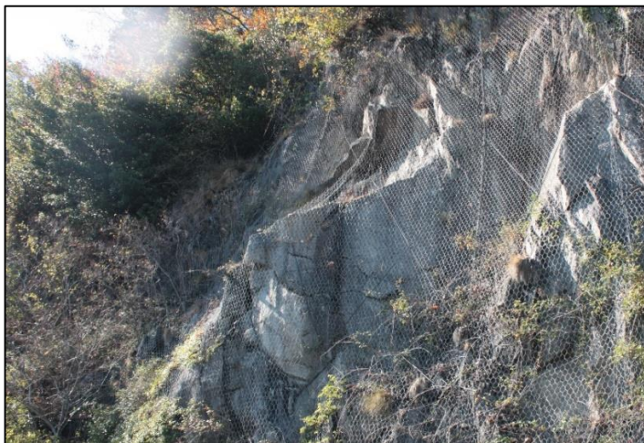
Figura 80: Esempio di una rete rinforzata installata con una maglia delle funi di rinforzo eccessiva (Fonte: Caso Studio).
