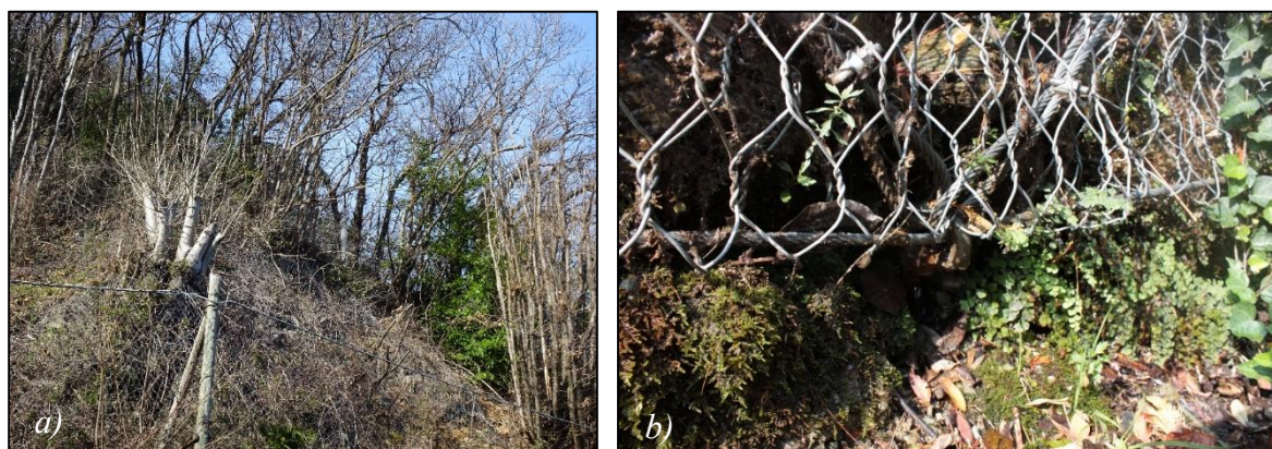
Figura 76: a) Esempio di una specie arbustiva cresciuta inglobando la rete soprastante (Fonte: Caso Studio); b) Esempio di emergenza idrica su una parete rocciosa che ha comportato il parziale arrugginimento di un ancoraggio (Fonte: Caso Studio).
