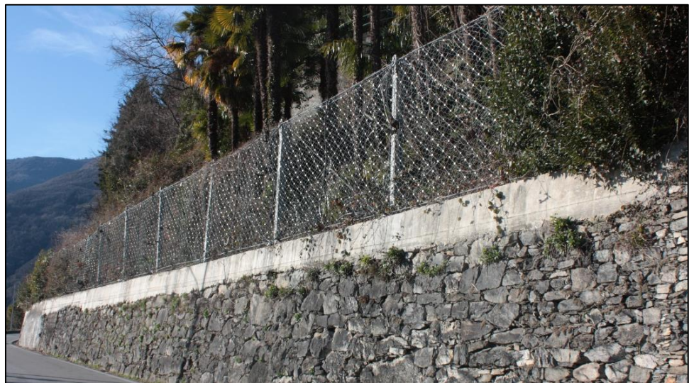
Figura 30: Esempio di una barriera a ridotta deformabilità, nel dettaglio barriera a pannelli di fune con borchie, tratto dal Caso Studio del seguente elaborato.
