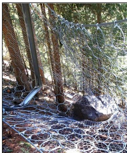
Figura 68: Esempio di abbattimento del montante a causa di un blocco impattante (Cardinali, 2016)
