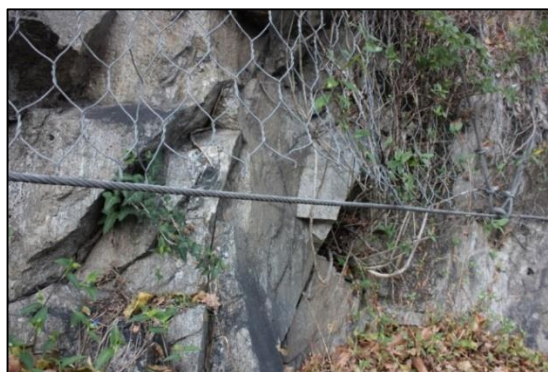
Figura 83: Esempio di vuoto al piede della rete (Fonte: Caso Studio).
