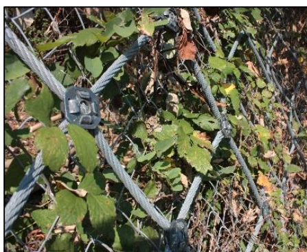
Rete principale: pannelli di fune con borchie modello HCP
