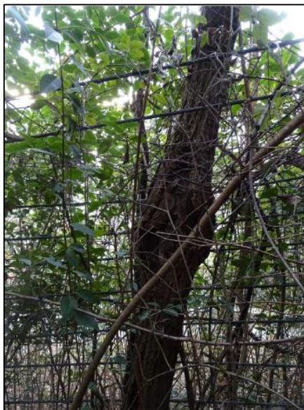
Figura 75: Esempio di crescita di una pianta a medio fusto tra la struttura di intercettazione con formazione di un varco (Fonte: report fotografico di Cargnel, O., in merito al Caso Studio).
