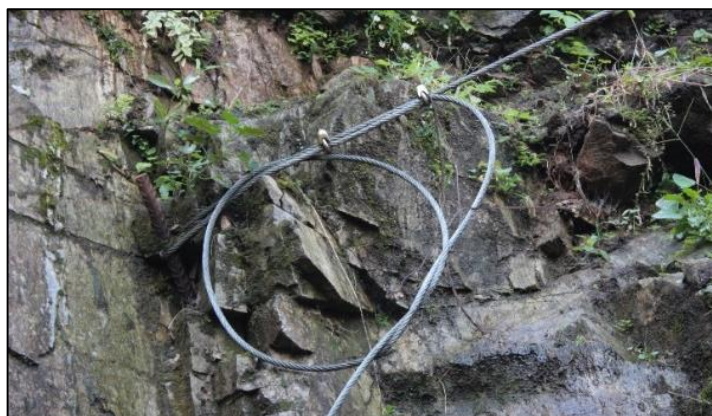
Figura 60: Esempio di una installazione della fune di controvento di monte con relativo ancoraggio non idoneo (Fonte: Caso Studio).
