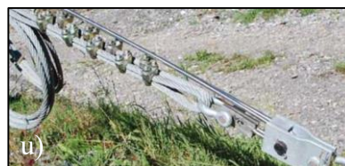
GEOBRUGG: freno ad attrito e deformazione materiale (****)
