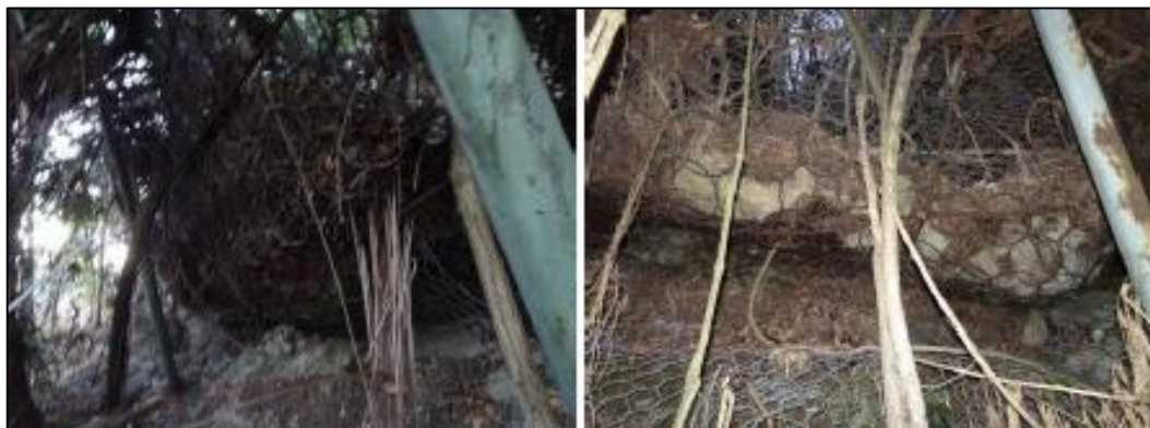
Figura 72: Esempio di accumulo di materiale detrito e specie vegetali a monte della struttura di intercettazione (Fonte: report fotografico Cargnel, O. relativo al Caso Studio).
