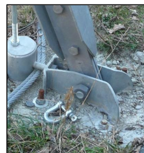
Piastra di base e cerniera monodirezionale (**)
