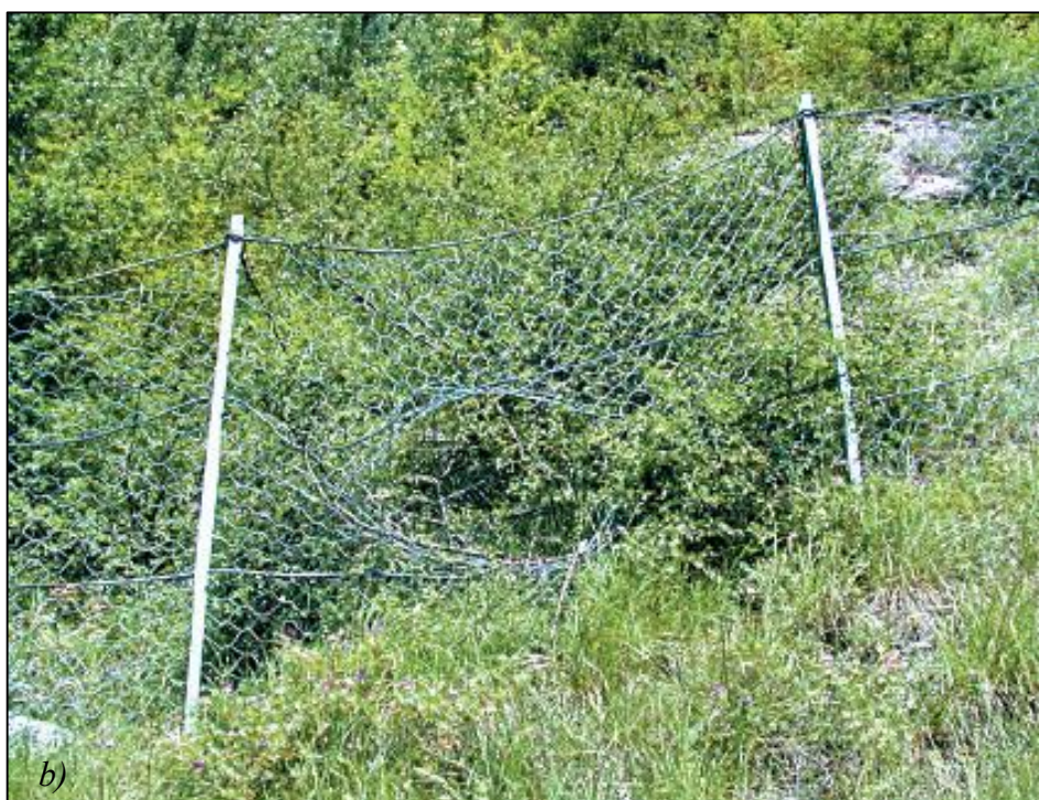
Figura 66: a) Esempio di deformazione della struttura di intercettazione a causa dell'impatto con un blocco (Fonte: Caso Studio); b) Esempio di perforazione di una barriera paramassi a seguito di un blocco di energia > MEL (Guillemin, 2009).
