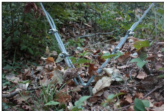
Figura 63: Esempio di morsetti delle funi di controvento di monte in numero non idoneo e mal distanziati (Fonte: Caso Studio).
