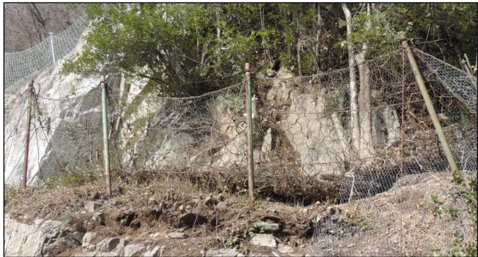
Figura 28: Esempio di una barriera ad elevata deformabilità, nel dettaglio barriera IPER-EL in uno stato di completo ammaloramento, tratto dal Caso Studio del seguente elaborato.
