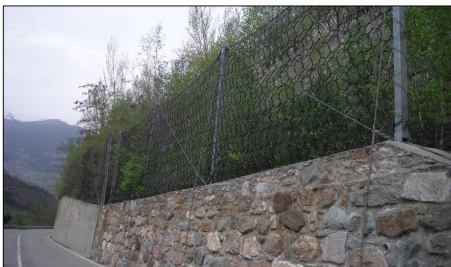
Figura 57: Barriera ad elevata deformabilità installata a bordo strada (Luciani, 2015).
