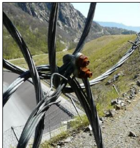
Figura 74: Esempio di inserimento di un vincolo rigido (morsetto) come intervento manutentivo di una rete principale ad anelli con rottura dell'anello a seguito di un impatto (Fonte: Luciani, 2015).
