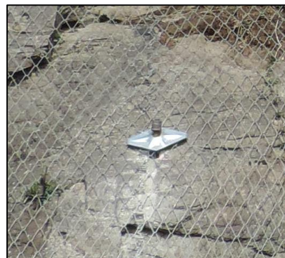
Sistema TECCO: rete a singolo filo a singola torsione con dettaglio della piastra di ripartizione e del dado di serraggio dell'ancoraggio (**)
