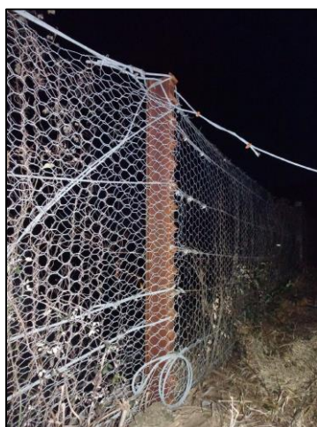
Figura 65: Esempio di una errata installazione delle funi metalliche longitudinali di una barriera "travi e funi" (Fonte: report fotografico Cargnel, O. relativo al Caso Studio).
