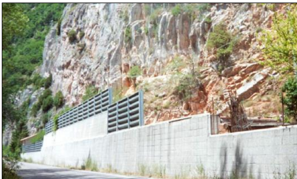
Figura 31: Esempio di una barriera rigida a protezione sul coronamento di un muro in c.a. (APAT, 2002).
