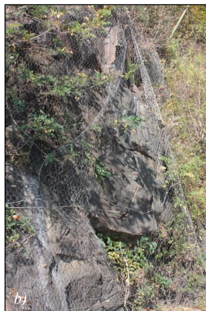
Figura 84: a) Esempio di lacerazione della rete dovuto ad un impatto pregresso (Fonte: Caso Studio); b) Esempio di una importante apertura tra due pannelli di rete (Fonte: Caso Studio).
