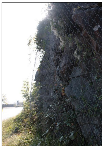
Figura 79: Esempio di una rete TECCO non aderente al versante (Fonte: Caso Studio).
