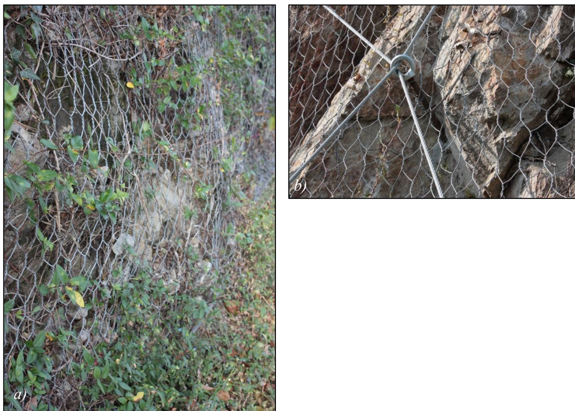
Figura 85: a) Esempio di accumulo di materiale detritico all'interno della rete di contenimento (Fonte: Caso Studio); b) Esempio di sfilamento di un ancoraggio delle funi di rinforzo di una rete rinforzata (Fonte: Caso Studio).
