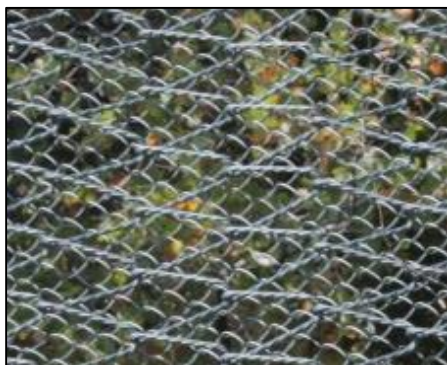
Rete principale: rete spiroidale
