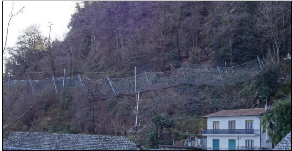
Figura 27: Esempio di vari stendimenti di una barriera ad elevata deformabilità tratto dal Caso Studio del seguente elaborato.
