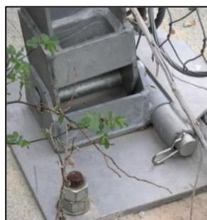
Piastra di base e cerniera bidirezionale (**)
