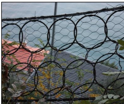
Rete principale: rete ad anelli metallici del tipo parasiluri
