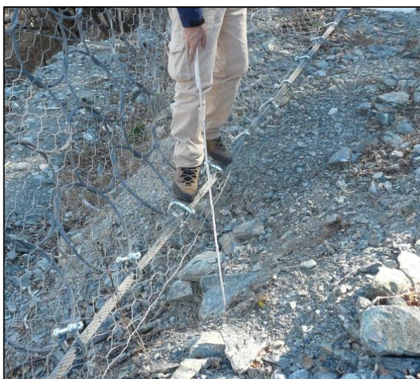
Figura 62: Esempio di varco al piede della rete dovuto ad una errata installazione della barriera (Luciani tesi).
