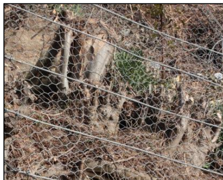
Rete principale: rete a pannelli di funi metalliche longitudinali
