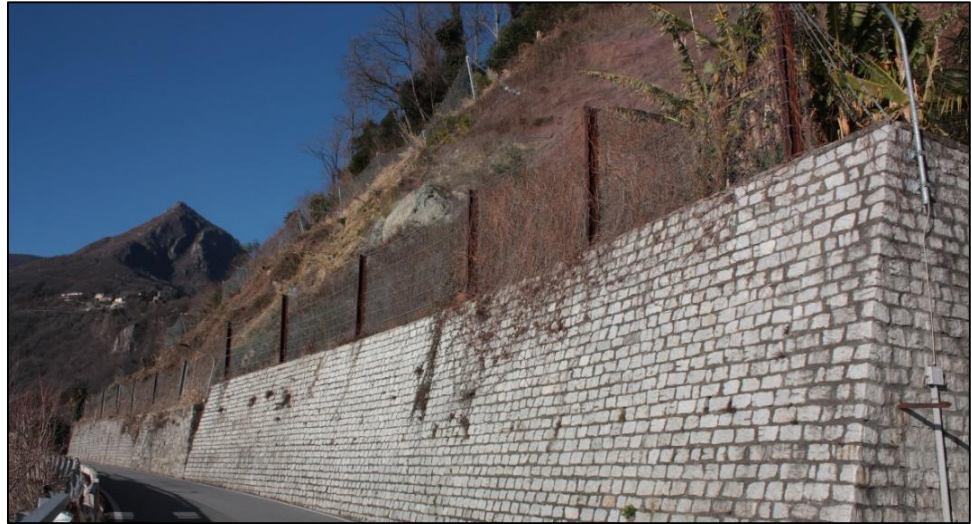
Figura 29: Esempio di una barriera ad ridotta deformabilità, nel dettaglio “barriera travi e funi”, tratto dal Caso Studio del seguente elaborato.
