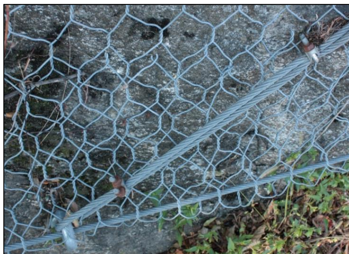
Figura 86: Esempio di giunzioni in numero non idoneo, con elevato interasse e con dadi arrugginiti delle funi di rinforzo di una rete rinforzata (Fonte: Caso Studio).
