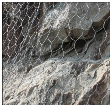
Rete a singolo filo a maglia esagonale (doppia torsione) (**)
