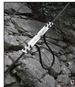
CLIOS: Freno a deformazione materiale + attrito (*)
