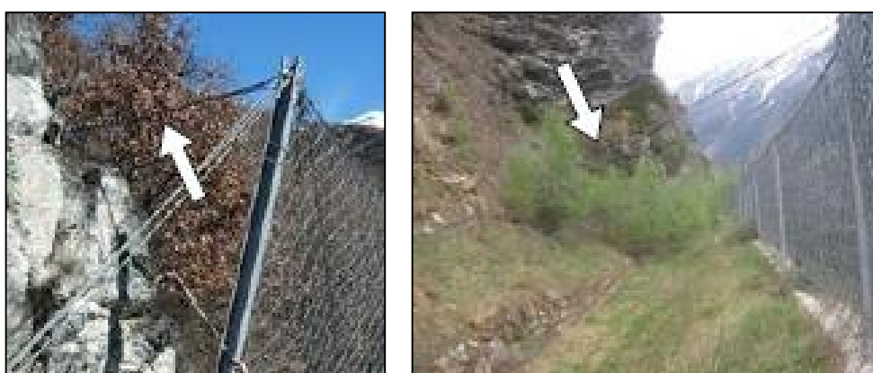
Figura 58: Esempi di funi di controvento di monte non correttamente installate (Dimasi et al., 2015).
