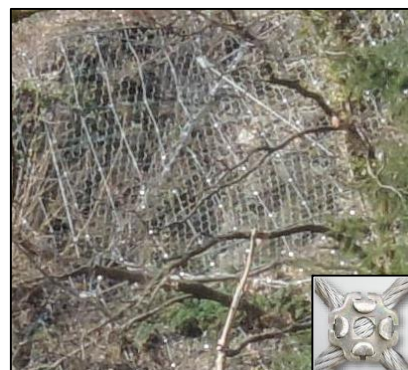
Rete a pannelli di fune d'acciaio con borchie a clip (modello HCP) (**)
