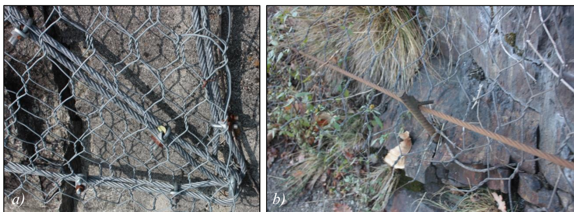
Figura 81: a) Esempio di una non corretta giunzione delle funi di una rete rinforzata (Fonte: Caso Studio); b) Esempio di un ancoraggio in barra d'armatura non ripiegata relativo alla fune di sostegno al piede (Fonte: Caso Studio).
