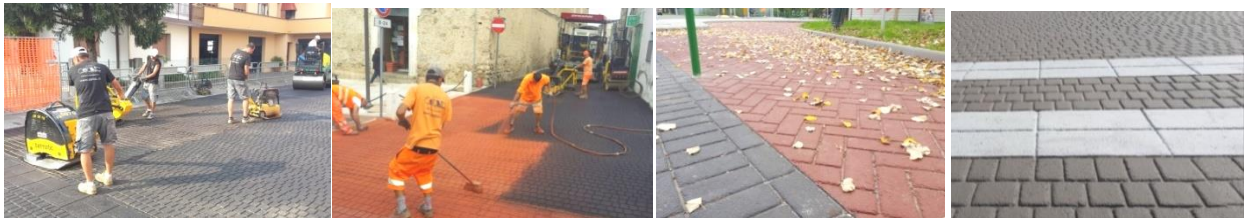
Pavimentazione in asfalto impresso: 1 - Fase di imprimitura con matrici 2 - Fase di resinatura 3 e 4 - Esempi di pavimentazioni
