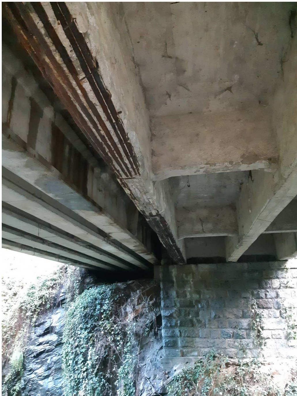
Figura 6 - Stato di dissesto delle strutture porzione a Monte
