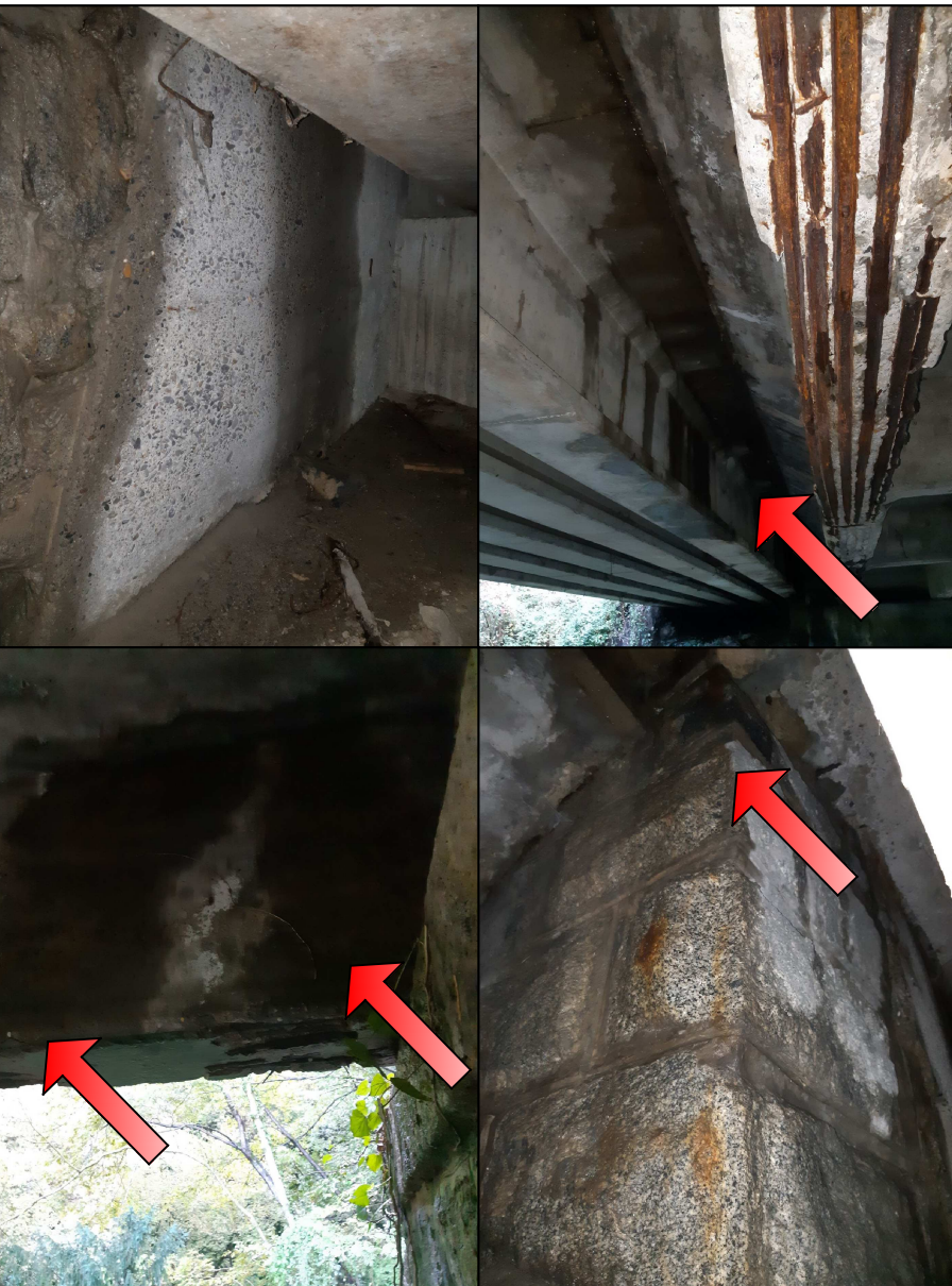
D5 Infiltrazioni acqua ammaloramento calcestruzzo
