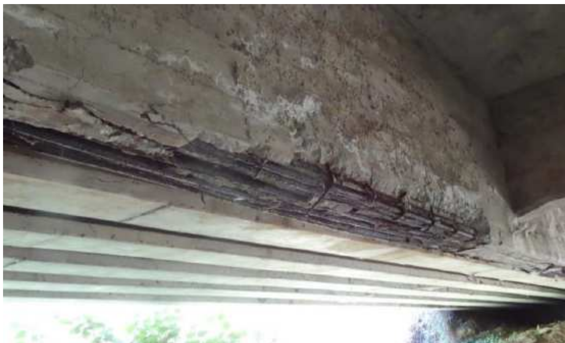
Figura 7 - Stato di dissesto delle strutture porzione a Monte
