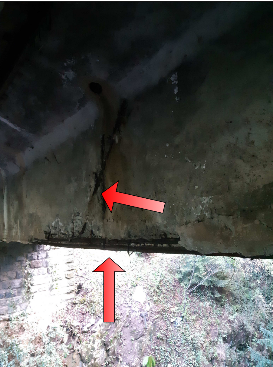
D3 Distacco completo del copriferro. Avanzata corrosione delle armature al lembo teso. Rottura staffe.
