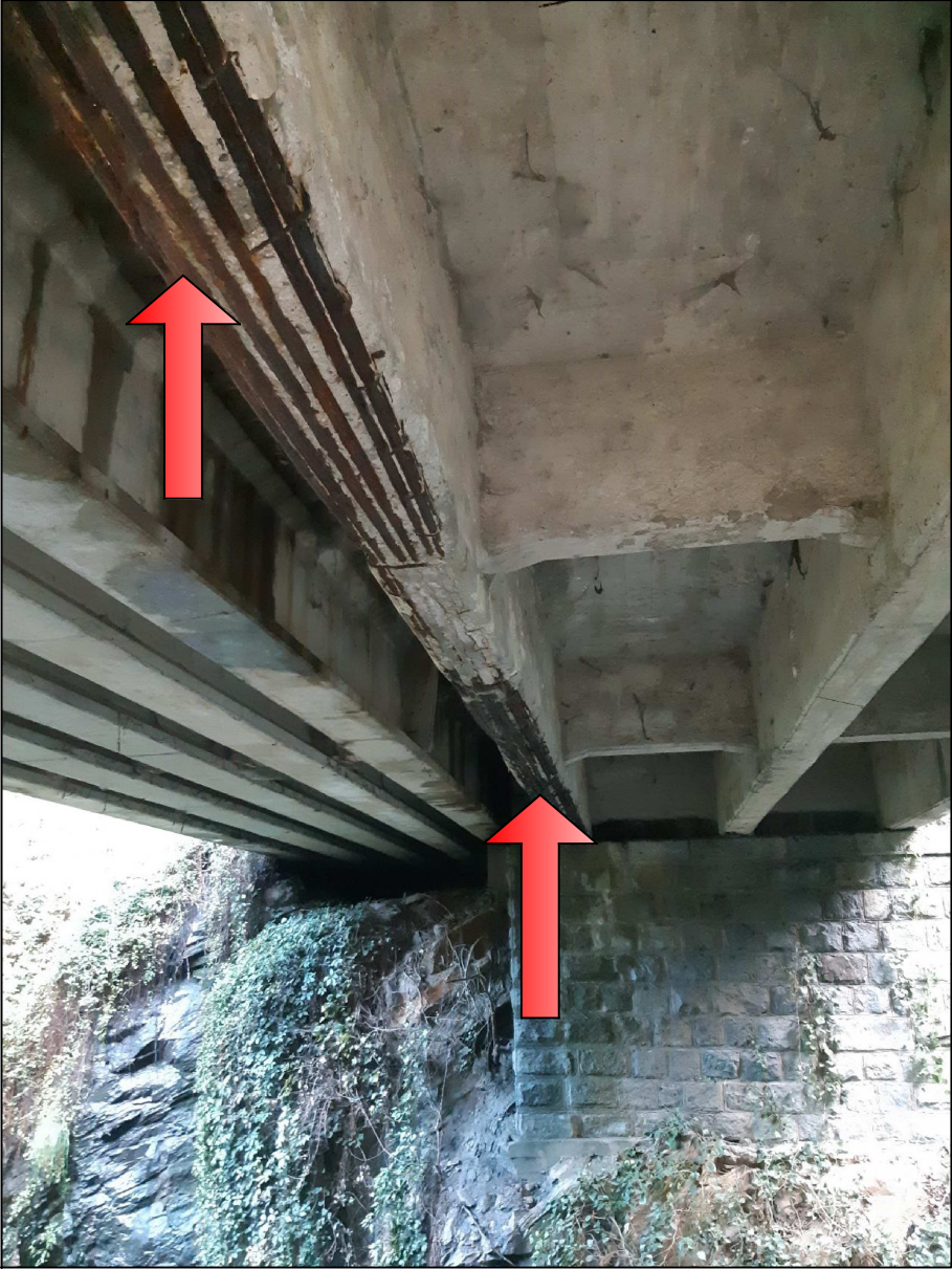
D5 Infiltrazioni acqua ammaloramento calcestruzzo
