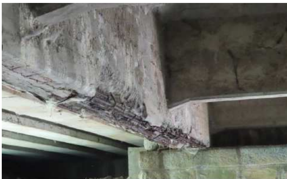
Figura 8 - Stato di dissesto delle strutture porzione a Monte
