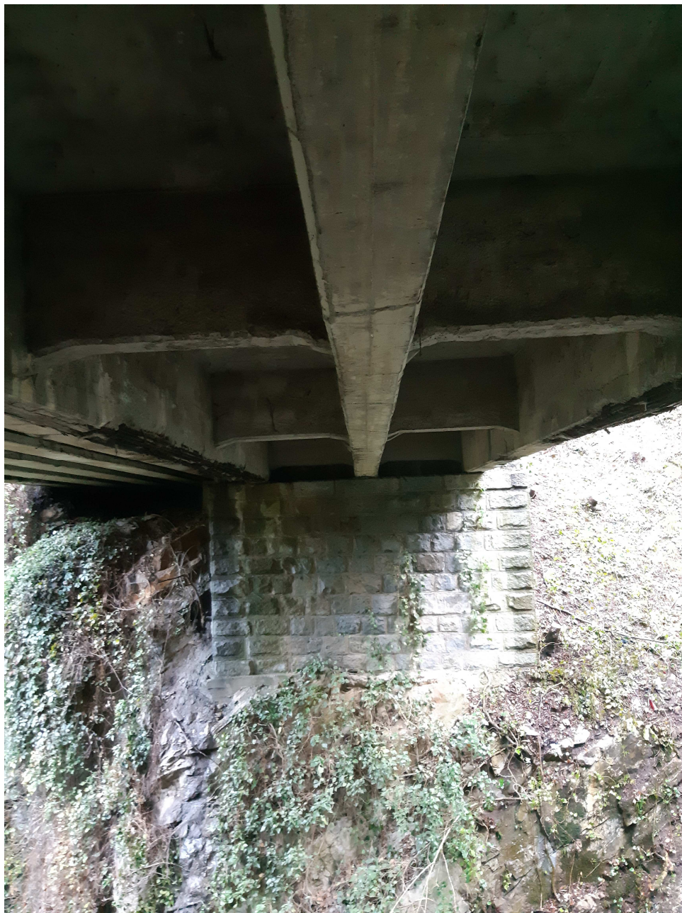
Figura 9 – Spalle in Tonalite dell'Adamello, si nota il buono stato di conservazione
