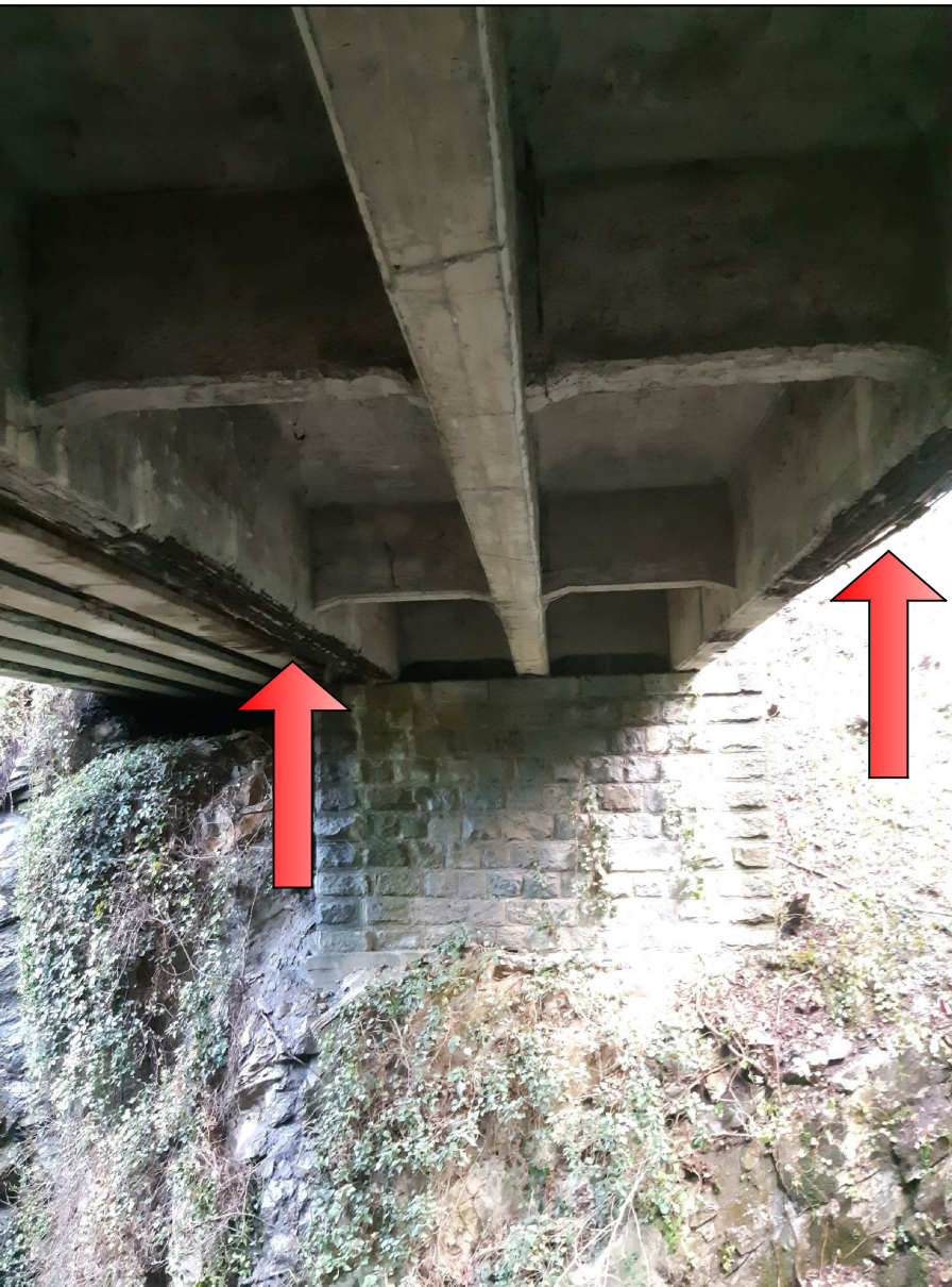
D2 Distacco completo del copriferro. Avanzata corrosione delle armature al lembo teso. Rottura staffe.
