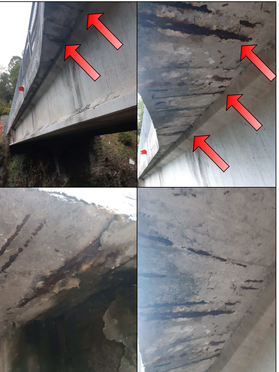
D7 Corrosione ferri cordolo lato valle
