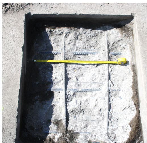
fig. 37. Armatura trasversale pulvino – asse pila – sez. B-B
