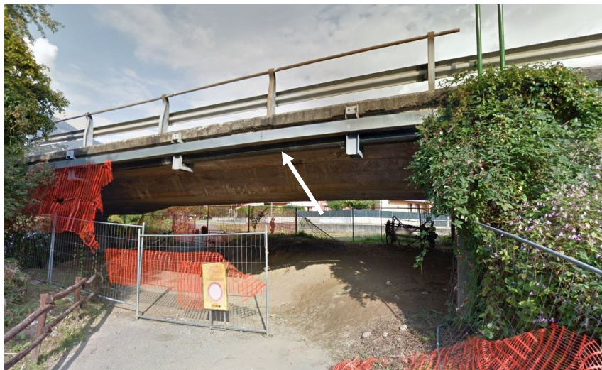
fig. 1. Vista interferenza linea gas metano e fibra ottica lato ponte a valle.
