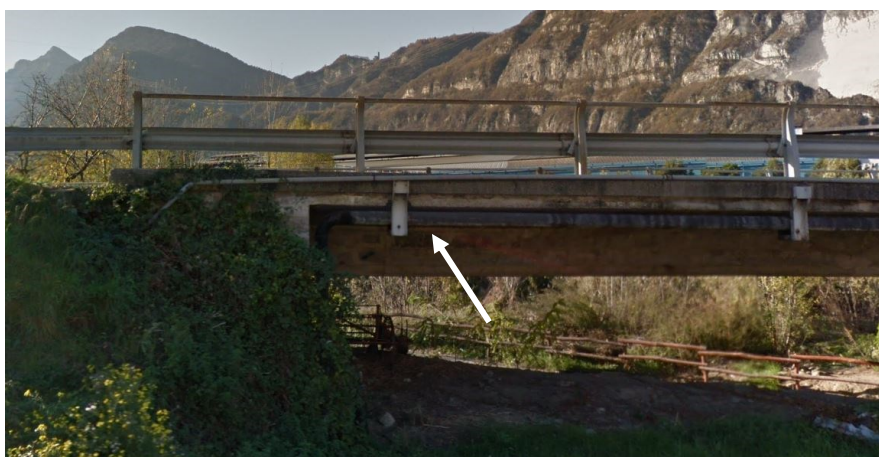
fig. 2. Vista interferenza linea gas metano e linea elettrica (illuminazione rotatoria a Nord) lato ponte a monte.
