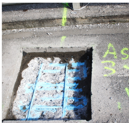
fig. 37. Armatura trasversale pulvino – asse pila – sez. B-B
